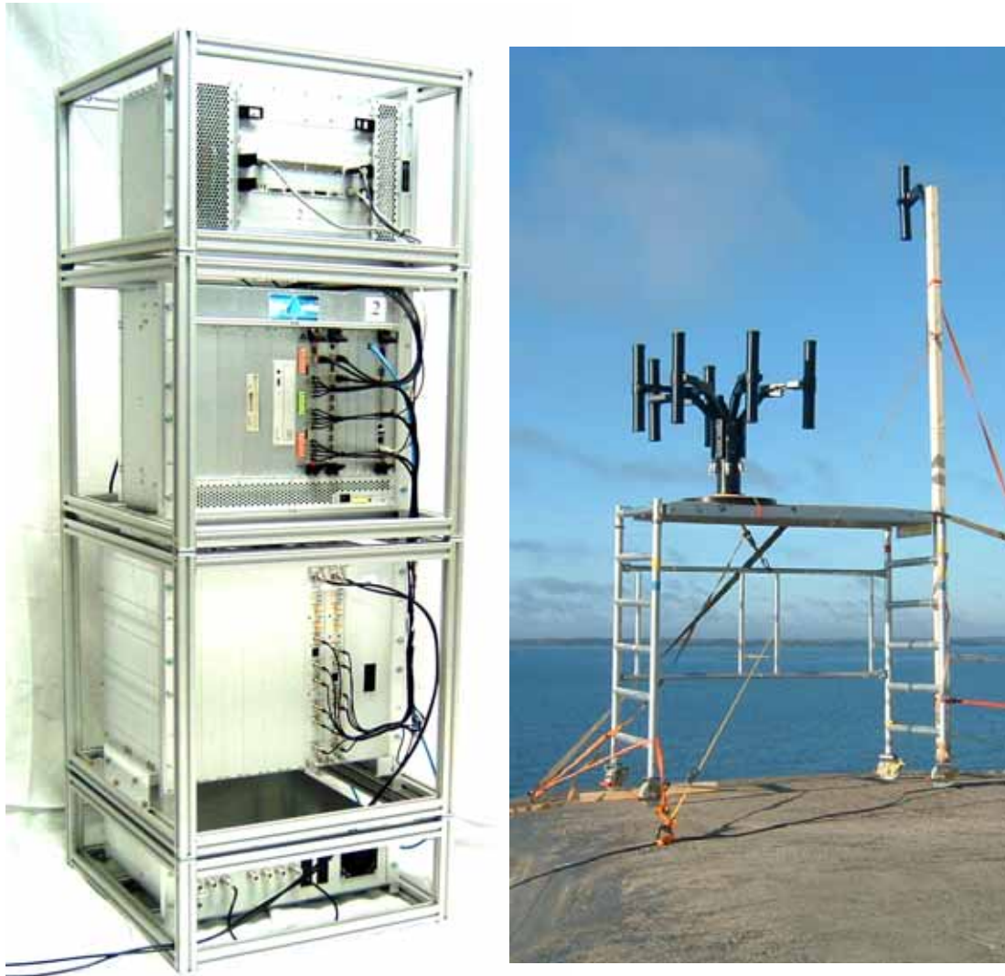
Kuva 93: Vasemmalla ohjelmistoradiodemonstraattorin laitteisto ja oikealla radion adaptiivinen antenni kiinnitettynä tilapäisvirityksin rannikkolinnakkeelle mittauksia varten. [Elektrobit]
