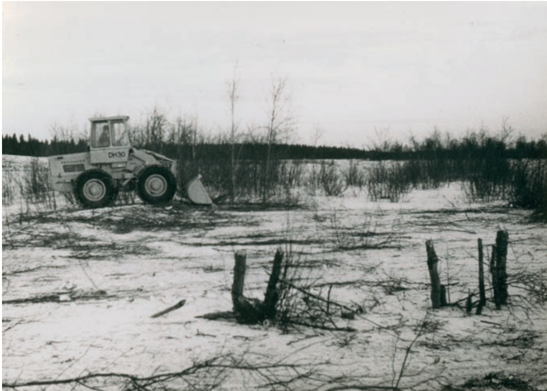
Kuljunlahden makeavesialtaan rakennustyöt olivat käynnissä keväällä 1964. (POHJOIS-POHJANMAAN ELY-KESKUS)
