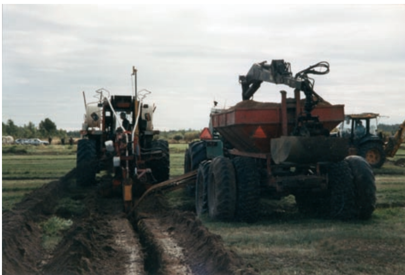
Kalkkisuodinoitusta Limingan Heiskarin tilalla syksyllä 1995. (POHJOIS-POHJANMAAN ELY-KESKUS)
