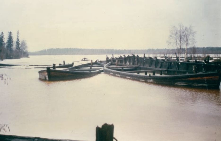
Haukiputaan Santaholman rannan vanhat lastiveneet 1980-luvun alussa. Santaholman asuinalue kunnostettiin 1980-luvun lopulla. (POHJOIS-POHJANMAAN ELY-KESKUS)
