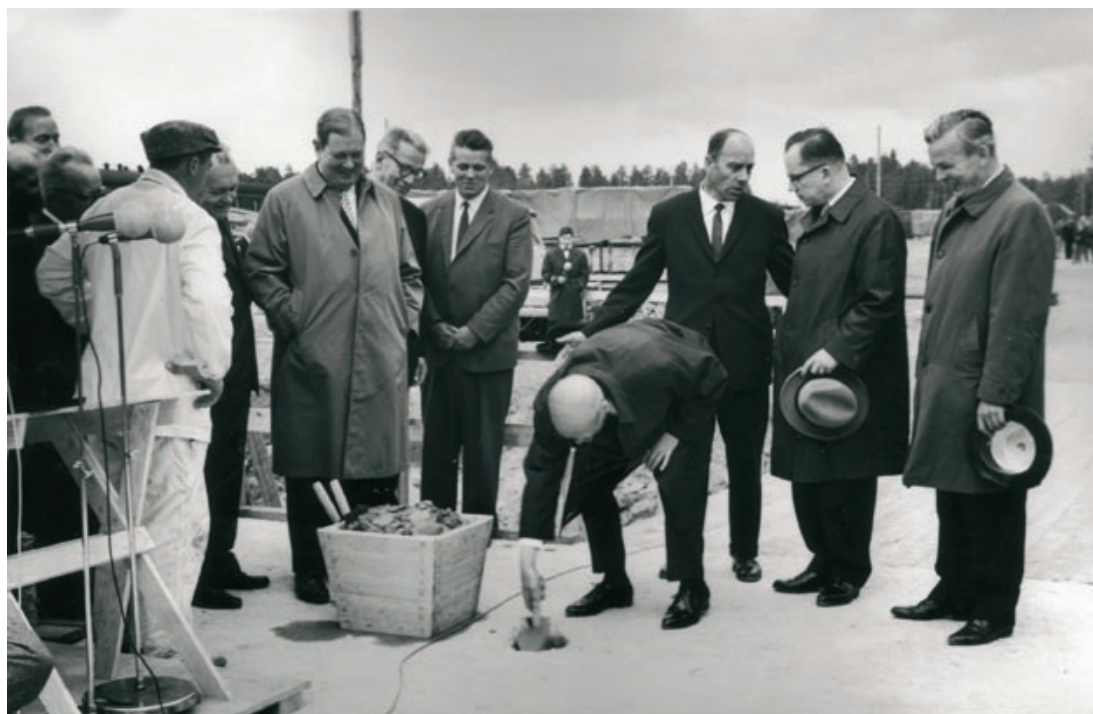
Tasavallan presidentti Urho Kekkonen suoritti Rautaruukin masuunin peruskiven muurauksen vuoden 1962 elokuussa. (RAUTARUUKKI OY:N KOKOELMA)
