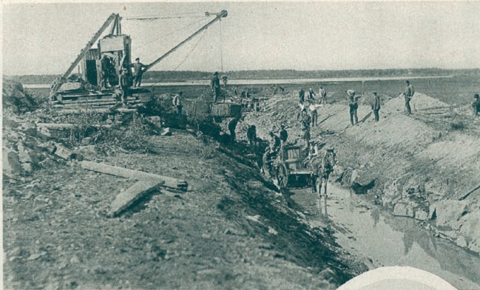
Alavieskan järven rannalla, paikalla, josta kutoatusoja lähtee. Työt parhaillaan käynnissä.
