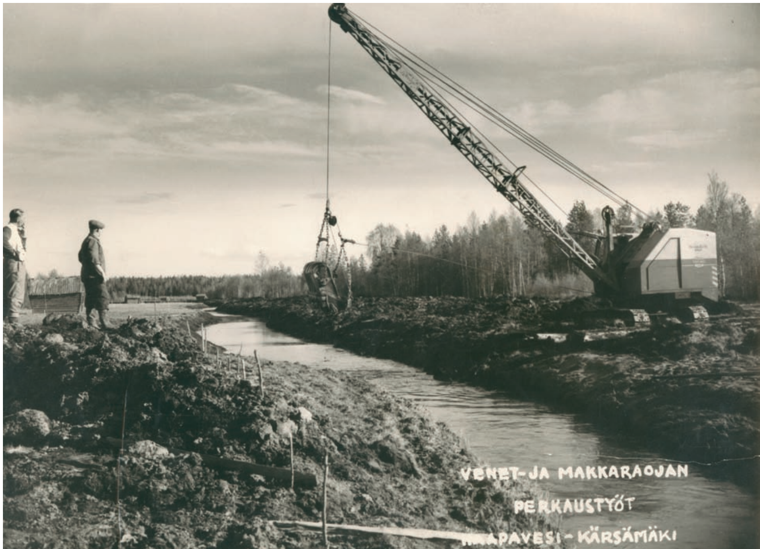
Venet- ja Makkaraojan perkausta Haapaveden ja Kärsämäen alueella tehtiin vuosina 1957–1959 jo konevoimalla. (POHJOIS-POHJANMAAN ELY-KESKUS)
