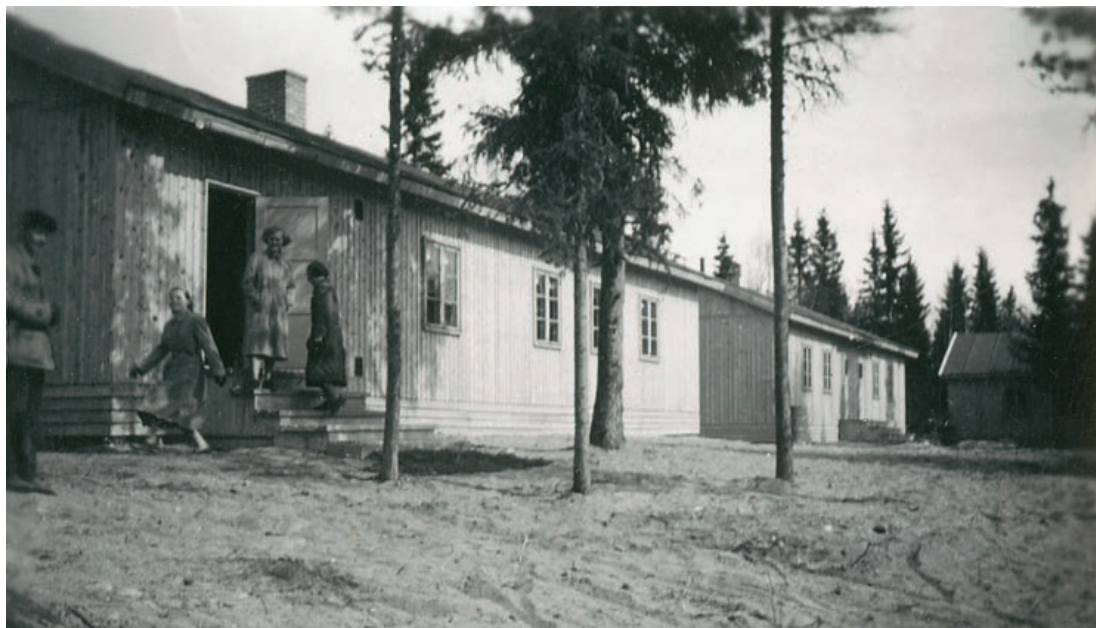
Maanviljelysinsinööripiirin parakkeja Pyhäjoen tulvasuojelutyömaalla 1950-luvulla. (POHJOIS-POHJANMAAN ELY-KESKUS)
