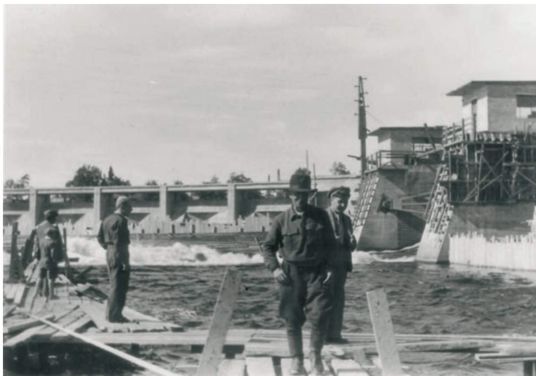
Merikosken poikki-padon rakennustyömaata vuonna 1948, jolloin pato saatiin myös valmiiksi. (OULUN MAAKUNTA-ARKISTO)
