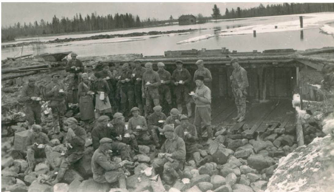
Kahvitunti Vihanninjoen perkaustyömaalla ilmeisesti 1940-luvulla. (POHJOIS-POHJANMAAN ELY-KESKUS)
