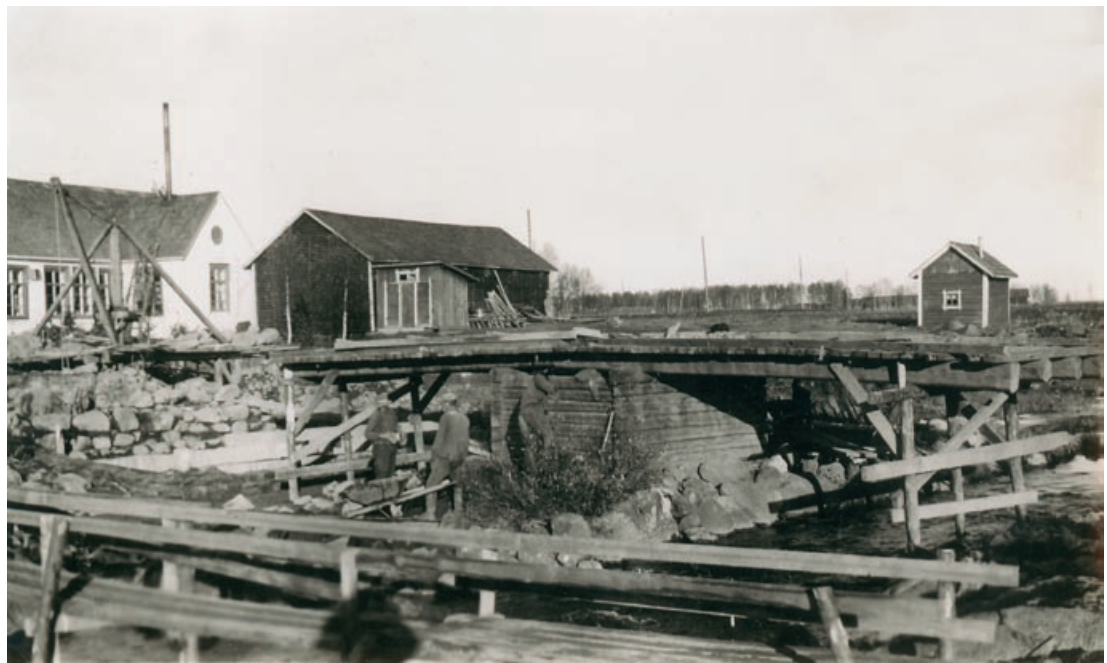
Nivalan Malisjoen perkaustyömaa 1937–1938. (POHJOIS-POHJANMAAN ELY- KESKUS)
