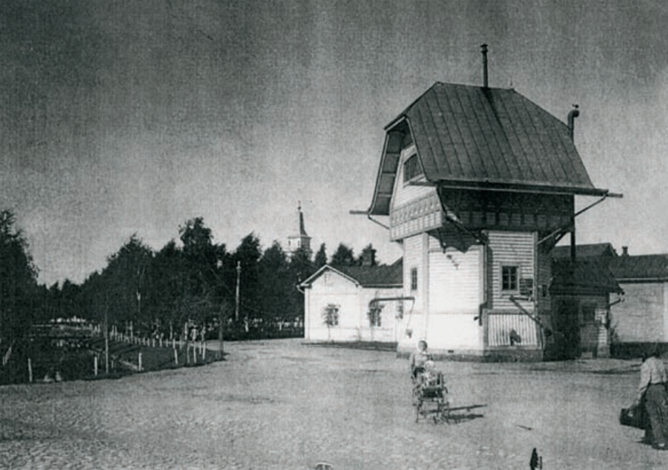
Oulun vesilaitoksen vesiposti 1900-luvun alussa. (OULUN MAAKUNTA-ARKISTO)
