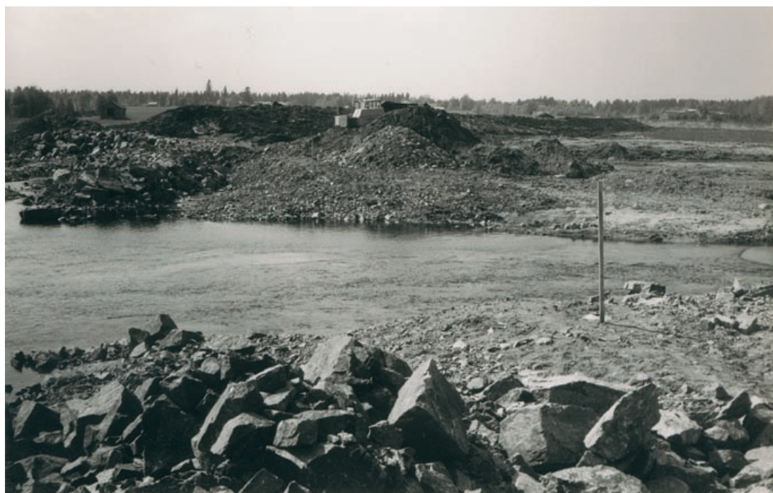
Viemärintöitä Pattijoella 1970-luvun lopulla. (POHJOIS-POHJANMAAN ELY-KESKUS)
