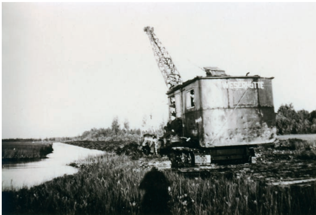
Limingan Heinijärven Kiiskilänkylän Kiiskilänjärven kuivatus 1960-luvulla. Kaivinkone kaivaa kuivatuskanavaa. Järveä kuivattiin ensimmäisen kerran jo 1800-luvulla muiden liminkalaisten järvenkuivauksien yhteydessä. Laahakaivinkoneessa tarvittiin pitkä puomi kaivamisesta suoriutumiseen ja raskas kaivinkone tarvitsi myös telojensa alle puiset tukeista tehdyt laakongit, joita siirrettiin koneen siirtyessä eteenpäin. (MARKKU KUORILEHDON KOKOELMA)
