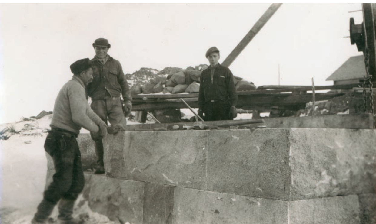
Siiponjoen perkauksen yhteydessä tehtiin myös jatkosodan vuosina kiviset silta-arkut. Kuva on Rautios-ta vuodelta 1942.
