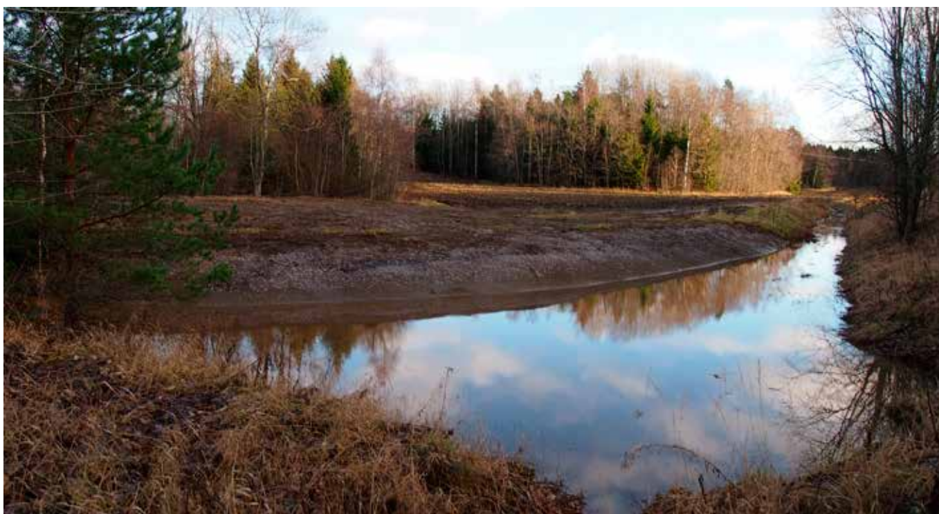
Maatalousuomien luonnonmukaisilla peruskunnostustoimenpiteillä kuten kuvan kaltaisilla loivennetuilla luiskilla, pienkosteikoilla ja tulvatasanteilla, saadaan esimerkiksi tulvahaittoja vähennettyä. Tämä hyödyttää myös pellonvuokraajaa. Kuva: Katariina Yli-Heikkilä
