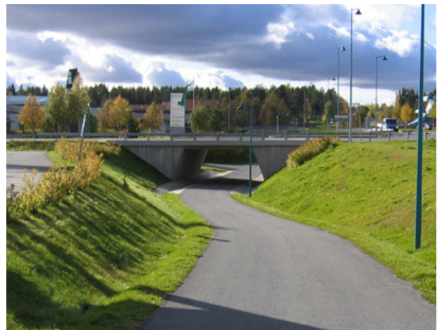
Kuva 19. Nykyaikainen betonirakenteinen kevyen liikenteen alikulku (kuva Kuusamosta).
