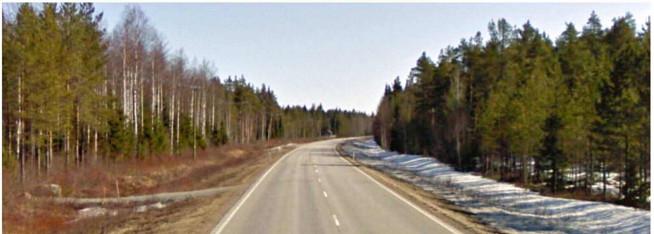
Kuva 14. Valtatiellä 27 on loivat sivuojen luiskat, (kuva Alavieskasta, Google).
