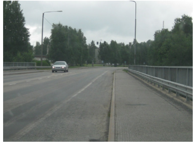
Kuva 13. Siltakadun sillalla on kapea jalkakäytävä.
