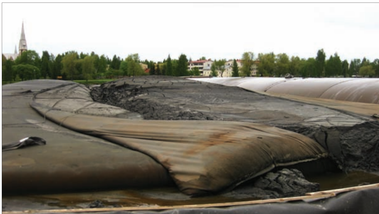
Joensuun tulevaa asuinalueita Penttilänrannassa, etualalla tukkialtaan pilaantuneiden pohjalietteiden käsittelyä geotuubeissa. Kuva Mika Pirinen.
