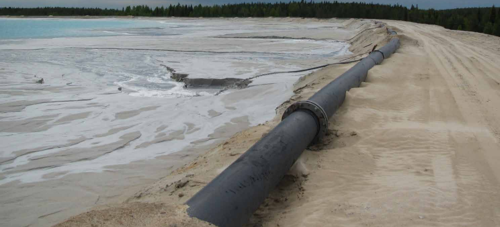
Rikastushiekalla korotettu kaivospato, 2012 (Timo Regina)
