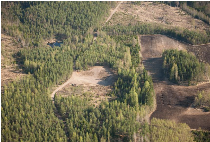
Kuva 8.4.5. Vanha maa-ainestenottoalue kiinteistöllä 6:17. Kuva: Hannu Vallas, Lentokuva Vallas Oy. 14.5.2010.
