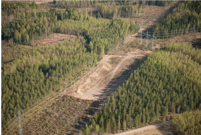
Kuva 8.4.2. Vanha maa-ainestenottoalue kiinteistöllä 27:4.
