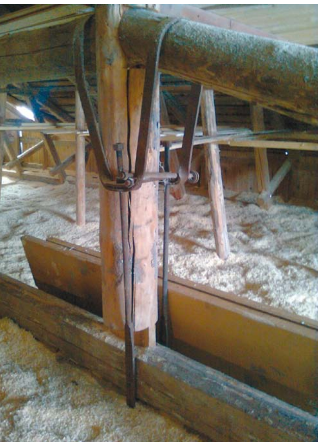
Puru käy yläpohjan eristeeksi hyvin edelleen. Kuva Matti Pollari
