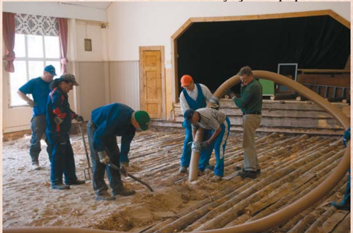
Lattian eristeiden poistoa talkooporukan voimin. Kuva Jaakko Kirjasniemi
