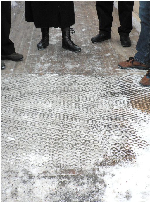
Kuva 34. Luiskaan asennetun teräsverkon ansiosta luiska ei ole liukas.
