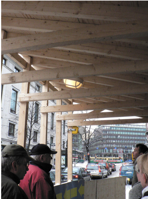
Kuva 43. Katettu väylä suojaa ylhäältä putoavilta materiaaleilta.
