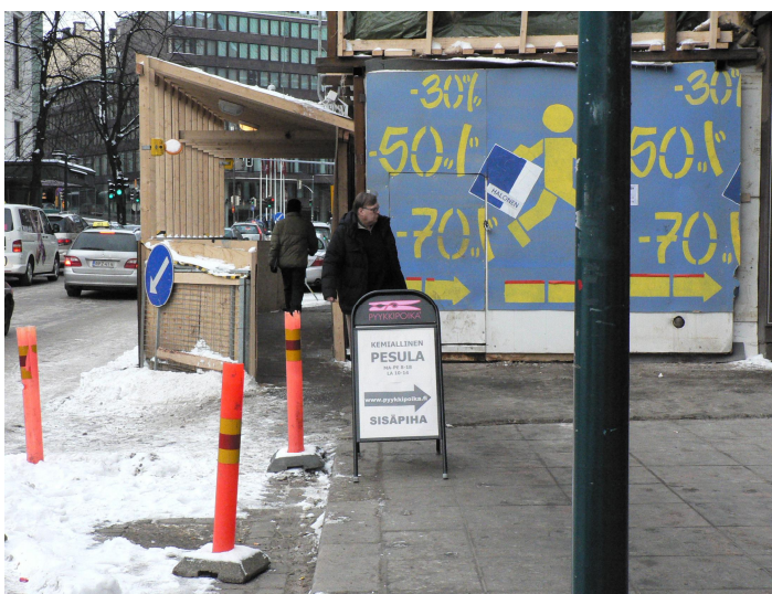
Kuva 41. Jalankulku on järjestetty vanerisen jalankulkutunnelin avulla
