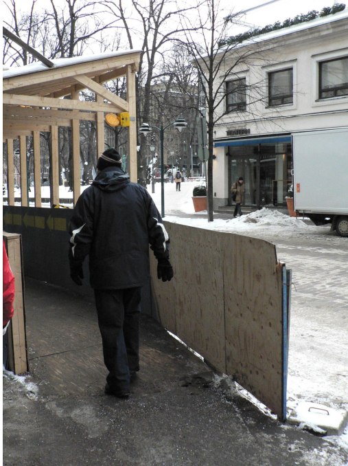
Kuva 37. Hyvä suojalaite ohjaa selkeästi pois ajoradalta.
