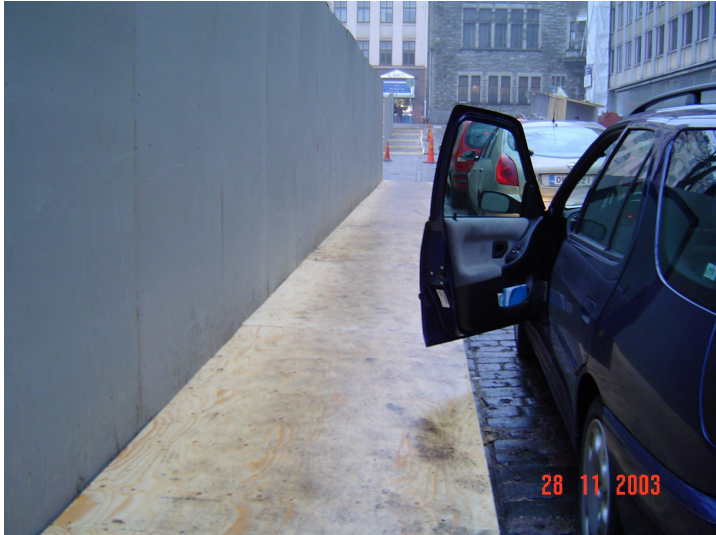
Kuva 31. Vanerista rakennettu tilapäinen jalankulkuväylä on sateella liukas /13/.
