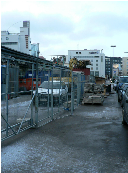
Kuva 26. Kaikki työmaan tarvikkeet tulisi sijoittaa aitauksen sisäpuolelle.
