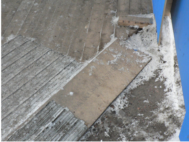
Kuva 44. Kuvan luiskajärjestely on huono ja liukas.
