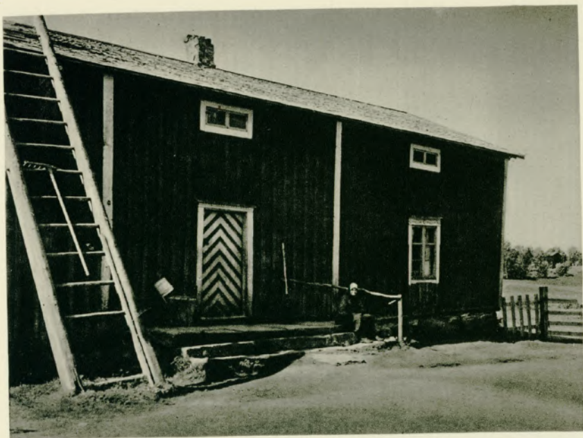
Vanhan Puuställin talon pihanpuoli portaineen ja tikapuineen.
