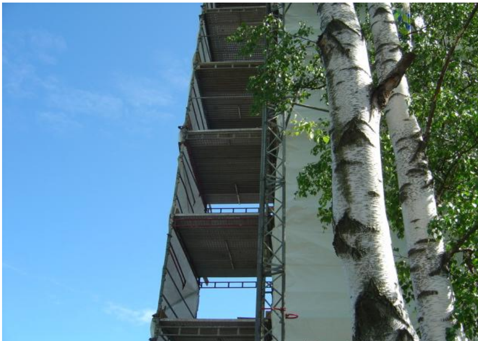
Kuva 5. Kuvasta havaitaan että telineen kolmesta alimmasta kerroksesta on tiilihissin kohdalta poistettu putoamiselta suojaavat kaiteet. Työpäivän päätyttyä kaiteita ei ole asennettu takaisin. Kolmannen kerroksen korkeus maasta on yli viisi metriä
