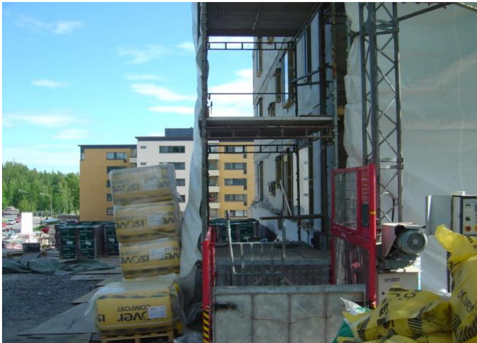
Kuva 5. Kuvasta havaitaan että telineen kolmesta alimmasta kerroksesta on tiilihissin kohdalta poistettu putoamiselta suojaavat kaiteet. Työpäivän päätyttyä kaiteita ei ole asennettu takaisin. Kolmannen kerroksen korkeus maasta on yli viisi metriä
