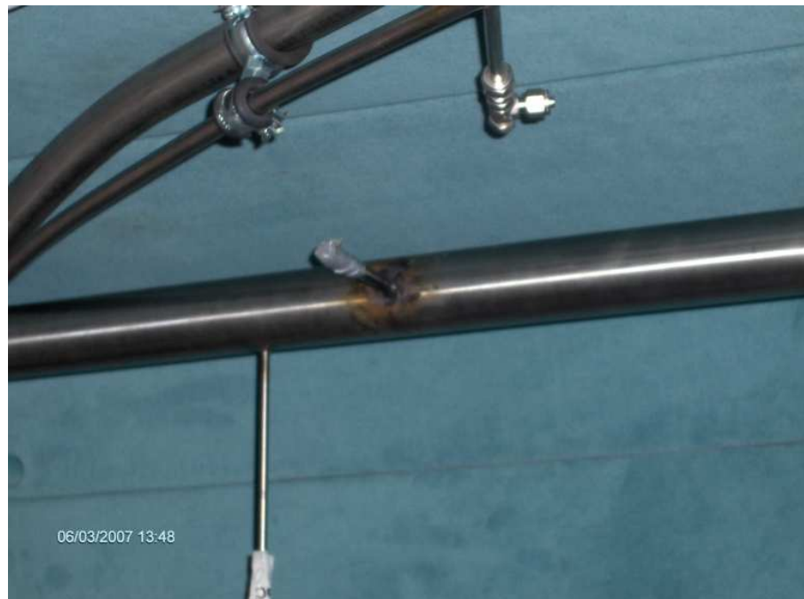
Kuva 19. Anturin holkki 50 mm:n putkessa
