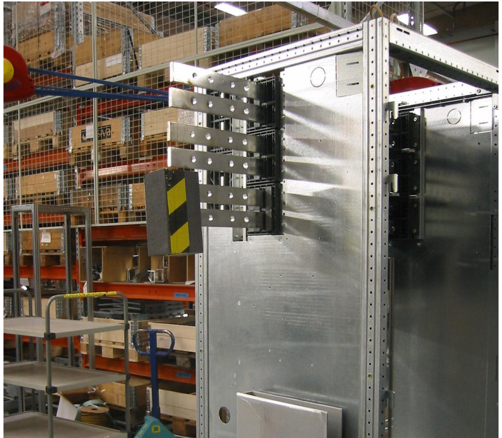
Kuva 2. Kaapiston johdinkiskot kasvattavat kaappimoduulin kokonaispituutta.
