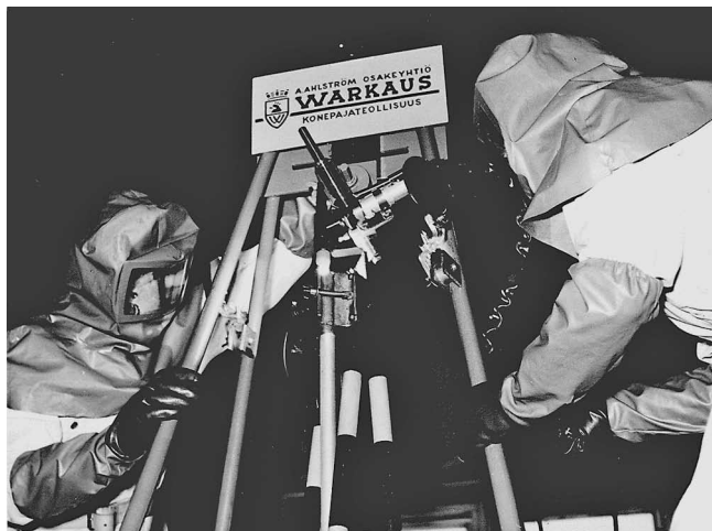
Figur 15. Svetsning av ett bränsleelement. (Författarens arkiv).
