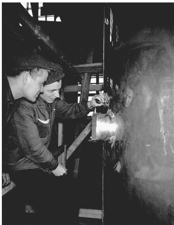
Figur 19. Kontroll av en reaktortankstuds i Varkaus. (Författarens arkiv).
