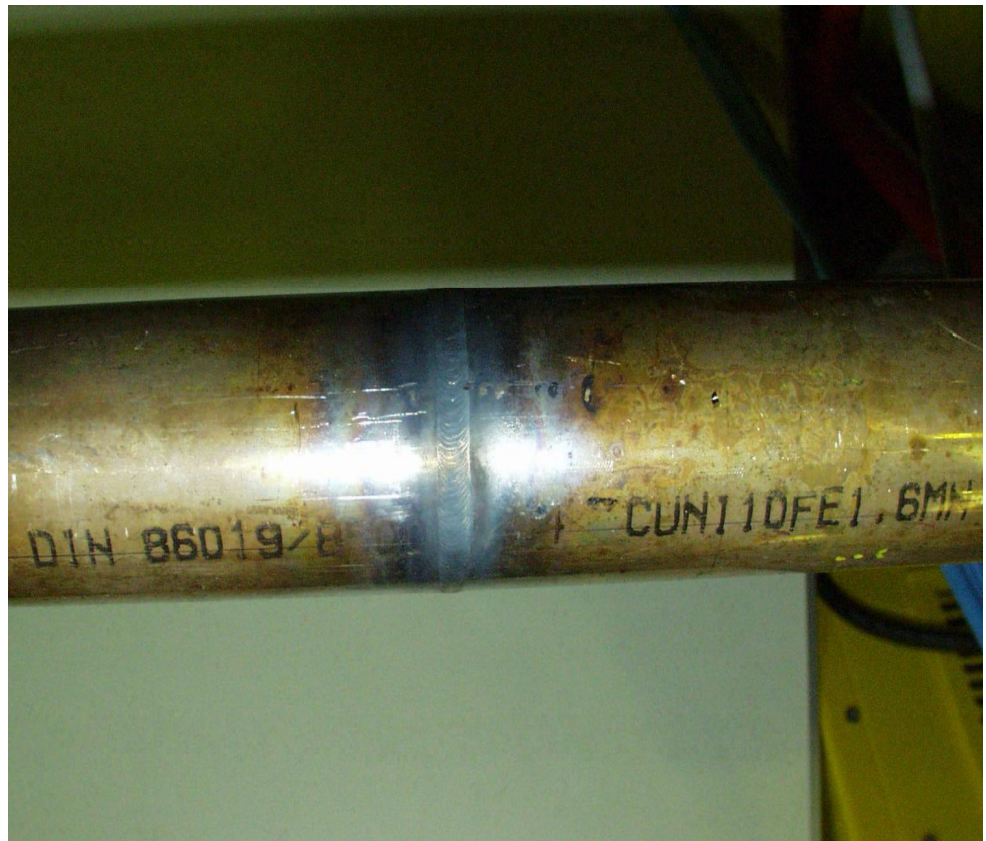
Kuva 70. Orbitaalihitsattu Cunife-putki
