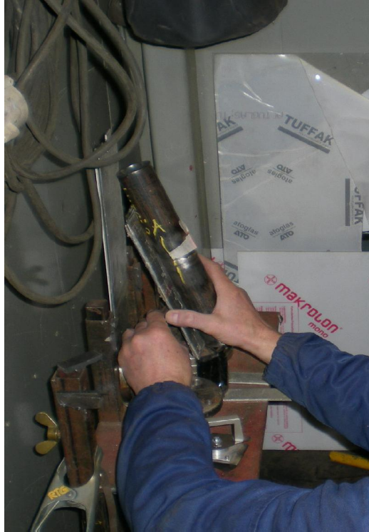
Kuva 103. Filmin asennus hitsausliitoksen vastakkaiselle puolelle
