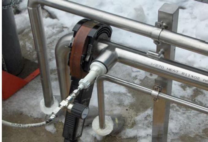
Kuva 40. Koteloidulla hitsaustyökalulla työskentelyä ulkotiloissa [21]
