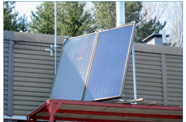
Lämpökoeaseman seinustalle asennettu 4 m 2 tasopaneeli on suunnattu 30 asteen kulmassa kohti etelää. Kuva: Jyrki Kouki
