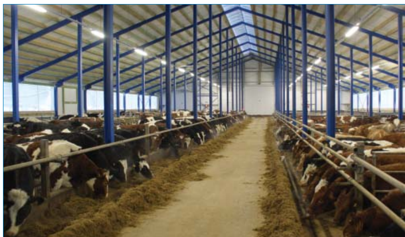
Kuva 15. Suurin osa työajasta erikoistuneessa hiehonkasvatuksessa kuluu ruokintaan, puhtaanapitoon ja kuivutukseen, suunnittelu- ja johtotöihin sekä tarkkailuun. Kuva: Veli-Matti Tuure
