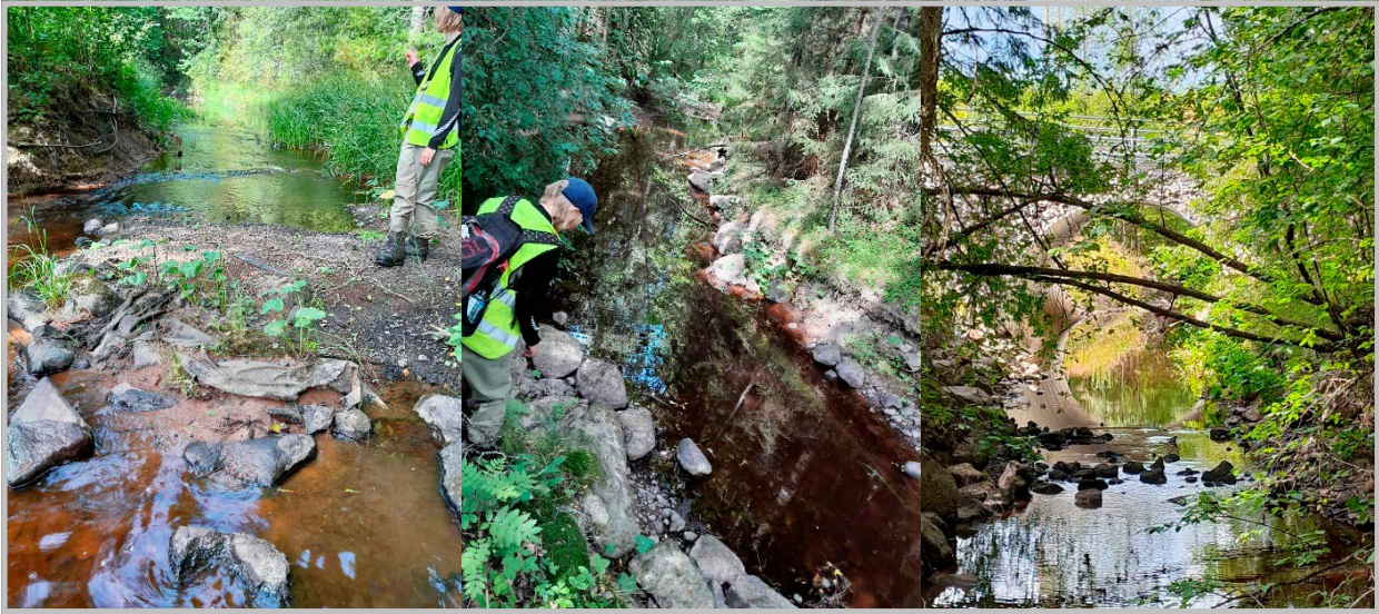
Kuva 76. Vasemmalta oikealle: Virtapaikan alaosassa pohjaan on levitetty peiteharsoa ja yläosaltaan se on rännimäinen. Teijärventien silta ei muodosta nousuestettä.
