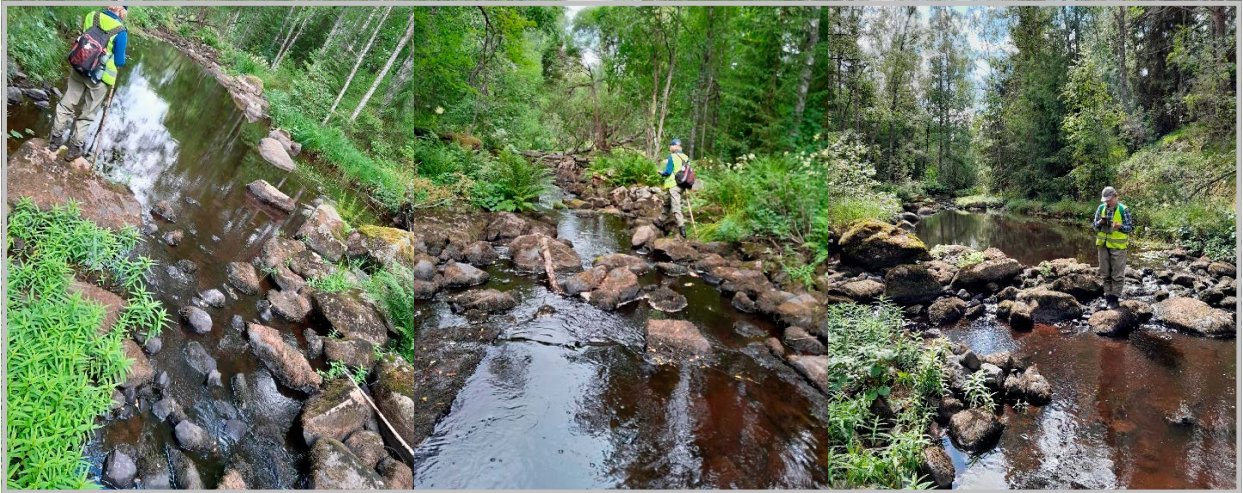
Kuva 68. Virtapaikka 81 on voimakkaasti perattu, ja siinä on uimapaikkaa varten rakennettu pohjapato.
