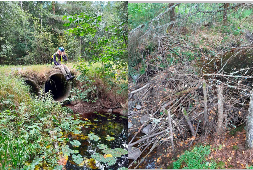
Kuva 119. Vasemmalta oikealle: Nousuesteen muodostavat Ylijoentien rumpu (nousueste z) sekä Pirttijärven alapuolinen majavanpato (nousueste å).
