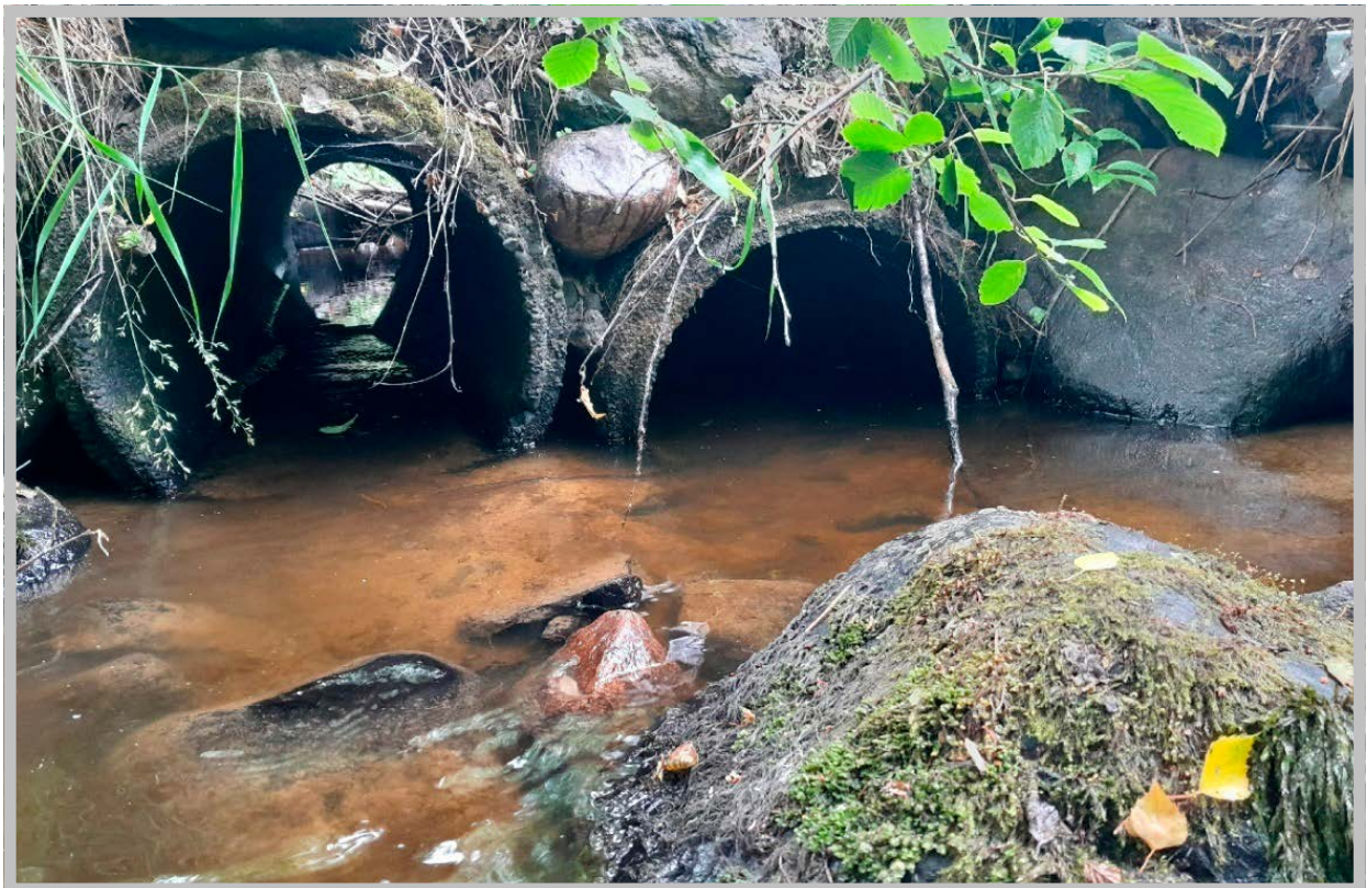
Kuva 5. Railastonjojan alimmat rummut sijaitsevat Lamminpohjantiestä noin 150 metriä alavirtaan.
