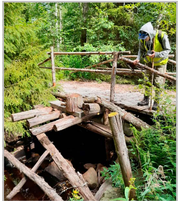
Kuva 85. Räystölän pellon pohjoispäädyssä sijaitseva Noro-ojan ylittävä silta.
