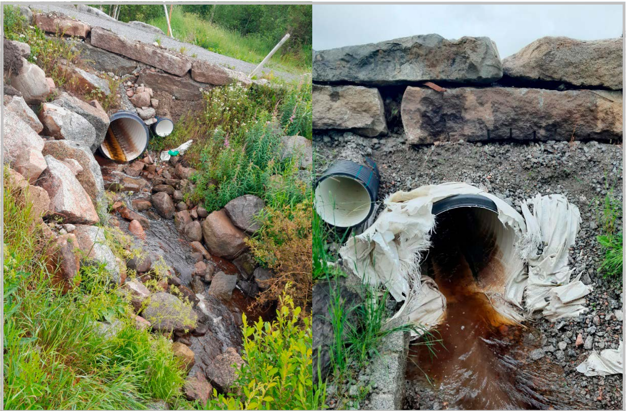
Kuva 17. Jokisentien rumpu muodostaa ainakin alivirtaamalla nousuesteen vesieliöille.
