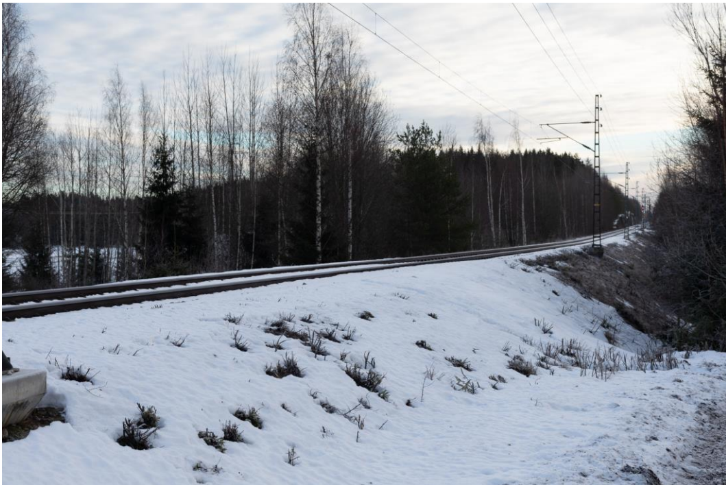
Kuva 62. Rata ylittää Kullobäckenin laakson korkealla penkereellä, joka vaihtuu eteläpäässä leikkaukseksi. Mikko Itälahti 2.1.2023.
