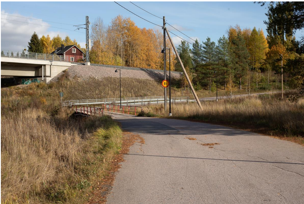
Kuva 12. Nikkilän asemalta sairaalalle johtava tielinjaus Sipoonjoen laaksossa lännestä, Nikkilän aseman suunnasta nähtynä. Betonisilta ajoittune 1900-luvun alkuun. Mikko Itälahti 7.10.2022.
