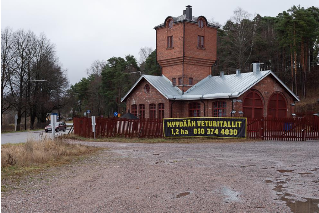
Kuva 119. Vanhempi veturitalli-vesitornirakennus sijaitsee maisemallisesti erittäin merkittävällä paikalla Vanhan Hämeenlinnantien ja Suuren Rantatien risteuksen länsipuolella. Mikko Itälahti 8.11.2022.
