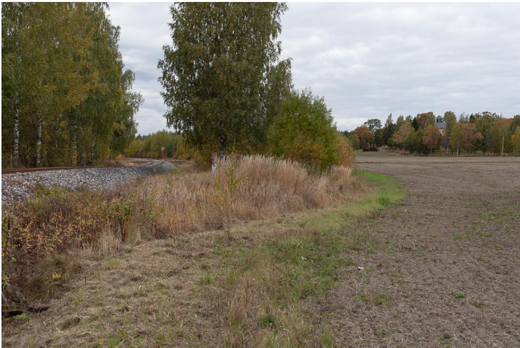
Kuva 150. Vuonna 1978 siirrettyä ratalinjaa Kiialan kartanon itäpuolella. Alkuperäinen ratalinja kulki radan oikealla puolella olevan pajupensaan kohdalta kuvan oikean alakulman suuntaan. Mikko Itälähti 24.9.2022.
