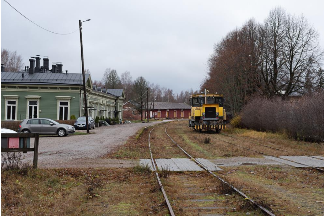
Kuva 118. Porvoon asemarakennuksen ja asuinalueen väliin jää raiteiston ja laituri-alueen muodostama, alueen toinen keskeinen tila-akseli. Mikko Itälahti 31.10.2022.
