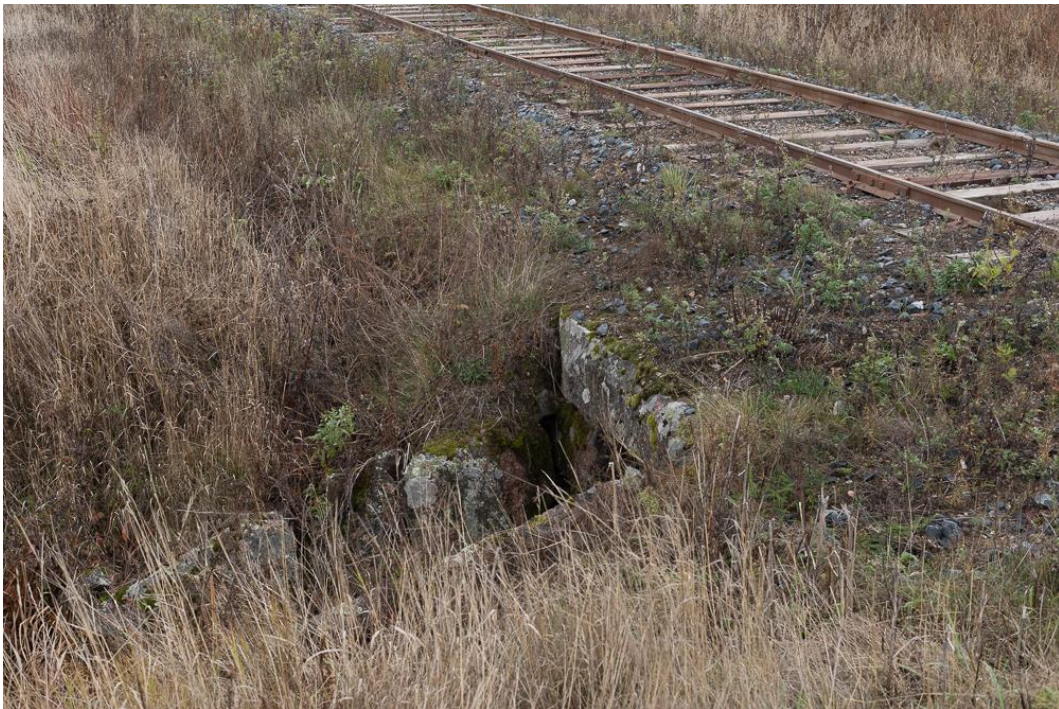
Kuva 168. Anttilassa olevan kivirummun (R-7174) kanavoitu pohjoispuolen suuaukko. Mikko Itälahti 13.10.2022.
