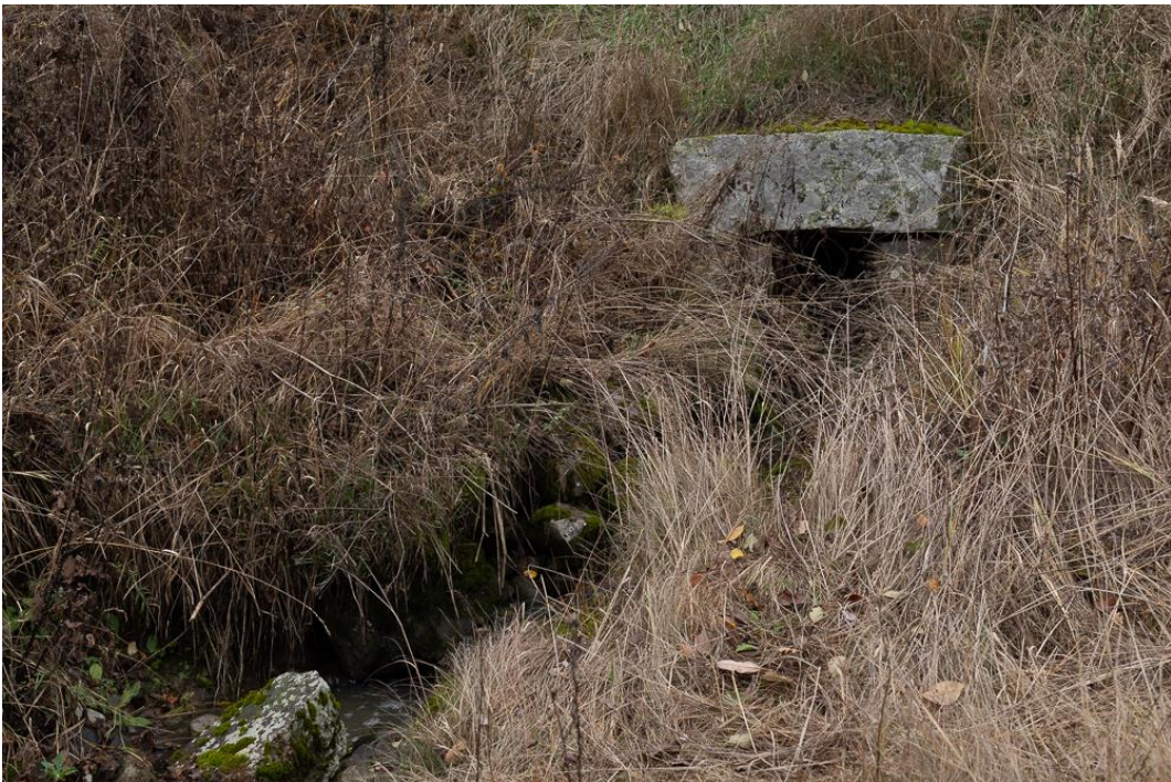
Kuva 170. Tyypillinen lohkokivirumpu Yli-Vekkosken Hemängenillä, Gästgivarsin talon kohdalla. Mikko Itälahti 17.10.2022.
