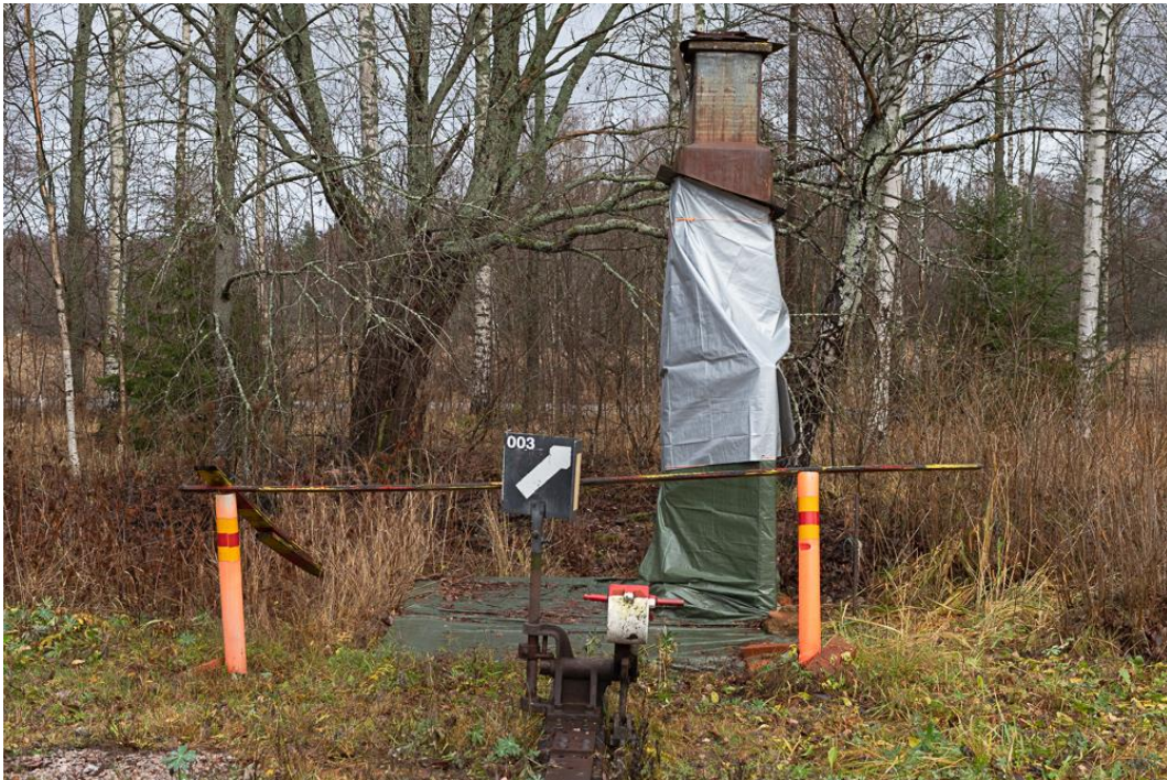
Kuva 126. Tyyppi II -vaihdekojun (1947) lämmitysmuuri Porvoon ratapihan pohjoispään vaihteiden luona. Taustalla hämöttää Vanha Hämeenlinnantie ja Porvoonjoki. Mikko Itälahti 8.11.2022.
