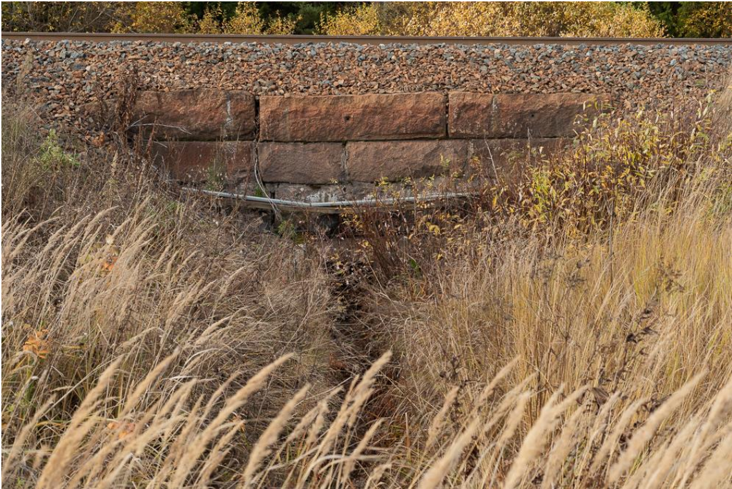
Kuva 166. Jokseenkin Nikkilän ja Herralan kylien rajalla sijaitseva kivirumpu kilometrillä 40+880. Kuvasta ilmenee hyvin rummun korotettu reunapalkki. Mikko Itälahti 7.10.2022.
