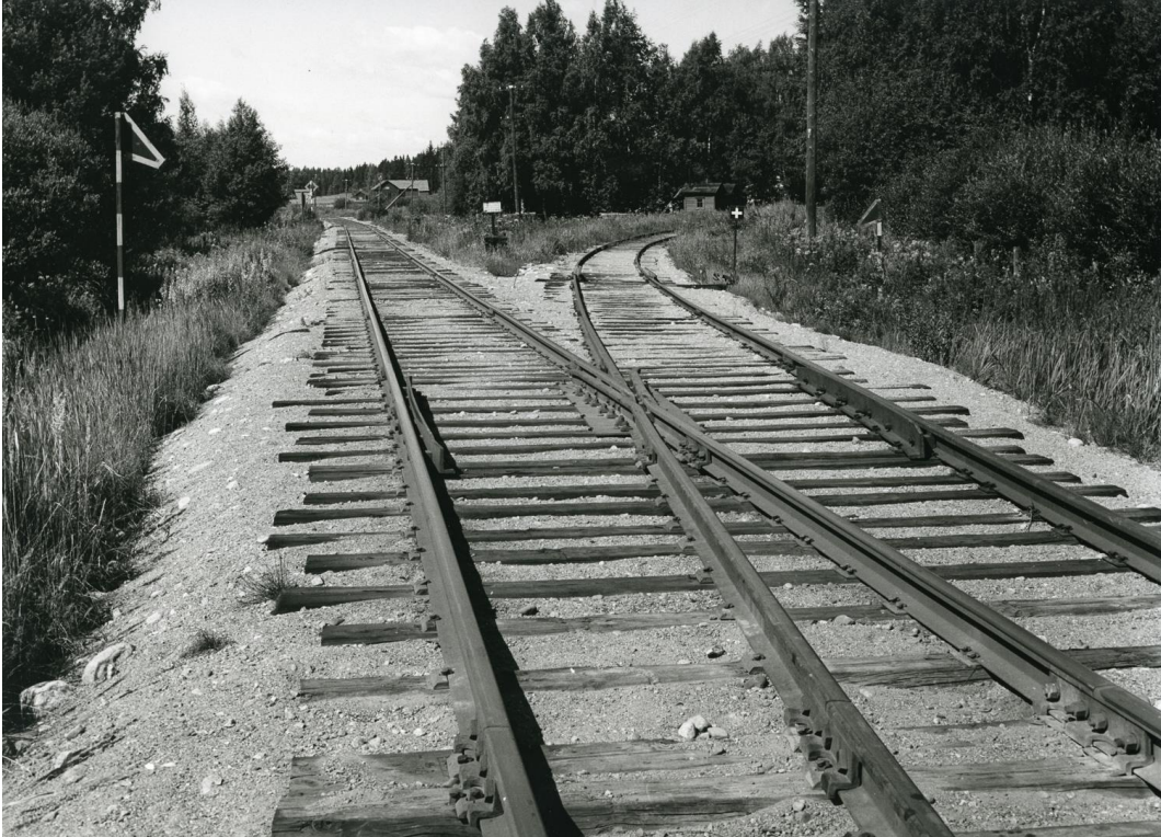
Kuva 131. Talman sora- ja teollisuusraiteen vaihde. Olavi Karasjoki / VR 6.8.1968 (SRM / Vr1:16052).
