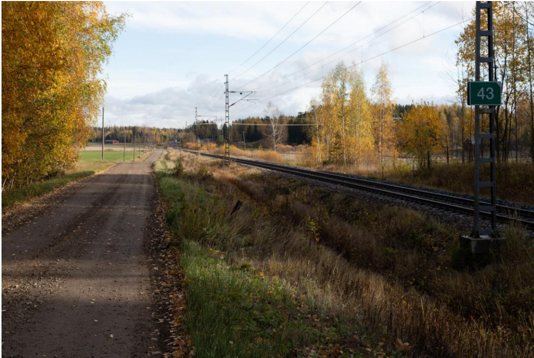
Kuva 18. Näkymä itään ratakilometriltä 43 kohti Linnanpellon kylän Stationsändanin viljelyksiä. Suurin piirtein tällä paikalla sijaitti Martisin tilan mukaan nimetty 1931–1942 toiminut Martin seisake. Mikko Itälahti 10.10.2022.
