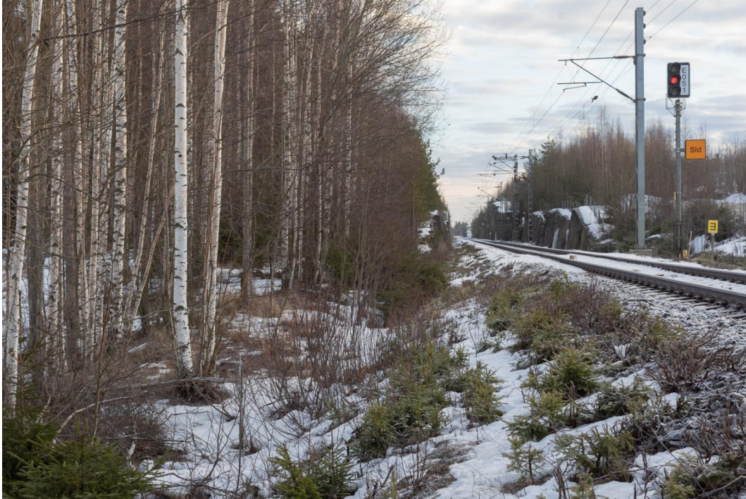
Kuva 64. Kullobäckenin ylittävä pengerraus vaihtuu leikkaukseksi laakson etelälaidalla. Vasemmalla todennäköisesti rakennusaikaisen työmaatien pohjaa. Mikko Itälahti 2.1.2023.
