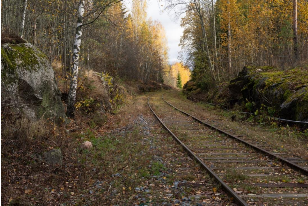
Kuva 141. Ratalinja puhkoo Ali-Vekkoskella Mustijoen länsirannan kalliota. Tällä paikalla 9.2.1872 alkanut louhinta oli ratatyömaan ensimmäinen urakka. Mikko Itälahti 17.10.2022.
