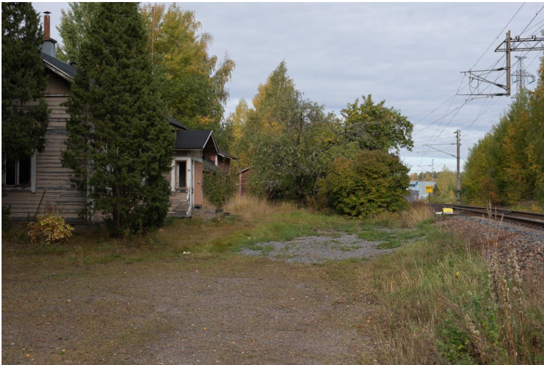
Kuva 76. Keravan vahtituvan rakennuskantaa. Mikko Itälahti 23.9.2022.
