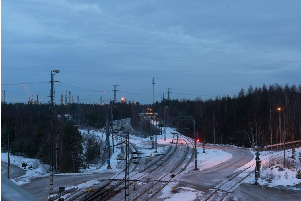
Kuva 71. Näkymä kaakkoon Kilpilahdentien ylikulkusillalta. Mikko Itälahti 2.1.2023.
