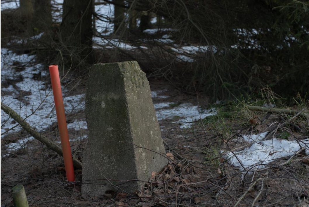
Kuva 67. Rata-alueen betonista valettu rajapyykki kilometrillä 54. Mikko Itälahti 2.1.2023.
