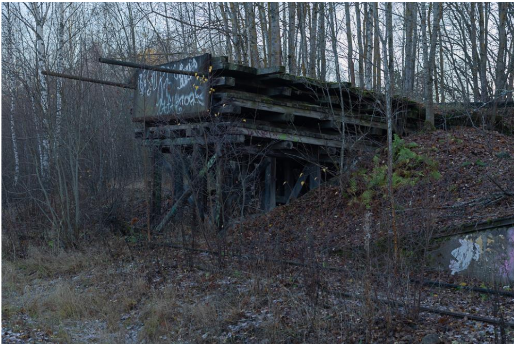
Kuva 127. Porvoon läntisen huolinta-aseman lastausramppi ja kaistale betonista lastauslaituria. Mikko Itälahti 31.10.2022.
