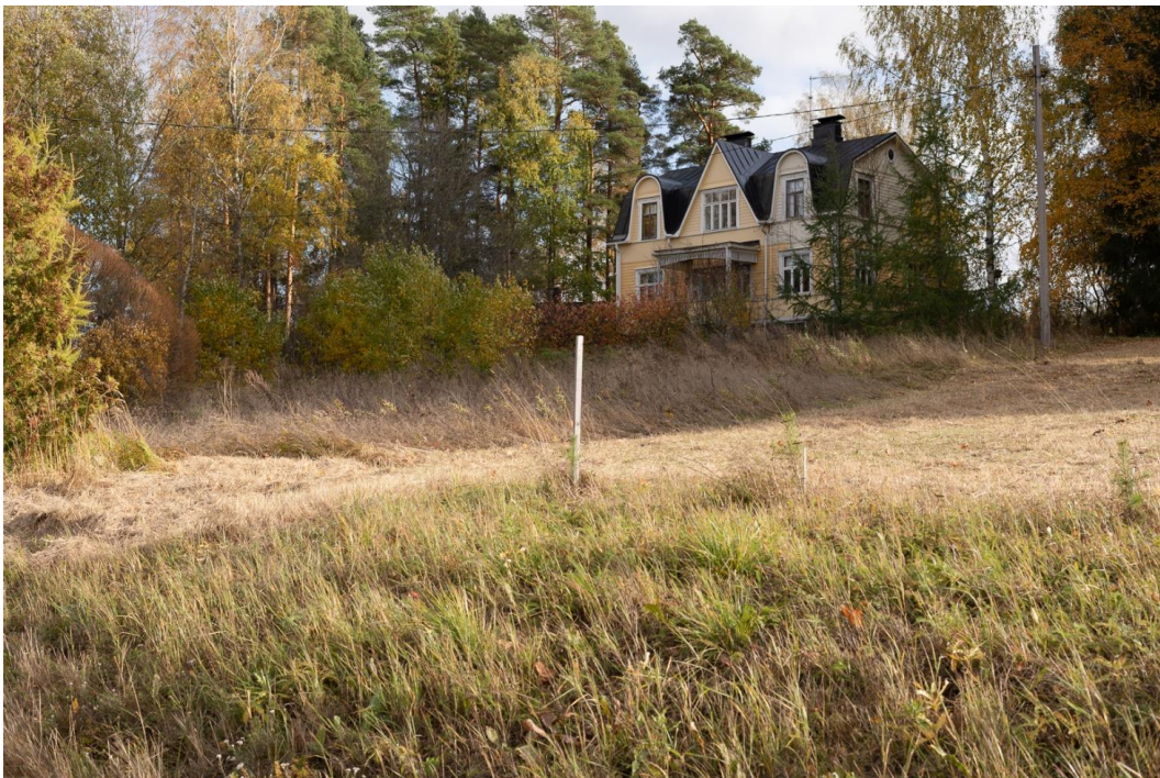
Kuva 13. Mäntymäen huvila radan suunnasta nähtynä. Jugendvaikutteinen rakennus sijaitsee maisemallisesti huomattavalla paikalla Sipoonjoen päälaakson itätörmällä. Mikko Itälähti 7.10.2022.
