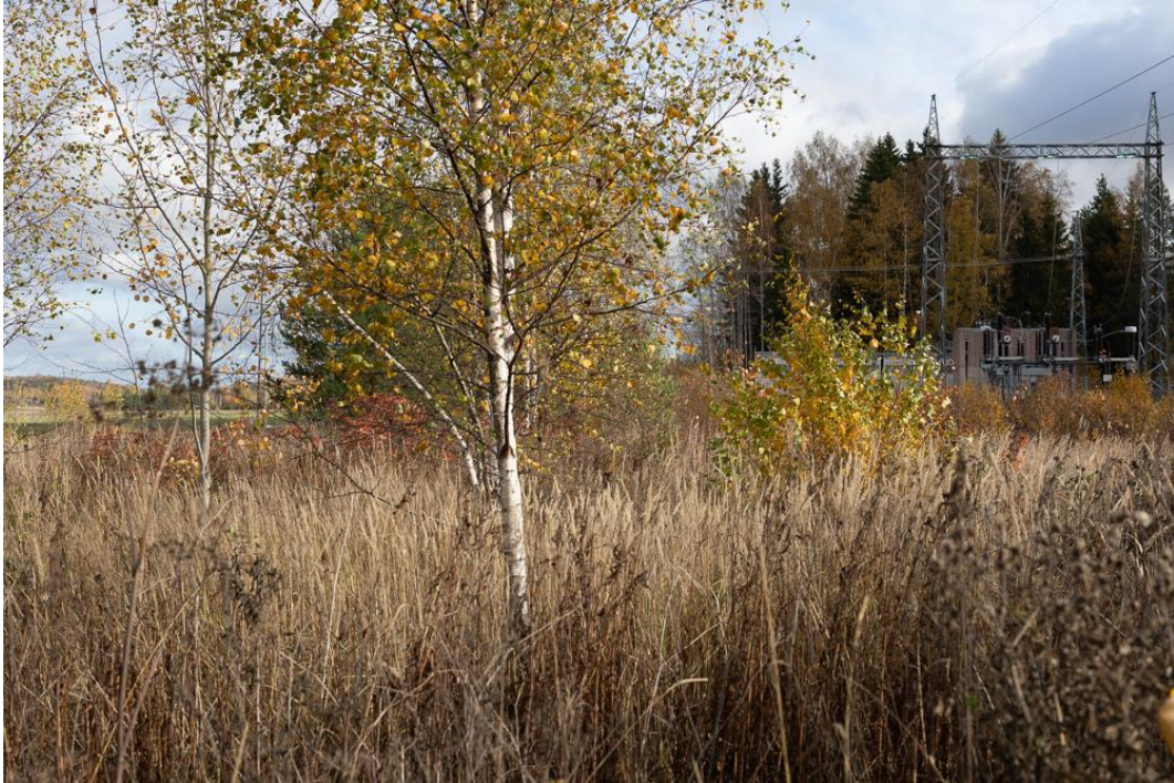
Kuva 100. Näkymä Linnanpellon liikennepaikka-alueelta radan suuntaisesti itään. Vasemmalla, radan takana, häämöttää Stationsändanin viljelyksiä. Jokseenkin liikennepaikkarakennuksen paikalle rakennettiin Kerava–Sköldvik-osuuden sähkönsyöttöä palveleva muuntaja-asema vuonna 1990. Mikko Itälahti 10.10.2022.
