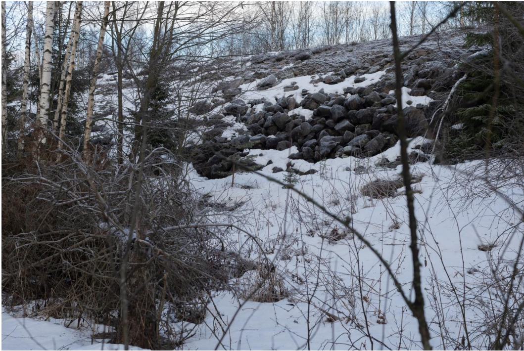
Kuva 63. Kullobäckenin penkereen luiskaa. Järeämmän kiviaineksen tarkoitus on hillitä harjusoran eroosiota. Mikko Itälahti 2.1.2023.
