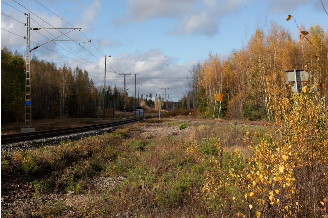
Kuva 21. Ollin vaihde sijaitsee keskellä Linnanpellon ja Anttilan viljelysten väliin jäävää metsäistä selännealuetta. Alkuperäinen Porvoon radan linjaus kaartaa sähköistämättömänä oikealle. Mikko Itälahti 10.10.2022.
