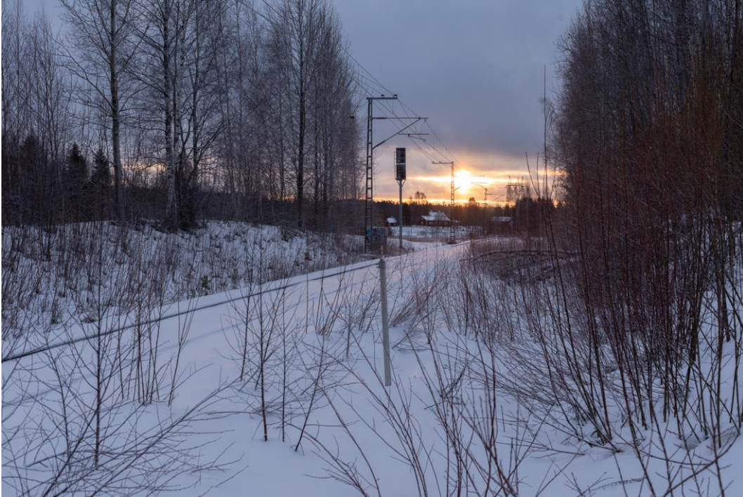
Kuva 75. Pienimuotoinen maaleikkaus Keravan yhdysraiteen pohjoispäässä. Taustalla Postlarsin tilakeskus Keravanjokilaakson viljelymaisemassa. Mikko Itälahti 28.12.2022.
