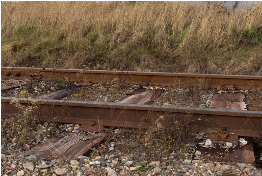
Kuva 137. Porvoo Museorautatie on pääosin soratukikerroksella, puupölkkyillä ja kevyillä kiskoilla varustettu rataosuus, joilla on suuri merkitys radan historialliseen ilmeeseen ja pienimuotoiseen leimaan maisemakuvassa. Kuvan etualan kisko on valmistettu vuonna 1907 ja taaempi 1898. Mikko Itälahti, Yli-Vekkoski 17.10.2022.
