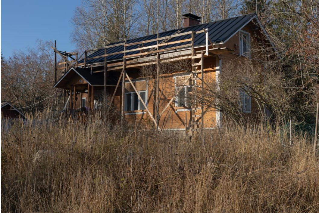
Kuva 86. Haksin vahtituvan päärakennus oli inventointihetkellä kunnostettavana yksityisomistajan toimesta. Vasemmalla häämöttää talusrakennuksen pääty. Mikko Itälahti 24.10.2022.
