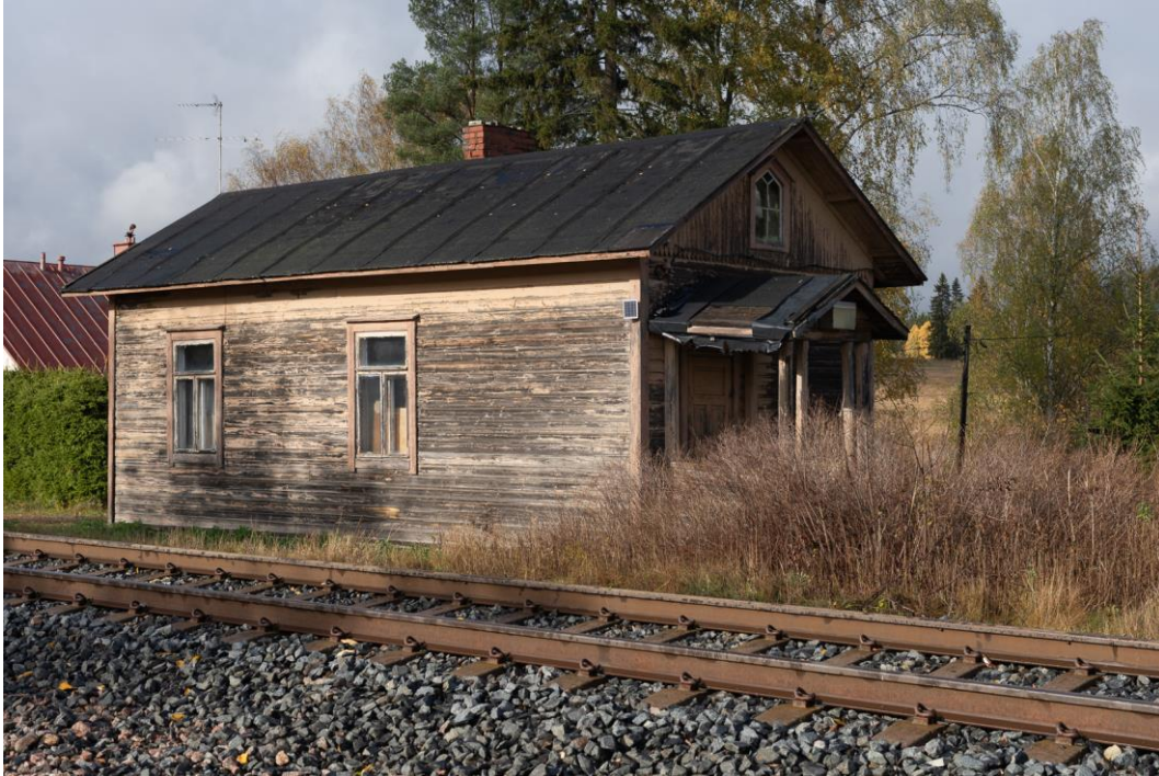
Kuva 80. Nikkilän asema-alueen asuinrakennus 1, joka pohjapiirustuksen ja sijainnin perusteella on oletettavasti toiminut vahtitupana. Mikko Itälahti 6.10.2022.
