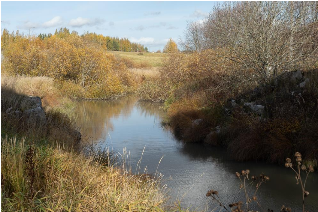
Kuva 160. Tukimuurirakenteita Sipoonjoen ensimmäisellä siltapaikalla Nikkilässä. Mikko Itälahti 7.10.2022.
