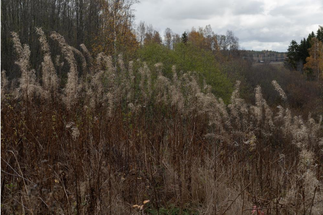
Kuva 148. Näkymä alkuperäisen ratapenkereen päältä, puretun viaduktisillan länsipäästä on miltei rehevän kasvillisuuden sulkema. Mikko Itälahti 17.10.2022.
