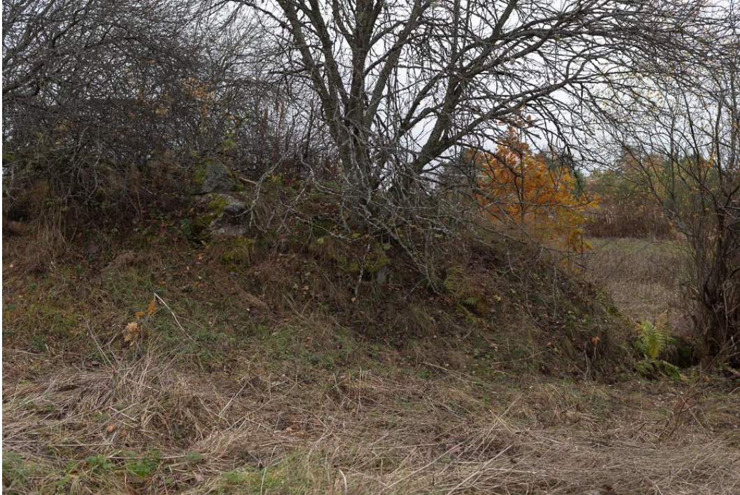
Kuva 147. 1872–1890 käytössä olleen viaduktisillan itäpään tukipenger. Mikko Itälahti 13.10.2022.
