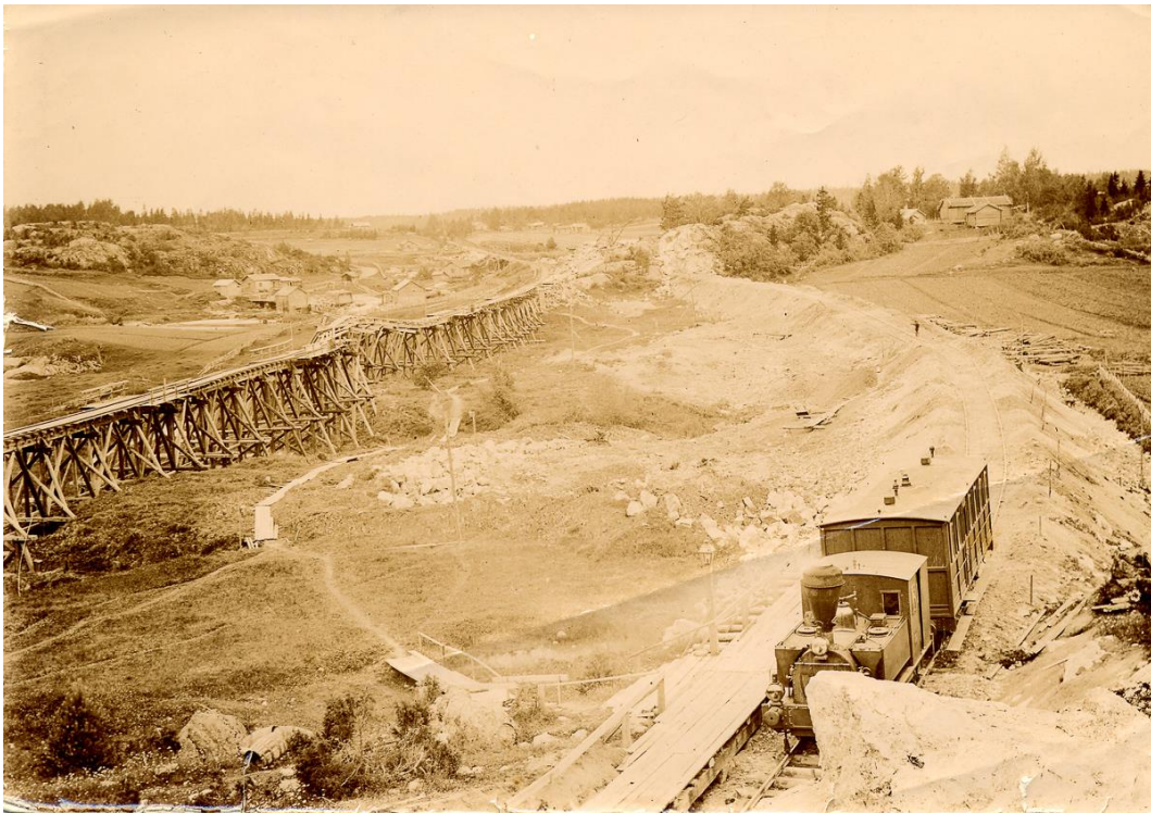
Kuva 143. Radansiirtotyömaa Yli-Vekkoskella vuonna 1890. Etualalla nykyinen ratalinja, taustalla vuosina 1872–1890 käytössä ollut viaduktisilta ja edelleen taaempänä Vekkoskea myllyineen. Kuvassa erottuu myös Mustijoen rantojen tuolloinen paljous. (Porvoon museon kuvakokoelma).
