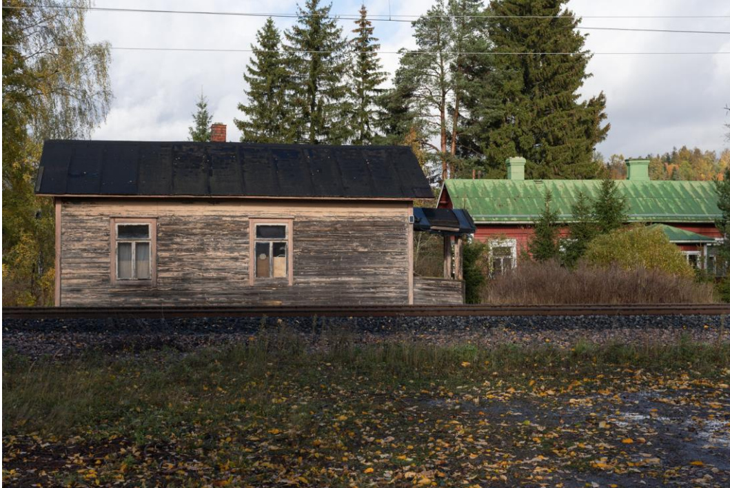
Kuva 96. Nikkilän asema-alueen länsiosan rakennuksia: Etualalla todennäköinen vahtitupa (as. nro 1) ja taaempänä asuinrakennus numero 4, jossa toimi Nikkilän kestikievari. Mikko Itälahti 6.10.2022.
