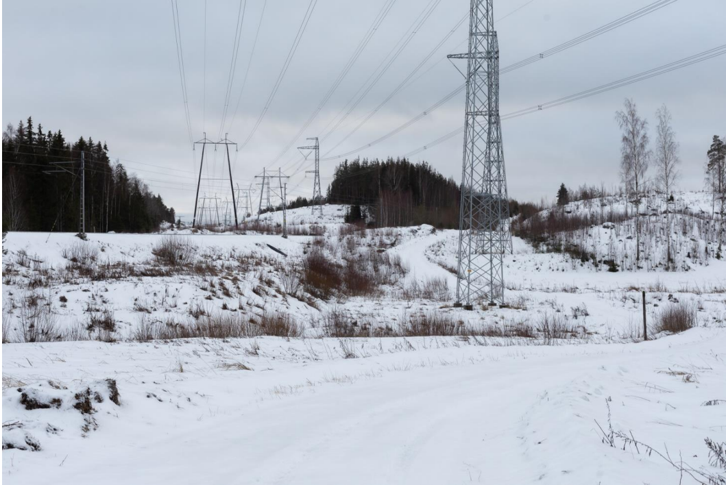
Kuva 57. Anttila, Porvoo. Sköldvikin radan maisemassa näkyvät yhteiskunnan taustavirrat: resurssien käyttö ja liikuttaminen. Kuvassa myös näkyy radan rakennusaikainen huoltotie, jota pitkin rataa saattoi seurata Flymossenin laidalle, noin kilometrimerkille 48 asti. Mikko Itälahti 28.12.2022.
