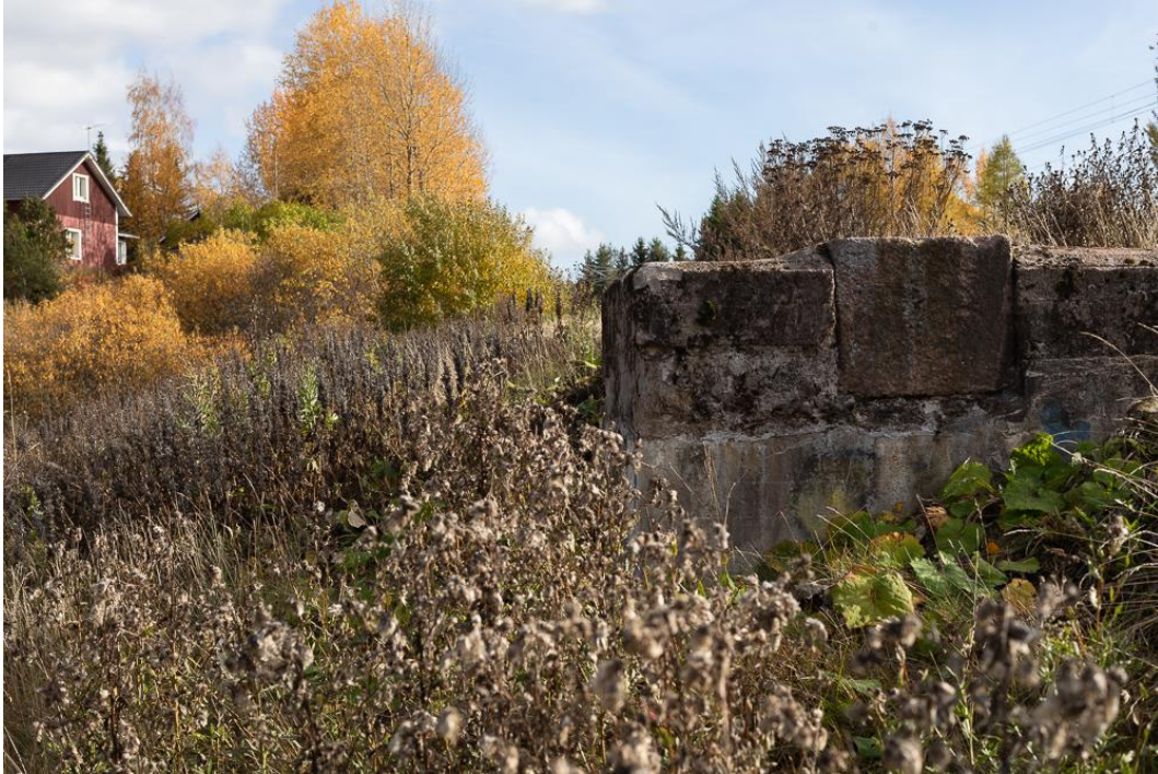
Kuva 161. Täytemaahan haudatun siltapilarin lakiosa Nikkilän ensimmäisellä siltapaikalla. Mikko Itälahti 7.10.2022.
