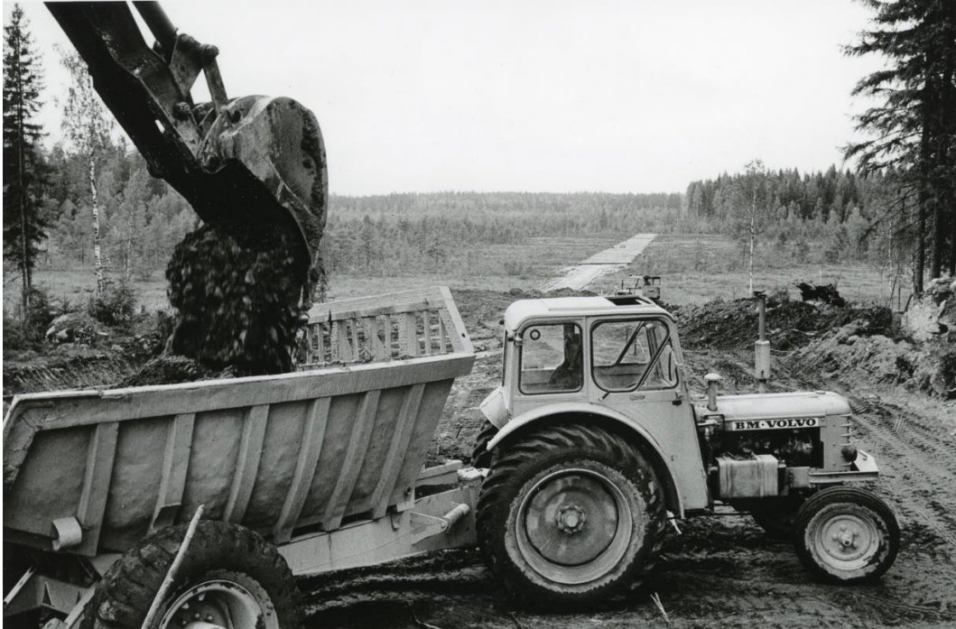
Kuva 51. Sköldvikin radan rakennustyöt ovat alkaneet. Taustalla propsilatemuksin vakautettua ratalinjan pohjaa vielä erämaisen, ojittamattoman Flymossenin yli. Onni Lehtonen / VR, Anttila, 10.9.1970 (SRM / Vr1: 19418)
