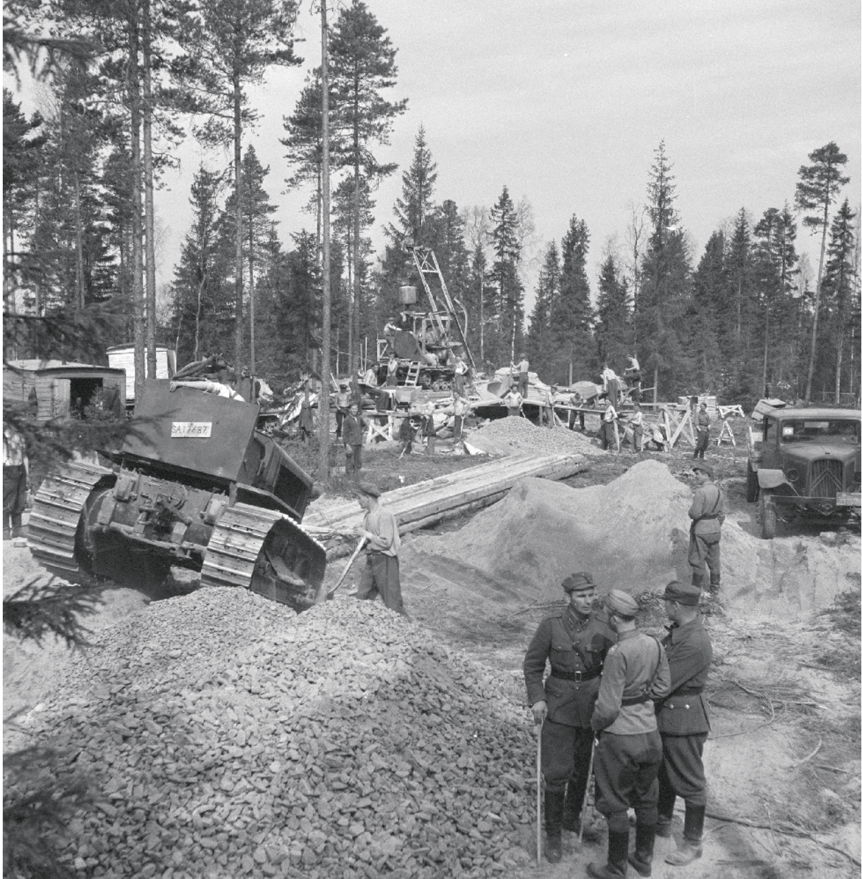
Korsujen tekeminen vaati työvoimaa ja moninaista kalustoa. Yleiskuva Vammelsuu–Kivennapa-alueen työmaalta toukokuussa 1944. Kuva: sotilaskirjailija Jarl Taube / SA-kuva
