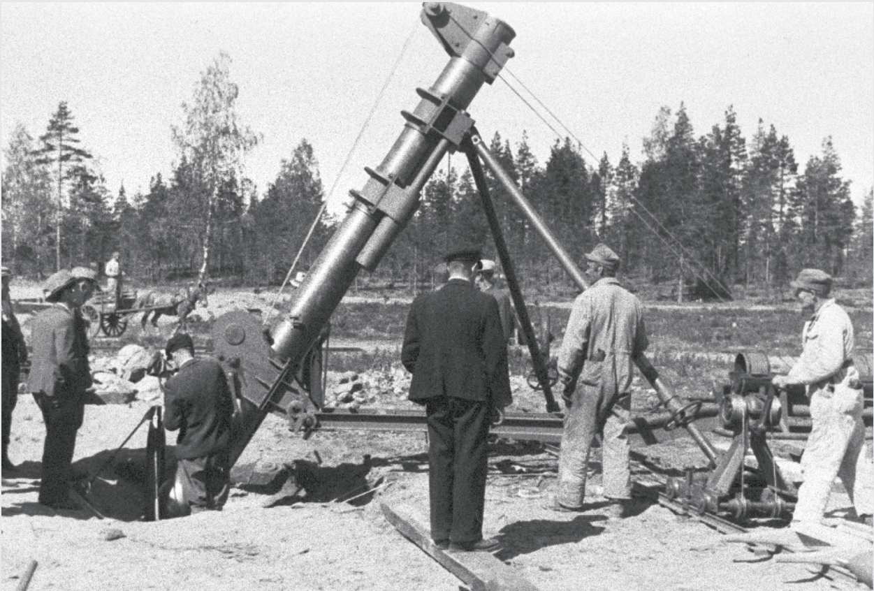
Järeän 300 mm:n kranaatinheittimen koeammunnoissa lataaminen tehtiin ammusvinssin avulla.
