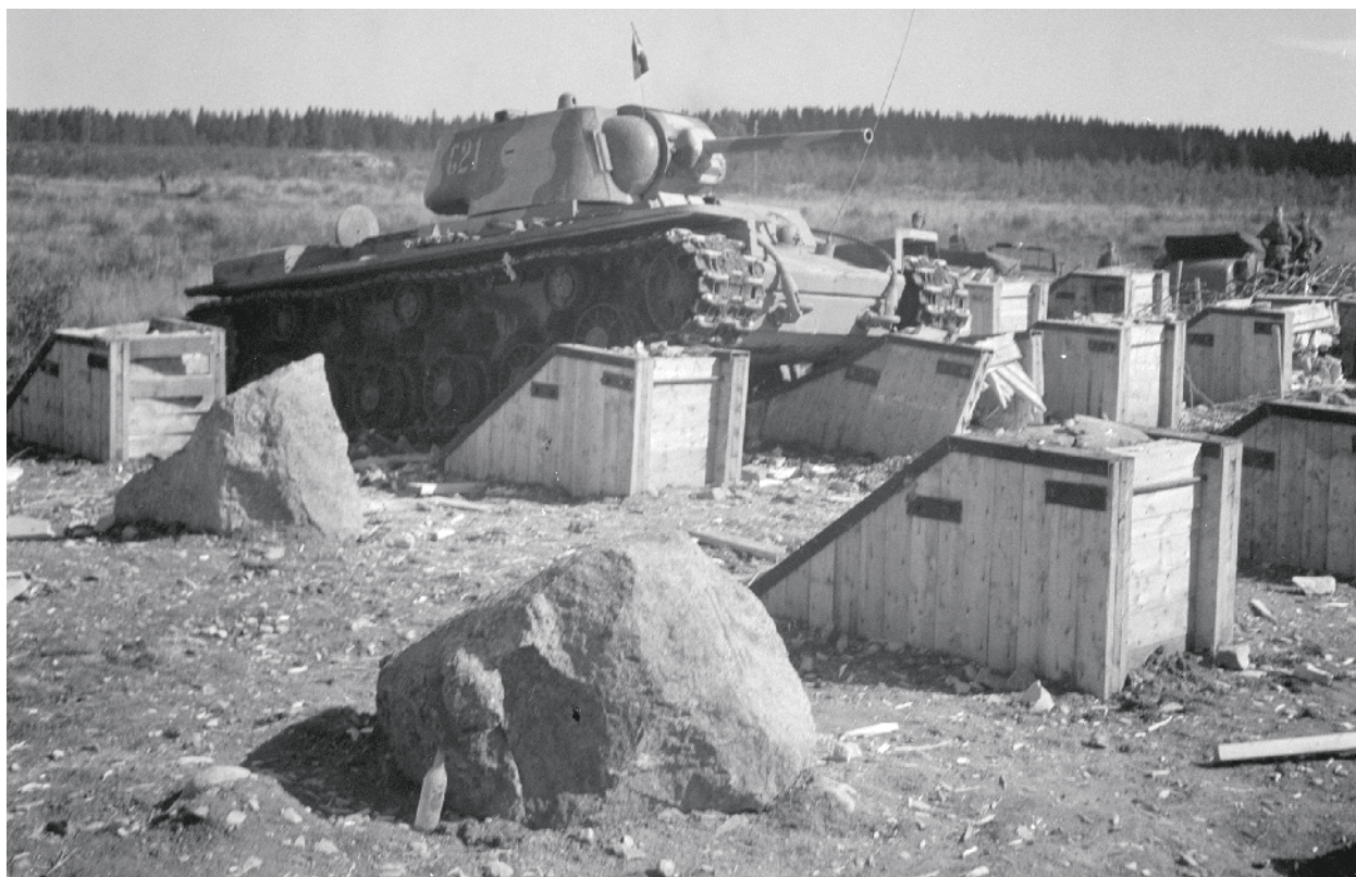
Äänislinnan panssarikentälle oli kokeiluja varten rakennettu erilaisia panssariesteitä, joiden estearvoa ja ampuma- kestävyyttä testattiin ajanmukaisilla T-34- ja KV-1-panssarivaunuilla. Kuvassa KV-1 yrittää ylittää osittain rikki ammuttuja puusärmiöitä. Etualalla estekiviä. Kuva: Ensio Lindholm / SA-kuva
