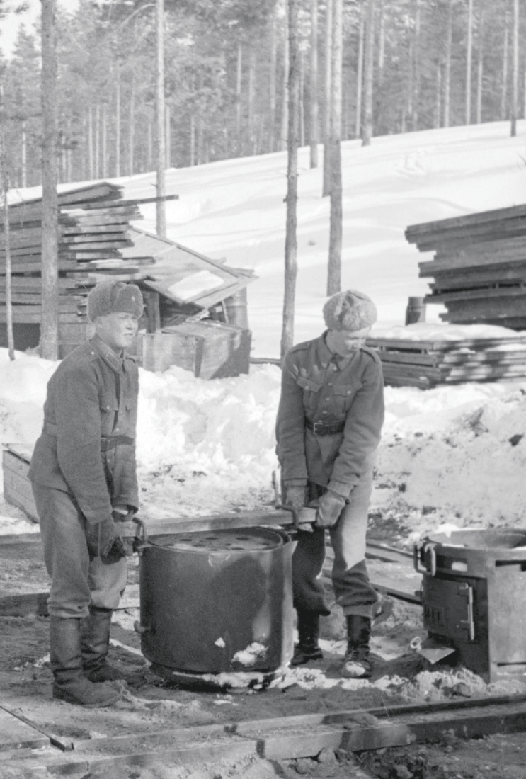
Kaasusuojelukoeaseman toiminta jäi lyhyeksi. Se aloitti toimintansa Niinisalon Hämeenkanalla toukokuussa 1944 mutta lakkautettiin jo muutama kuukausi rauhan tulon jälkeen. Rakennuskanta koostui pääosin esivalmistetuista osista koottavista majoitusparakeista. Kuvassa kootaan desinfiointisaunaa huhtikuussa 1944. Kuva: kersantti Niilo Verronen / SA-kuva
