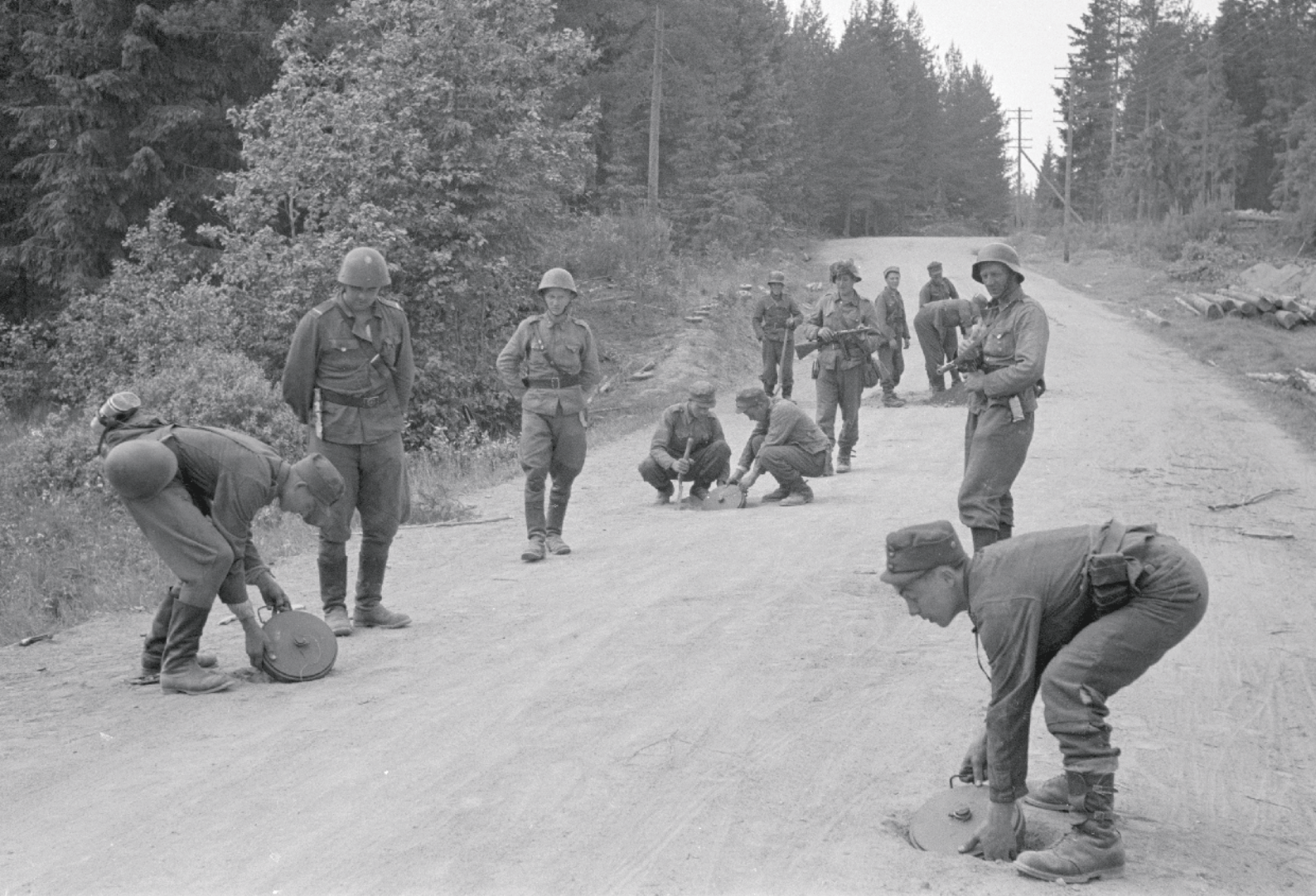
Kokeilutoiminnan avulla saatiin selville muun muassa miinojen oikeanlainen asentaminen tielle. Pioneerit miinoittamassa tietä m/41-panssarimiinoilla lhantalassa kesäkuun lopussa 1944. Kuva: sotilasvirkailija Osvald Hedenström / SA-kuva
