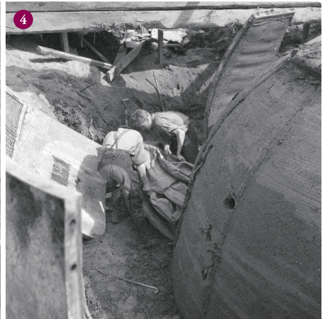
Pallokorsun rakentamisvaiheita Vammelsuu–Kivennapa-alueella 18. toukokuuta 1944. 1) pallomuotin paikoilleen asennus, 2) rauditus ja ulkomuottien kokoaminen 3) valu ja 4) pallomuotin poistaminen. Kuvat: sotilasvirkailija Jarl Taube / SA-kuva
