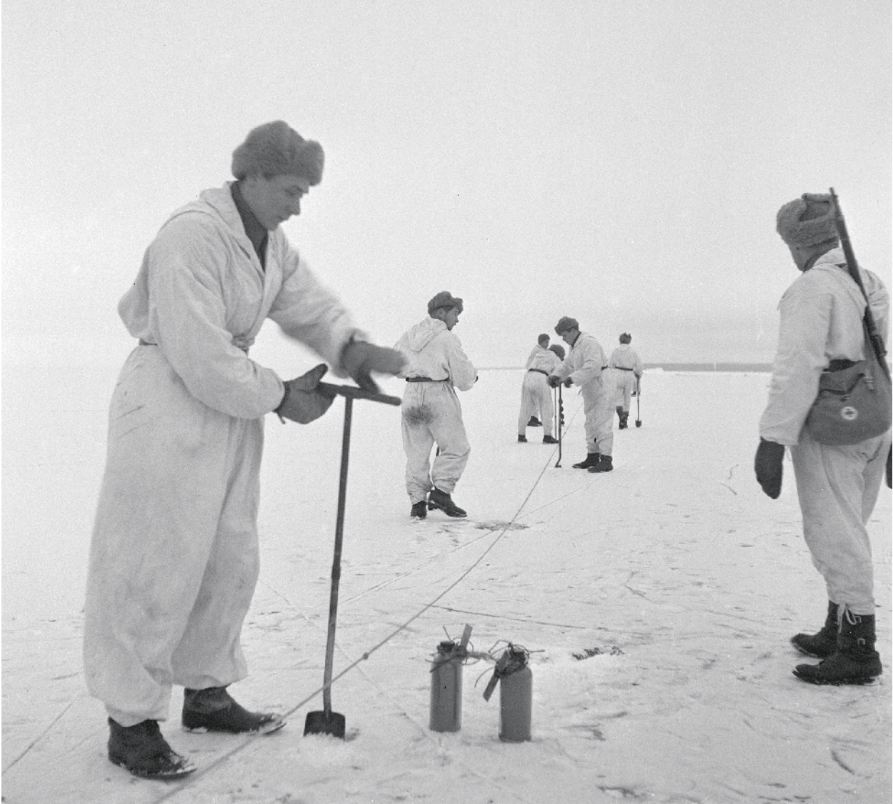
Jäämiina, jolla voitiin estää hyökkääjän eteneminen räjäyttämällä vesistöjen jääpeite, oli suomalainen keksintö. Räjähdyksineella täytetyt lasipullot riippuivat vedessä jäähän poratuista rei'istä ripustuslangan varassa. Kuvassa pioneerien jäämiinoitusta Rajajoen–Vammelsuun rantakaistalla tammikuussa 1944. Kuva: sotilasvirkailija Jarl Taube / SA-kuva
