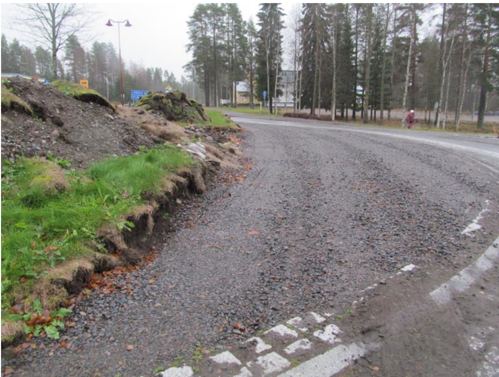
Kuva 13. Kiertoliittymän kiertosaarekkeen muotoileminen läpiajettavaksi (kuva Kjell Lind).
