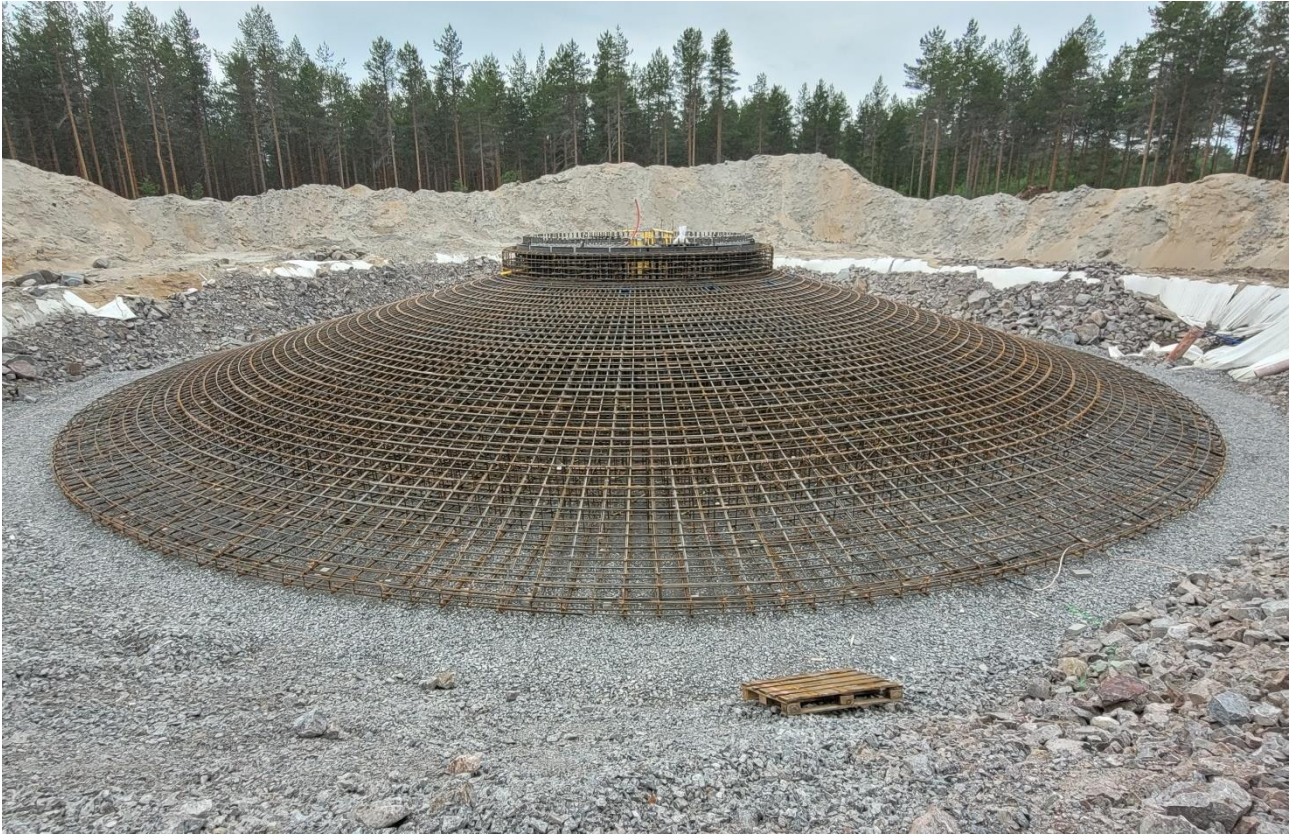
Kuva 3. Tuulivoimalan perustukseen käytetään paljon betonia ja terästä (kuva Ramboll Finland Oy)
