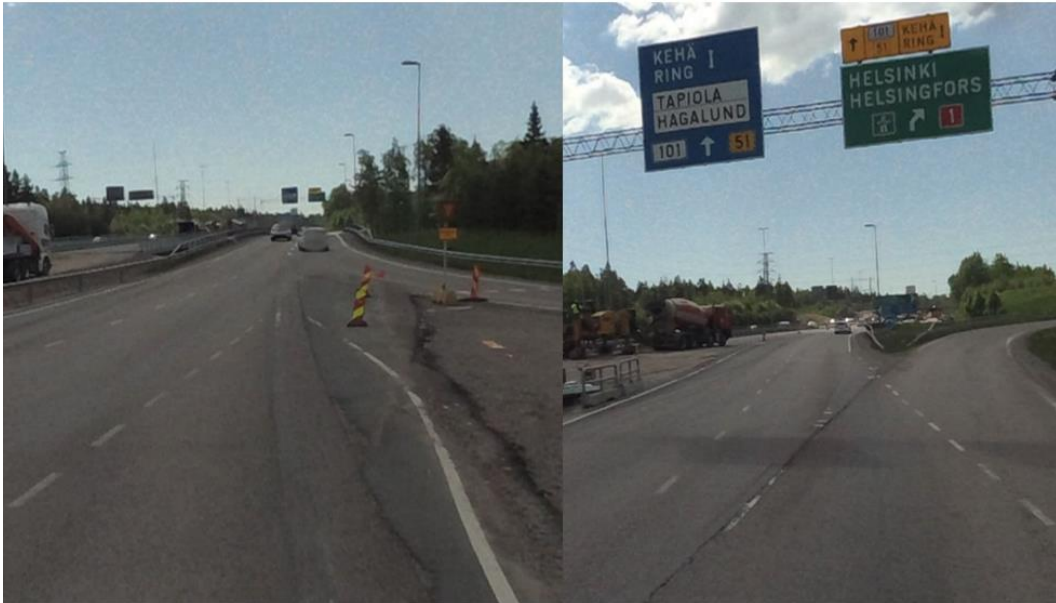
Kuva 58. Puuttuva kiihdytyskaista (vasen). Yläpuoliset opasteet eivät ole kaistojen kohdalla (oikea).
