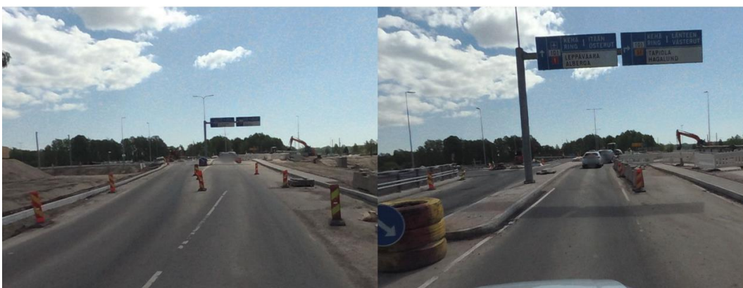
Kuva 47. Siltatyömaa luoteesta saavuttaessa.
