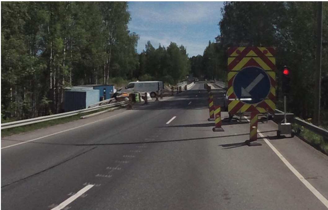
Kuva 13. Mulajärven siltatyömaa lännestä itään.
