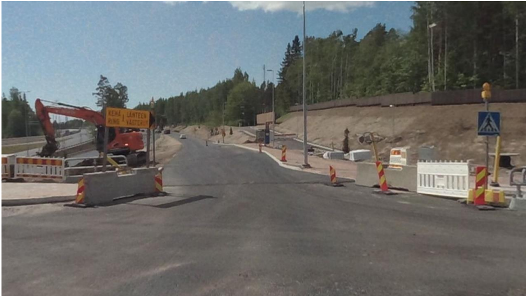
Kuva 46. Idästä länteen saapuvalta rampilta otettu kuva. Kuvassa näkyy Kehä I:lle johtava ramppi.
