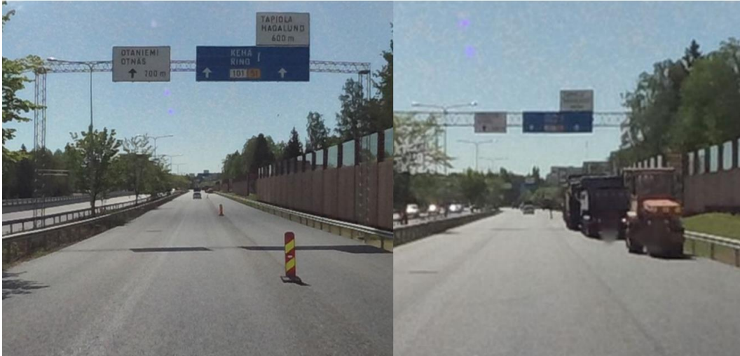
Kuva 64. Kaistan yläpuoliset opasteet antavat väärän kuvan käytössä olevista kaistoista.
