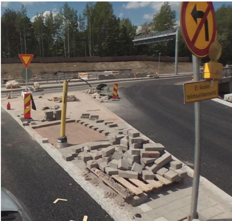
Kuva 45. Saarekkeen laatoitustyöt ja työmaanaikainen liikenteenohjaus.
