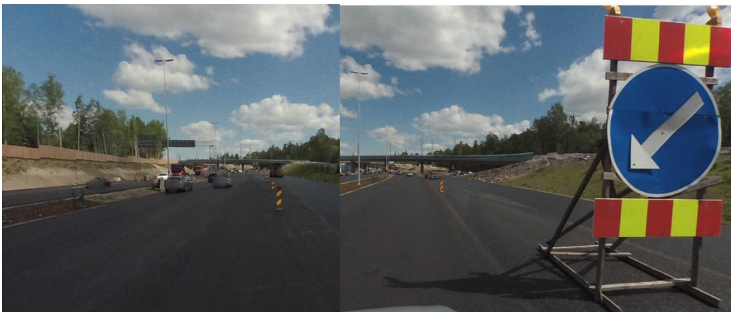
Kuva 51. Tilapäinen kiihdytyskaista (vasen) ja kiihdytyskaistan lopetus sulkuaidalla (oikea).
