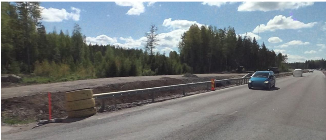
Kuva 21. Kaiteen päässä lävistävä elementti ja suojaus rengasnipulla.
