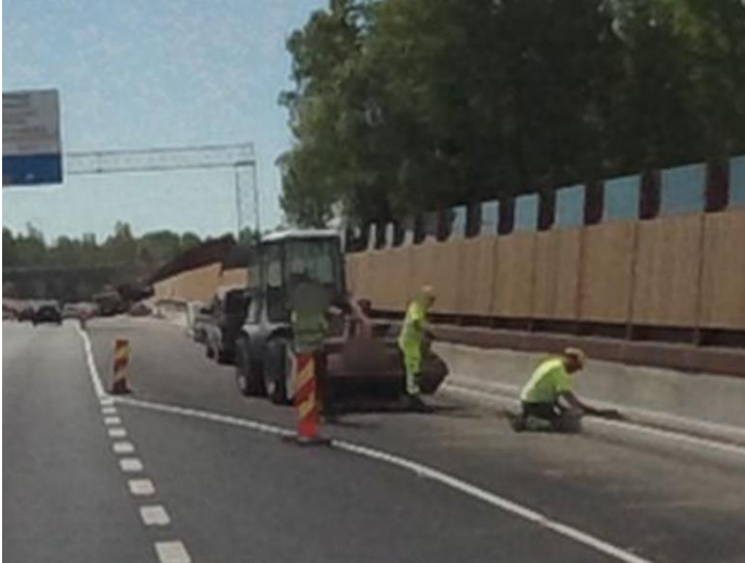
Kuva 69. Käytössä olevan kiihdytyskaistan päässä kiveyksen asennusta.
