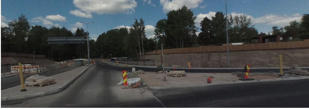
Kuva 44. Saarekkeen laatoitustyöt kesken. Lavallinen laattoja ajokaistalla.
