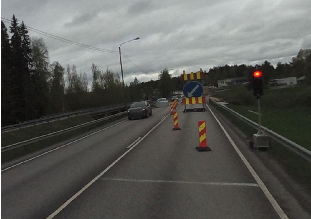
Kuva 16. Jalasjoen siltatyömaa etelästä pohjoiseen.
