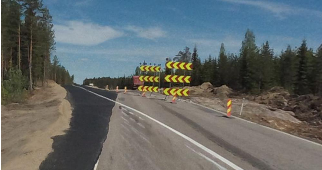
Kuva 25. Valtatie 23:n työmaata lännestä itään päin kuljettaessa.
