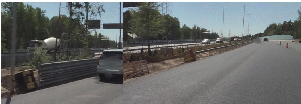
Kuva 63. Kaiteiden päät suojaamatta (vasen ja oikea).
