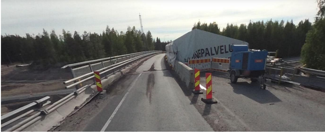
Kuva 18. Viralan eritasoliittymän siltatyömaasta idästä länteen päin ajettaessa.
