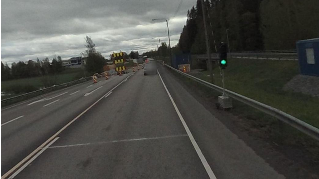
Kuva 15. Jalasjoen siltatyömaa pohjoisesta etelään.
