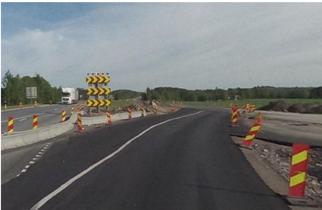
Kuva 1. Valtatie 3:n työmaata pohjoisesta etelään päin kuljettaessa.
