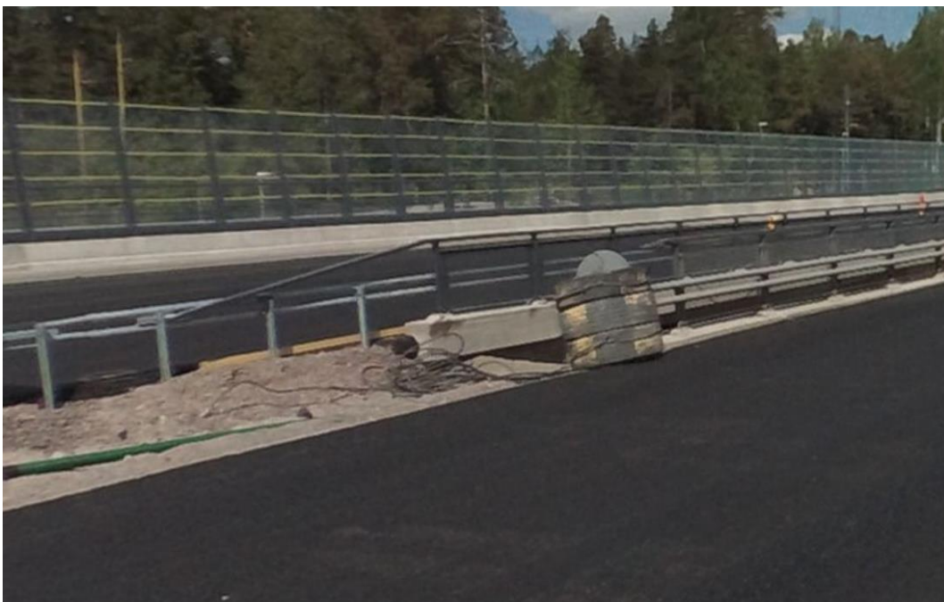
Kuva 39. Rengasnippu seivästävän kaiteen päässä.
