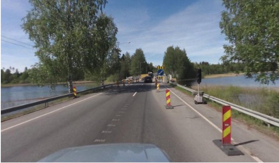
Kuva 12. Mulajärven siltatyömaa idästä länteen.
