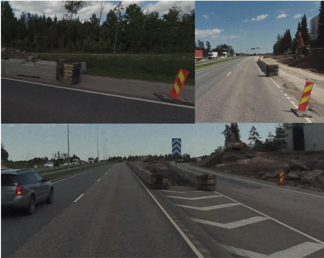
Kuva 66. Betonielementtijonoissa oli aloituskohdissa käytetty rengasnippua.
