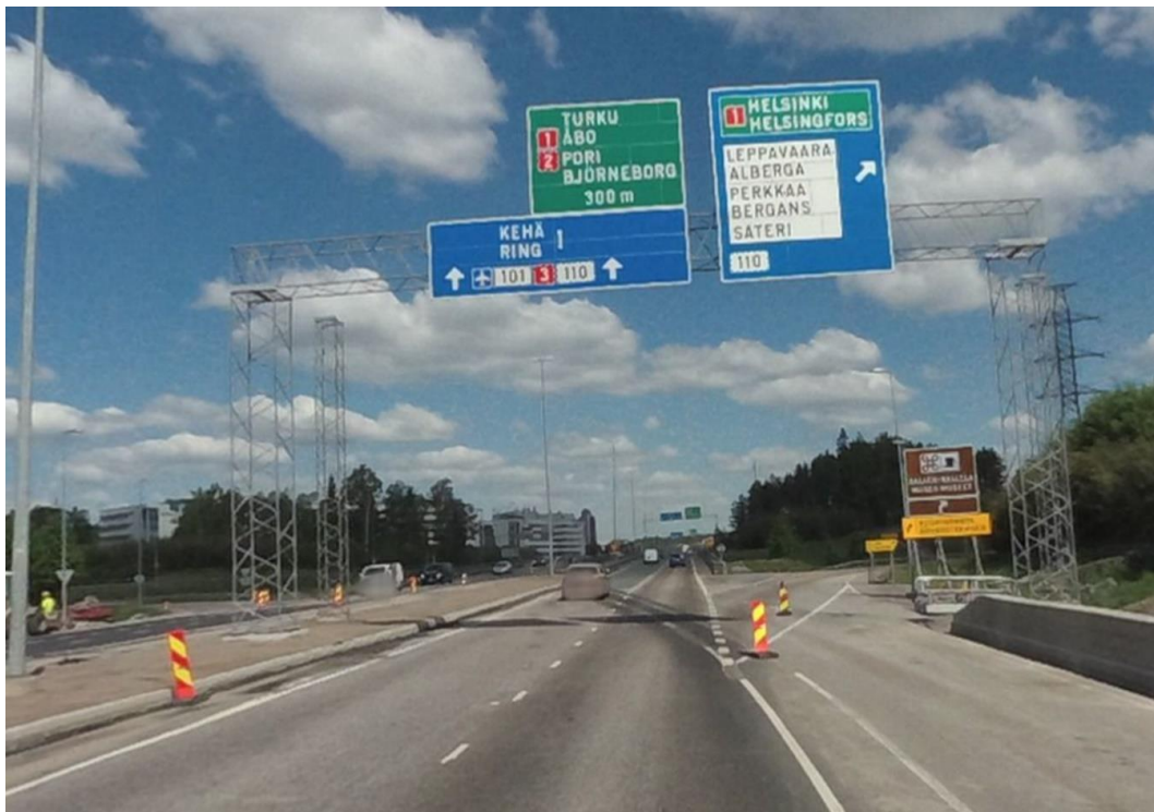
Kuva 54. Yläpuoliset opasteet ja tiemerkinnät ovat ristiriidassa keskenään.
