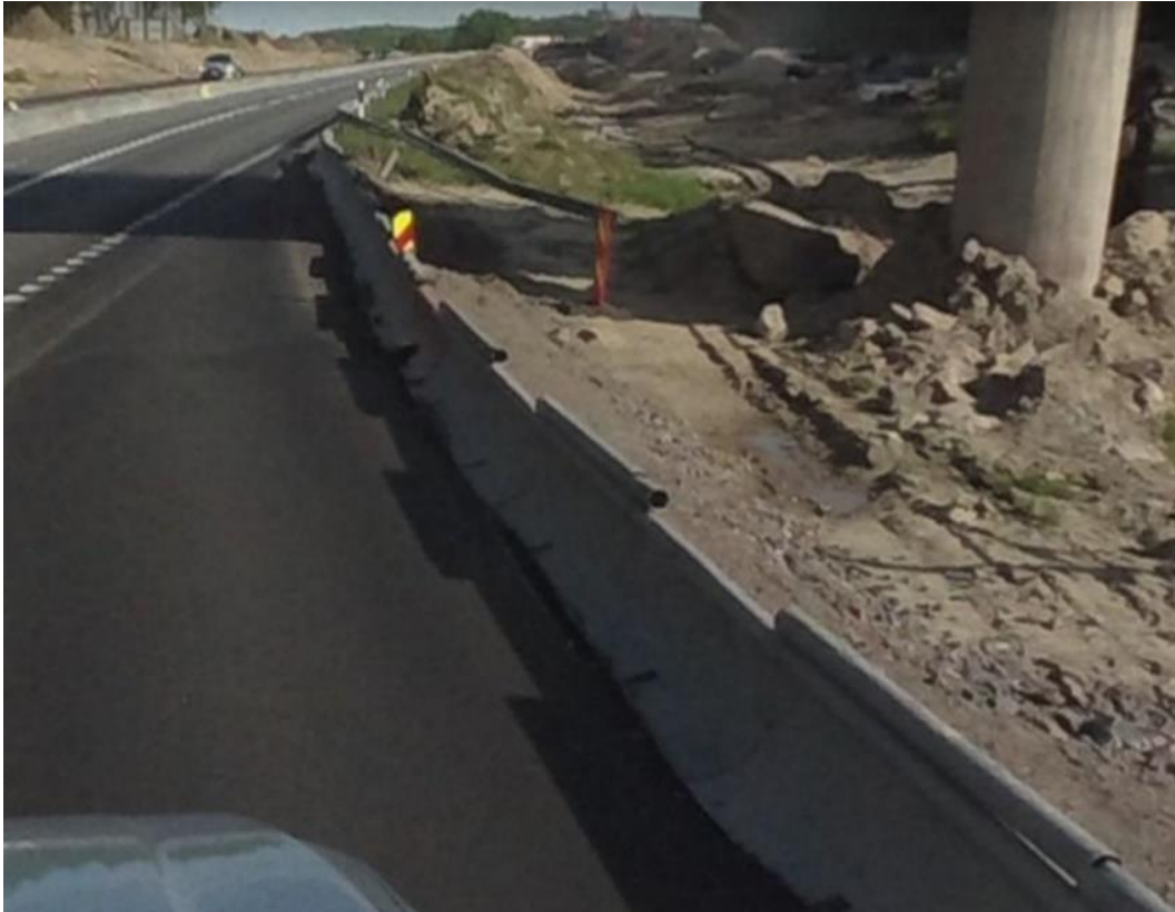
Kuva 32. Kaidetta ei ole koottu valmistajan ohjeiden mukaan.
