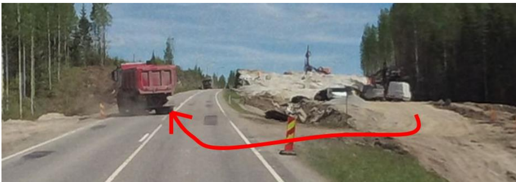
Kuva 29. Oikealle työmaa-alueelta kääntyvä kuorma-auto ei käännä suoraan omalle kaistalleen.
