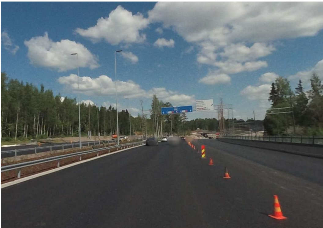
Kuva 40. Sulkukartioita oli käytetty työmaan päällystämisen yhteydessä.
