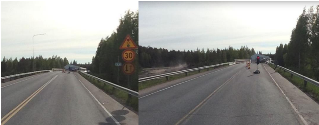
Kuva 17. Viralan eritasoliittymän siltatyömaata idästä länteen.
