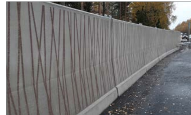
Kuva 59. Esimerkki graafisella betonilla toteutetusta melukaiteesta, Kouvola. Kuva: Laura Soosalu.
