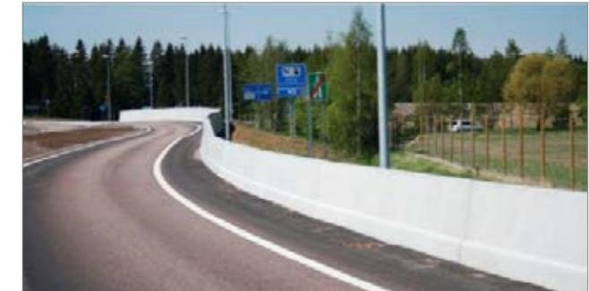
Kuva 62. Esimerkki matalasta betonikaiteesta, joka soveltuu avoimeen maisemaan, Step-betonikaide. Kuvan lähde: www.rudus.fi
