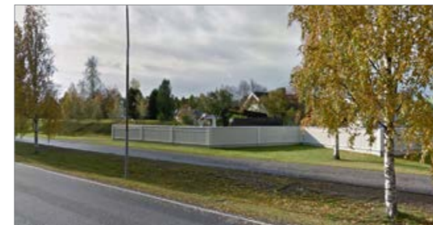
Kuva 60. Esimerkki puurakenteisen meluesteen ja meluvallin soveltamisesta rakennettuun ympäristöön, Oulunsuuntie, Oulu. Maisema ja taajamakuva määrittelevät sopiiko valliin metsitys, puu- ja pensasistutukset vai niitty tai nurmi. Kuvan lähde: Google Maps.
