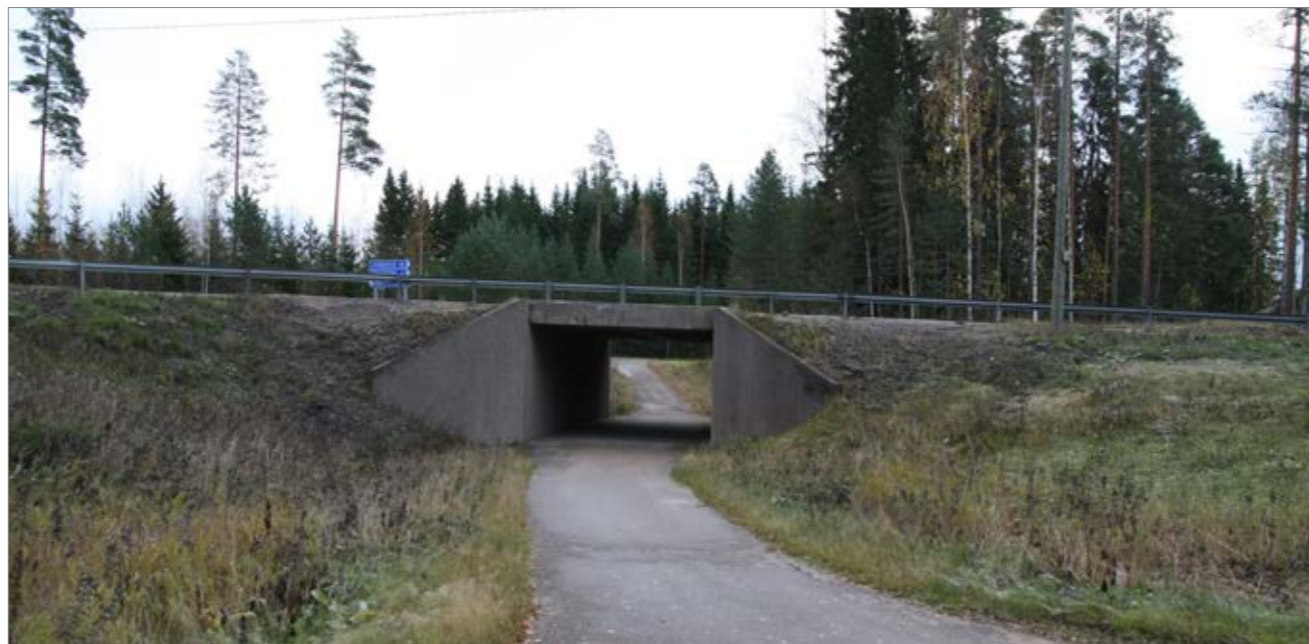
Kuva 2. Alikulkukäytävä maantien 16801 liittymän eteläpuolella Mämmenkylässä.
