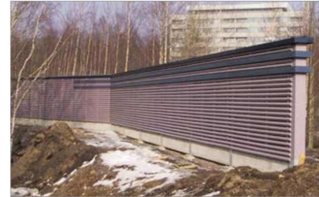
Kuva 58. Esimerkki puisesta meluaidasta, Kehä I. Kuvan lähde: Meluaidat/Versowood
