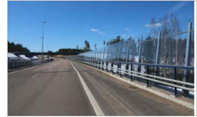
Kuva 61. Esimerkki läpinäkyvästä meluesteestä maisemallisesti tärkeällä tiejaksoilla (materiaali polykarbonaatti), Vt 7 Hamina-Vaalimaa. Kuvan lähde: Meluseinät – tehokas ja esteettinen meluntorjunta | Blogi | Vink Finland Oy
