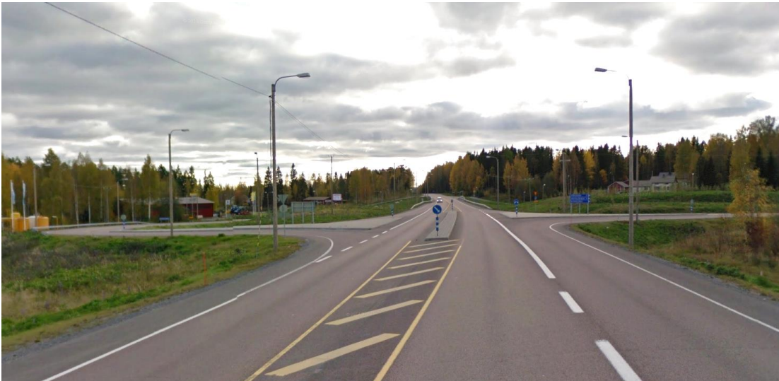
Valokuva. Niemisjärven eritasoliittymä.
