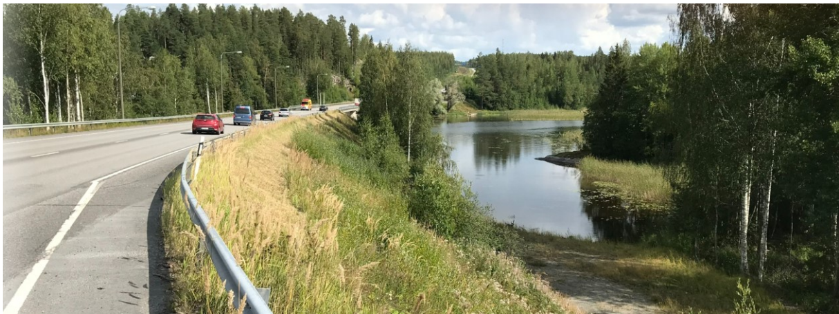
Kuva 3.24 Tie ylittää Leppäveden toistamiseen Metsolahden kohdalla.
