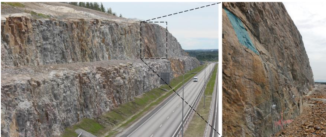
Kuva 20. Yleiskuva Kirrinmäen idänpuoleisesta kallioleikkauksesta. Detaljikuva näyttää tieväylän suuntaan viettäviä tasomurtumia ja kohteeseen asennettu kallioverkotus. Valokuvat: Jasper Tainio 2022.
