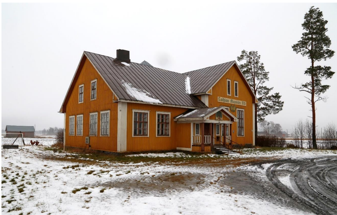
Figur 7-19. Alapää byagård i Laihela.
