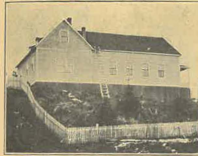
Sointulan osaston talo.
