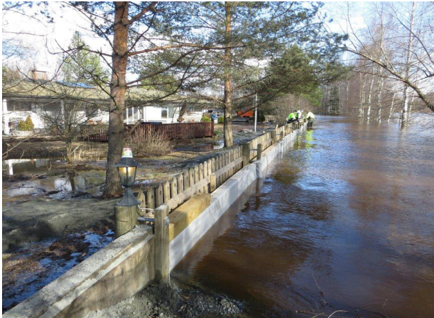
Bild 8. Exempel på översvämningsskydd: a) översvämningssvall, som vid behov höjs mha. plankor/sponter (Jalasjärvi), b) Anti Flood barrier – en tillfällig översvämningssbarriär. (©LUBAWA)
