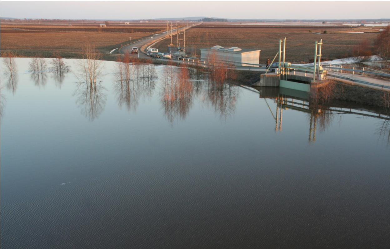
Bild 14. Pumpstationen och översvämningssluckan vid Löyhinki 12.4.2010. (Katja Haukilehto)
