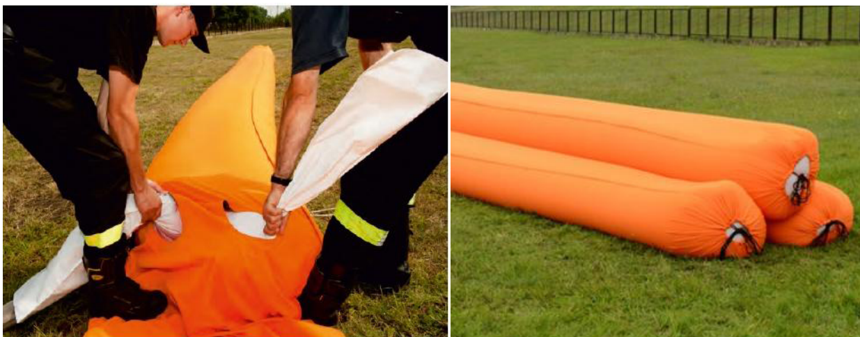
Bild 7. Exempel på översvämningsskydd. Räddningsverkets tillfälliga översvämningsskydd, s.k. översvämningstub, i bifurkationsområdet mellan Toby-Laihela å och Kyro älv (Vasa).
