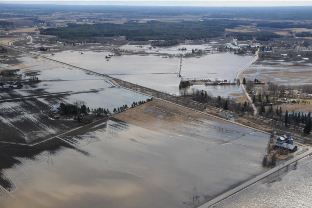
Bild 22. På våren 2013 tryckte översvämningsvattnet mot båda sidor om banvallen. Perspektiv sett från Kyro älv. (Bild: Unto Tapio)
