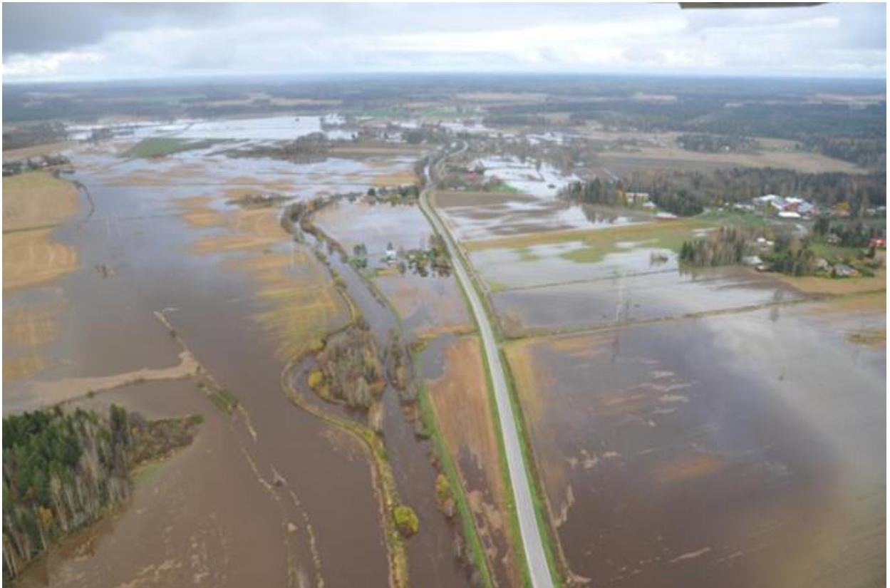
Bild 26. Vid höstfloden i Karkmo 2012 steg vattnet upp på åkrar i vidsträckt område och flera byggnader fuktskadades. (Bild: Unto Tapio)
