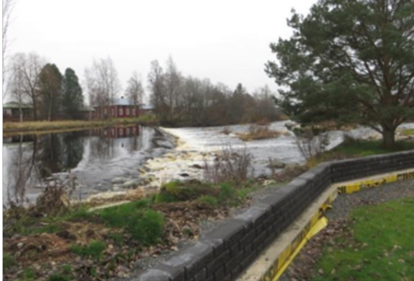
Bild 7 och 8. Exempel på översvämningvallar och -barriärer som byggdes vid Holmfors (t.v.) och Nybron (t.h.) i Lappfjärd under första skedet. (Liisa Maria Rautio)
