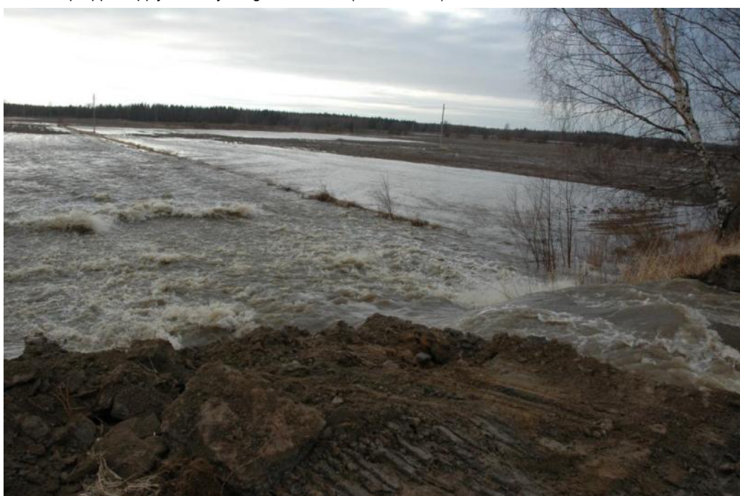
Bild 21. I nedre loppet av Lappfjärds å öppnades en vall för att minska översvämningsskadorna våren 2013. (Kim Klemola)
