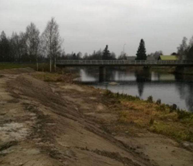
Bild 7 och 8. Exempel på översvämningvallar och -barriärer som byggdes vid Holmfors (t.v.) och Nybron (t.h.) i Lappfjärd under första skedet. (Liisa Maria Rautio)
