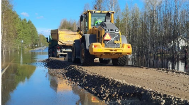
Kuva 6.9. Tien tilapäinen korottaminen maa-aineksella (kuva: Lapin ELY-keskus).
