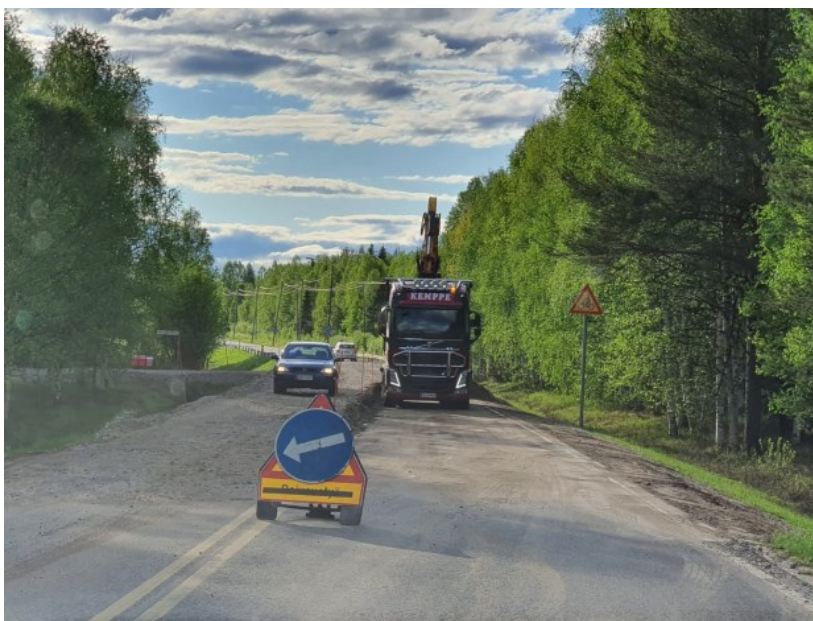
Kuva 28. Tilapäisen tienkorotuksen poisto (kuva: Lapin ELY-keskus).
