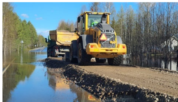
Kuva 26. Tien tilapäinen korottaminen maa-aineksella (Kuva Lapin ELY-keskus).
