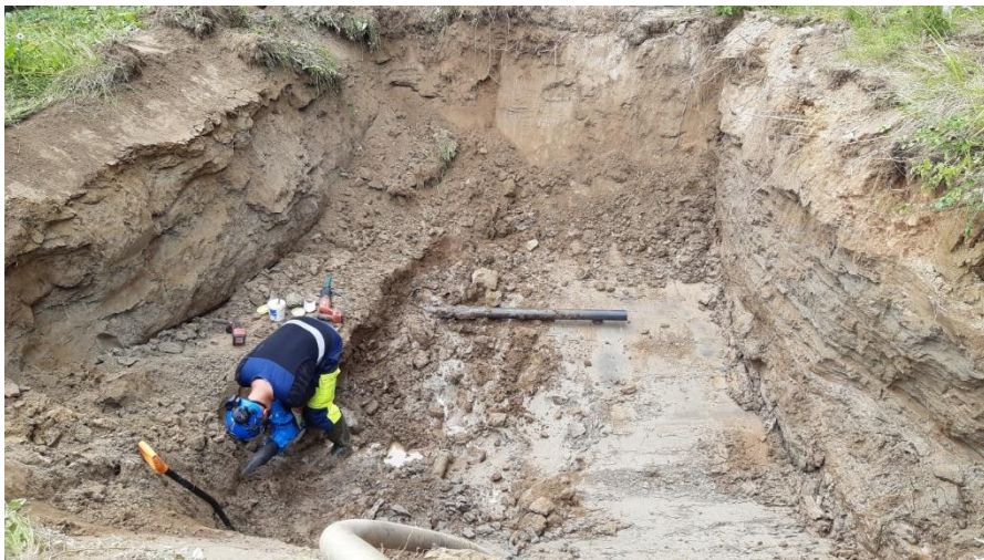
Vuotava öljysäiliö saattaa aiheuttaa merkittäviä maansiirtotöitä (kuvat: Kari Illmer).
