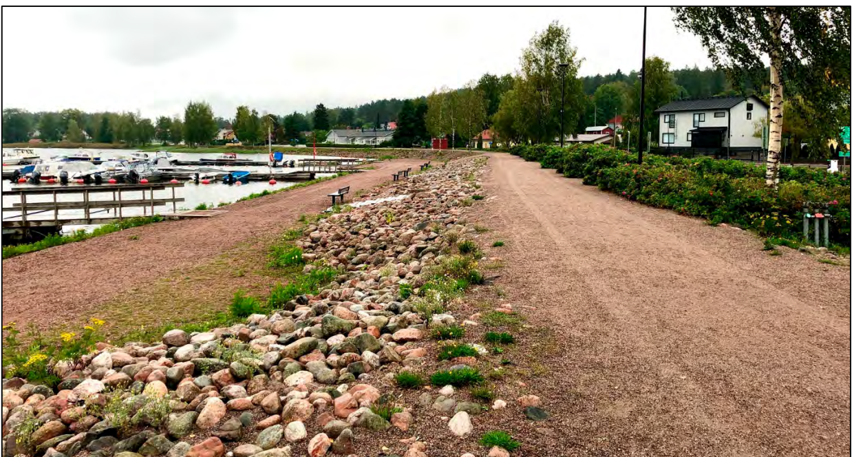
Kuva 2.3-1. Loviisan keskustan tulvapengerä, näkymä Laivasillalta etelän suuntaan 9.9.2019
