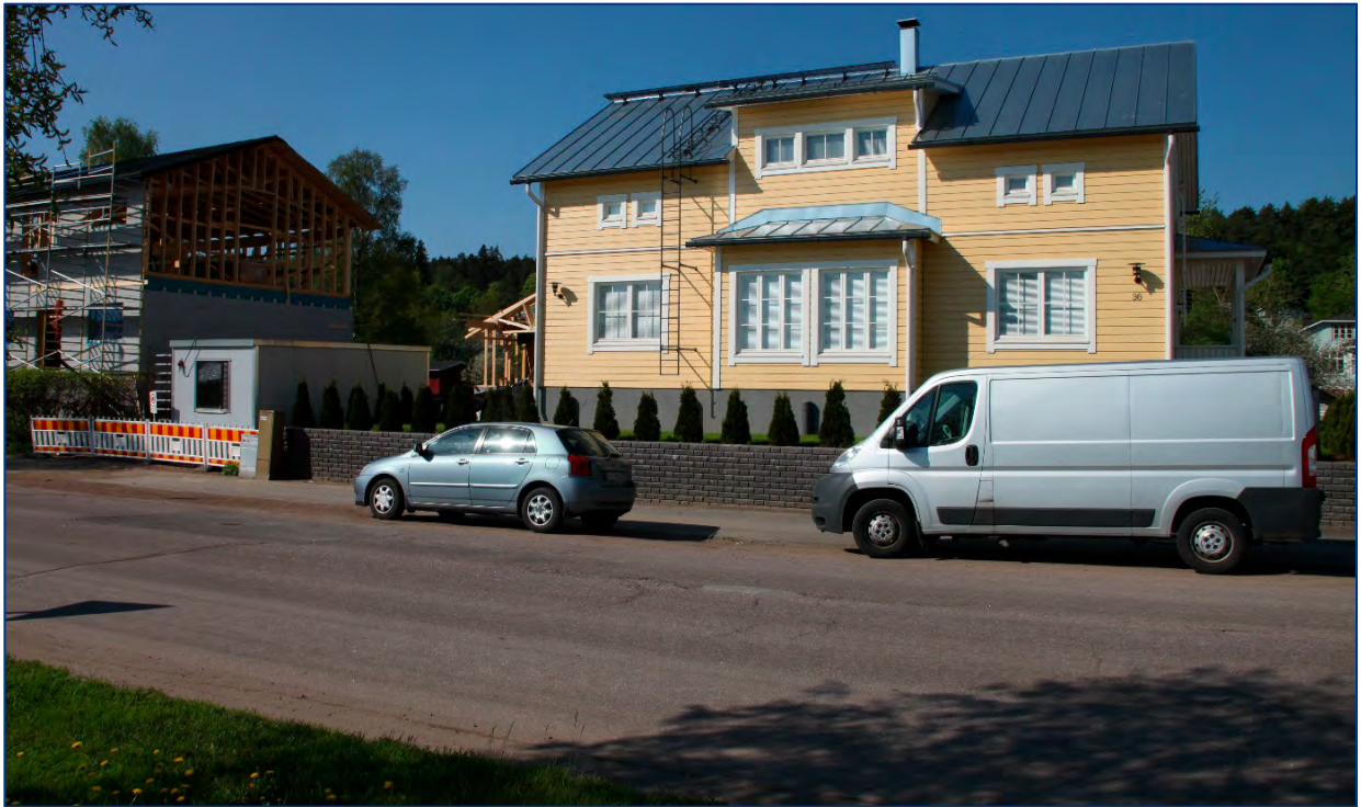
Kuva 5.1.1-1. Rantatien varrella meritulvien vaara-alueella olevia uusia sekä valmisteilla olevia asuinrakennuksia Loviisan keskustan tulvanpenkereen taustalla. Uusissa rakennuksissa on otettu huomioon alimmat suositellut rakennuskorkeudet, mikä on nähtävissä sokkeleiden korkeudessa. (Kuva: FCG Suunnittelu ja tekniikka Oy pvm. 23.5.2014)
