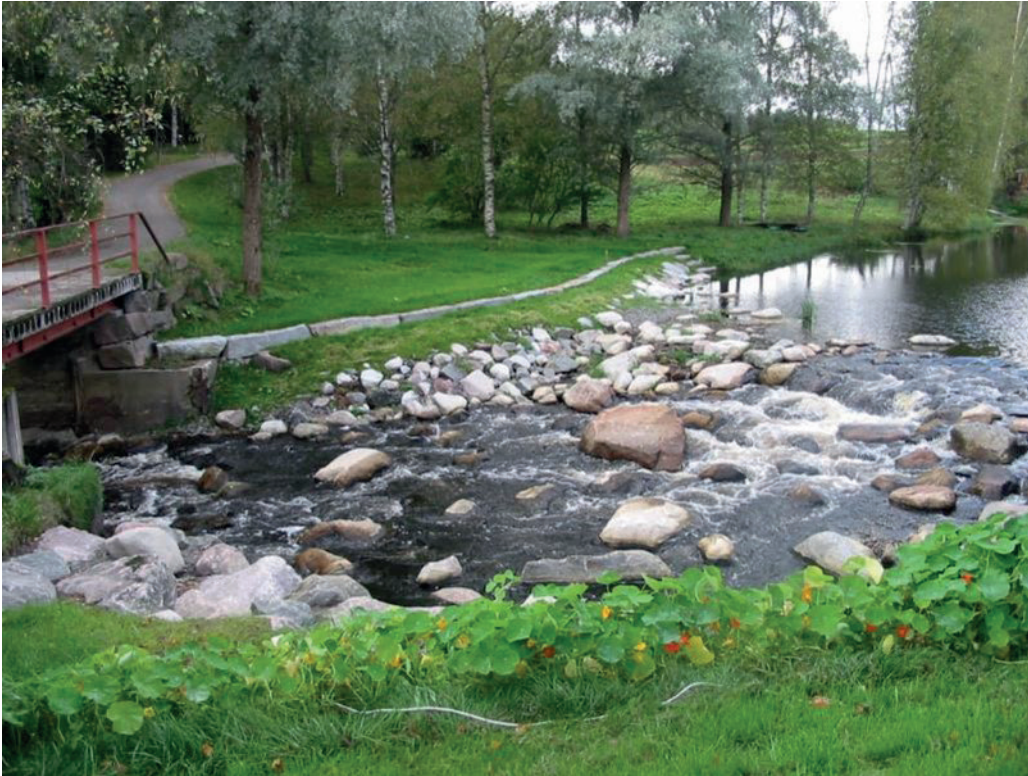
Kuva 45. Kalan kulun mahdollistava luonnonmukainen pohjapato Renkajoen Hinkaloistenkoskella. Kuva Kari Rannisto.
