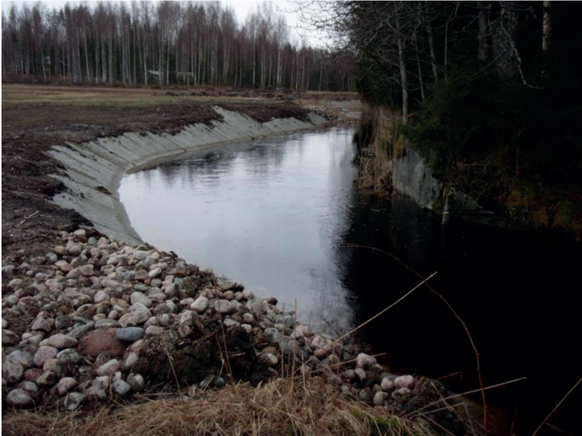
Kuva 43. Eroosiolaattoja Tammelan Heinijoella. Eroosiosuojaukset vähentävät penkkojen sortumista jokeen ja sitä kautta kiintoaineen ja lietteen kertymistä uomaan. Kuva Heini-Marja Hulkko.
