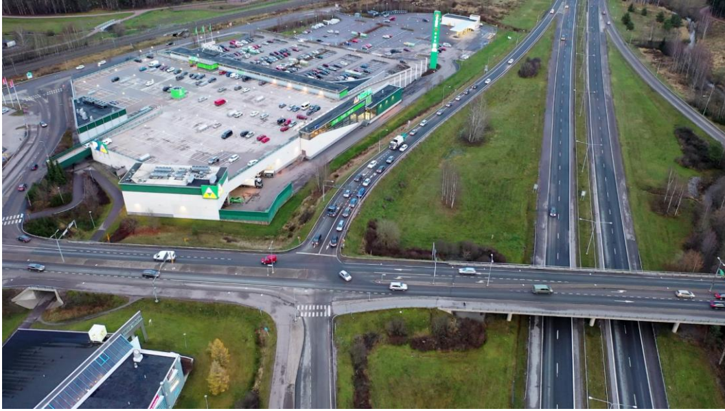
Kuva 9. Kt51:n pohjoinen ramppitasoliittymä, Kirkkonummi.
