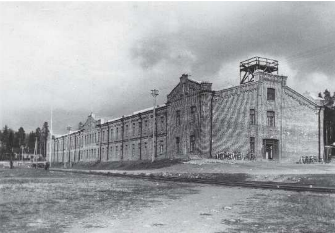
Poliittisista rikoksista tuomitut pyrittiin sijoittamaan Tammisaaren pakkotyölaitokseen, jonka läntinen kasarmi kuvassa. (Kansan Arkisto)
