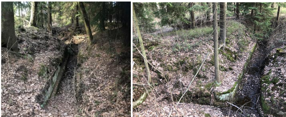
Kuva 4. Linnoitusketjun rakenteita Pirkkolan urheilupuiston pururadan varrelta, aivan Kehä I:n kupeesta. Kuvat kirjoittajan.
