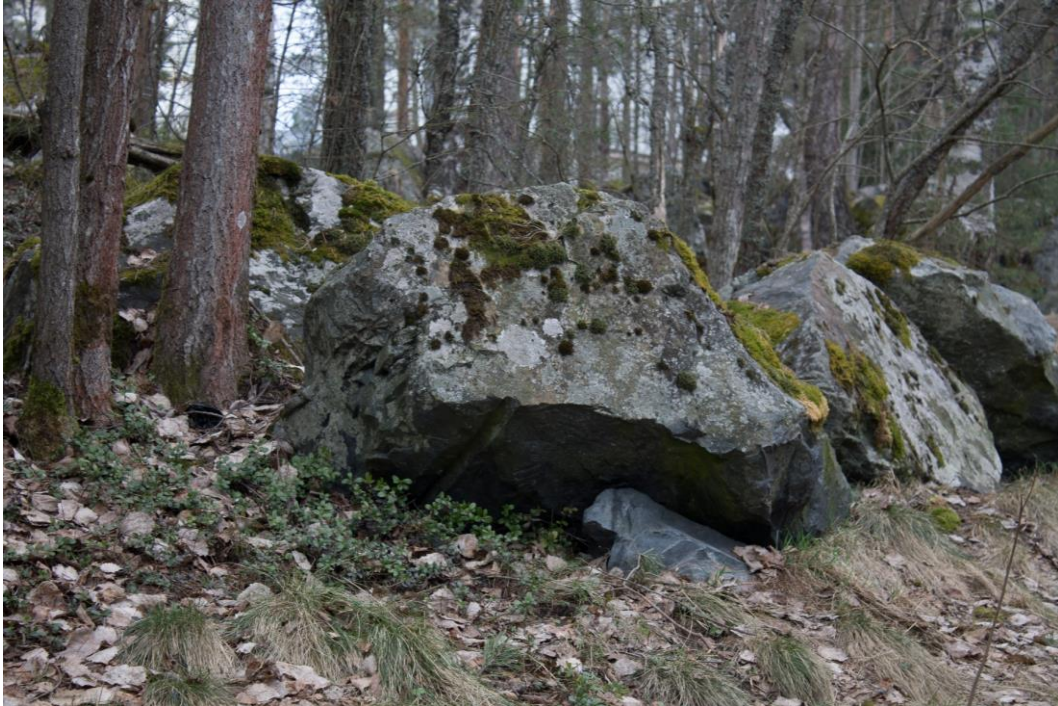
Kuva 3. Urakansuun kallioleikkauksesta on jäänyt jäljelle kallioiden päälle kiviröykkiötä. Kivissä on selviä porausjälkiä. Kuva: Roosa Ruotsalainen/Suomen Rautatiemuseo.
