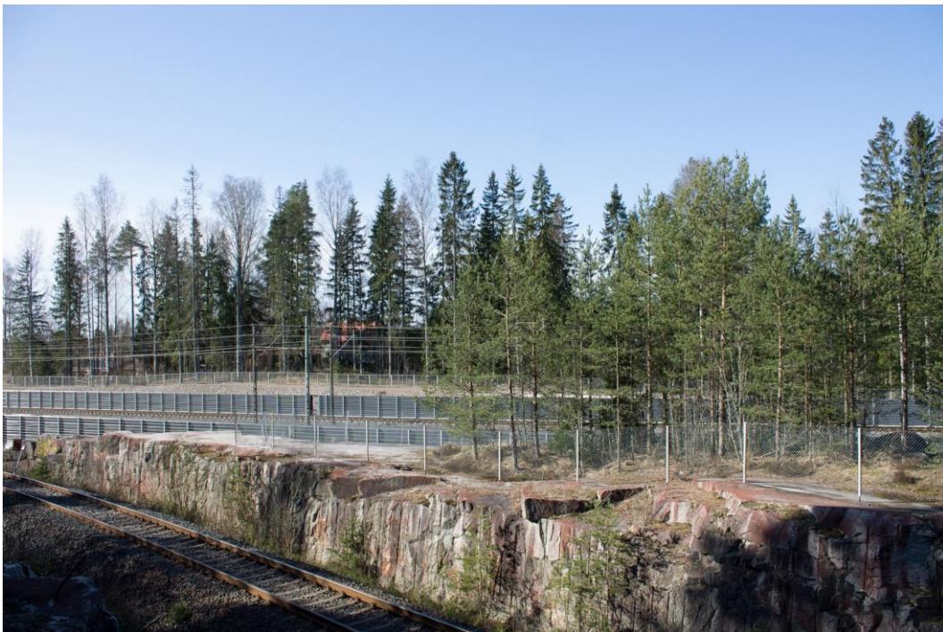
Kuva 10. Wärtsilän raiteen ja pääradan yhtymäkohdassa on kallioleikkaukset molemmiin puolin raidetta. Kuva: Roosa Ruotsalainen/Suomen Rautatiemuseo.
