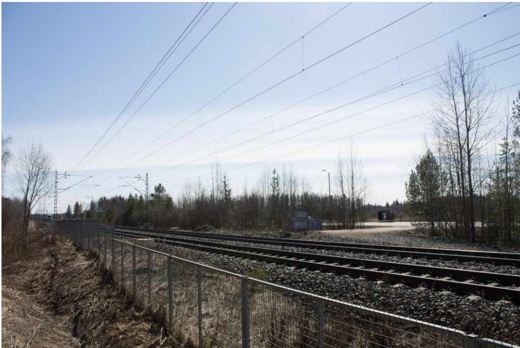
Kuva 6. Rataosuuden tasoristeykset on poistettu. Tasoristeyspaikka Huikon entisen seisakkeen kohdalla. Kuva: Roosa Ruotsalainen/Suomen Rautatiemuseo.
