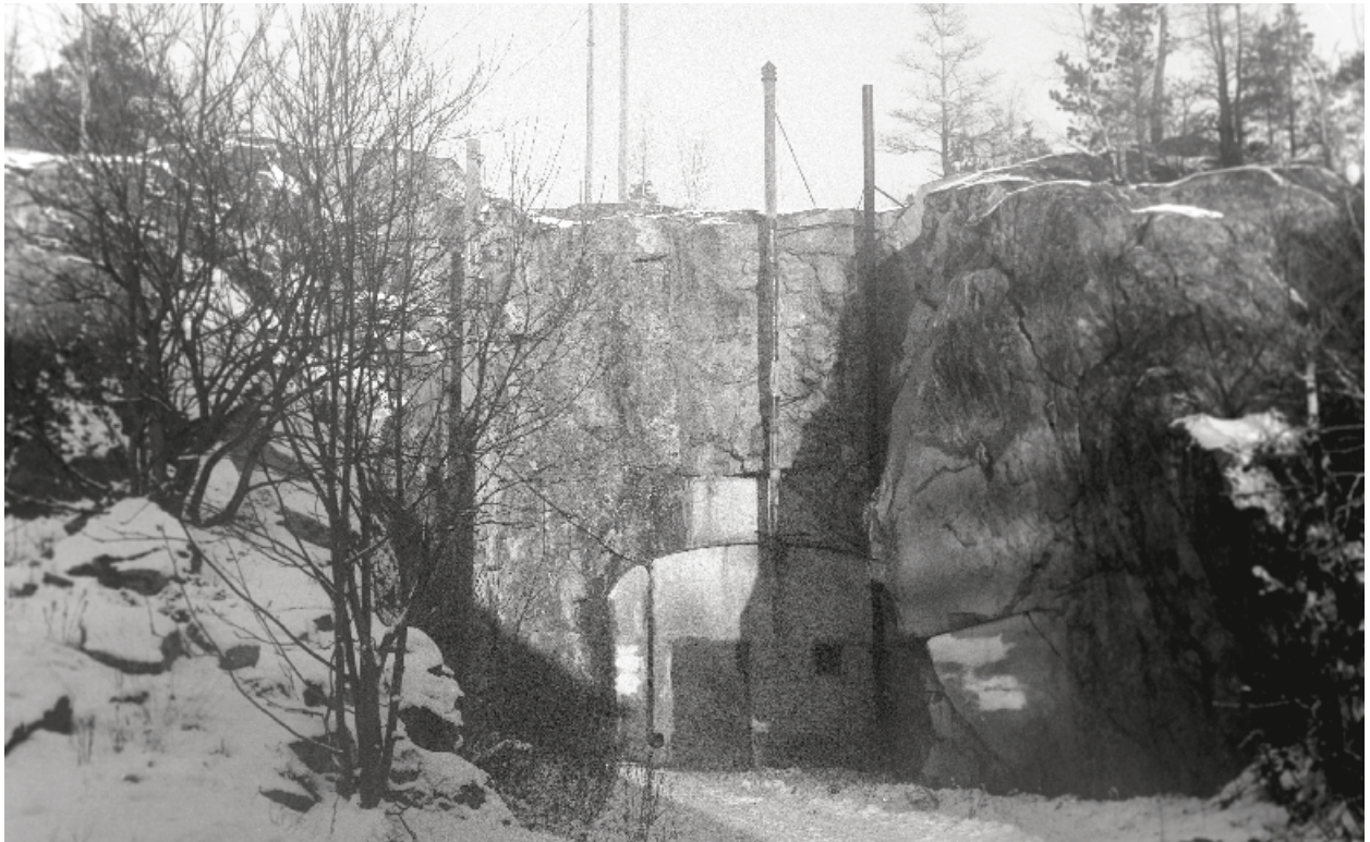
■ KOLO 1 -suunnitelman mukaan Pääesikunnan operatiivisen osaston oli valmiutta kohotettaessa tarkoitus siirtyä työskentelemään kuvan kaltaisiin suojatiloihin. Kuva: Jaakko Rautio / Puolustusvoimat, Sotamuseo.
