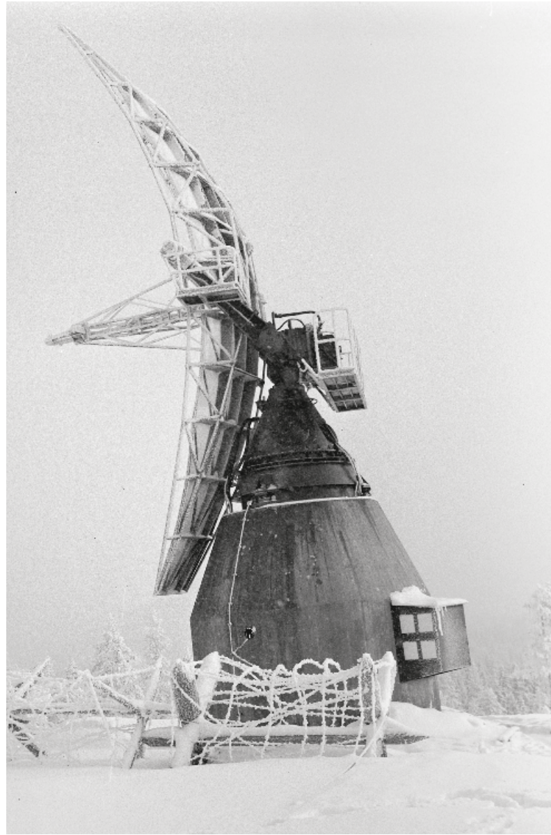
■ Ilmavalvontakykyä vahvistettiin Britanniasta hankituilla suurtehotutkilla. Decca-korkeudenmittaustutka Aitovuorella helmikuussa 1964. Kuva: Matti Kaltokari / Puolustusvoimat, Sotamuseo.
