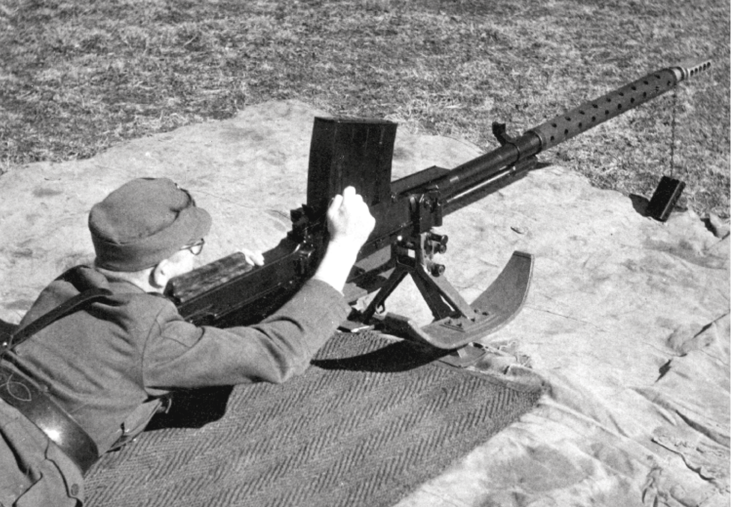
20 mm:n panssaritorjuntakiväärin tyypimerkinnäksi tuli keksijänsä Aimo Lahden mukaisesti L-39. Ase sai kokonsa ja kaliiperinsa vuoksi kutsumanimen ”norsupyssy”. Ase täytti silloiset toiveet panssarinläpäisevyydestä, mutta jäi kokeiluaseeksi, eikä ehtinyt tuotantoon ennen talvisotaa. Kuva: Aimo Lahden kokoelma / Sotamuseo
