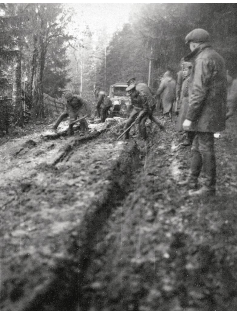
Moottoroinnin haasteena olivat huonokuntoiset tiet. Kuorma-autojen tuli olla kevyitä ja kestäviä. Kuvassa huono tie on hidastanut kuorma-auton etenemistä vuonna 1923. Kuva: Sotamuseo
