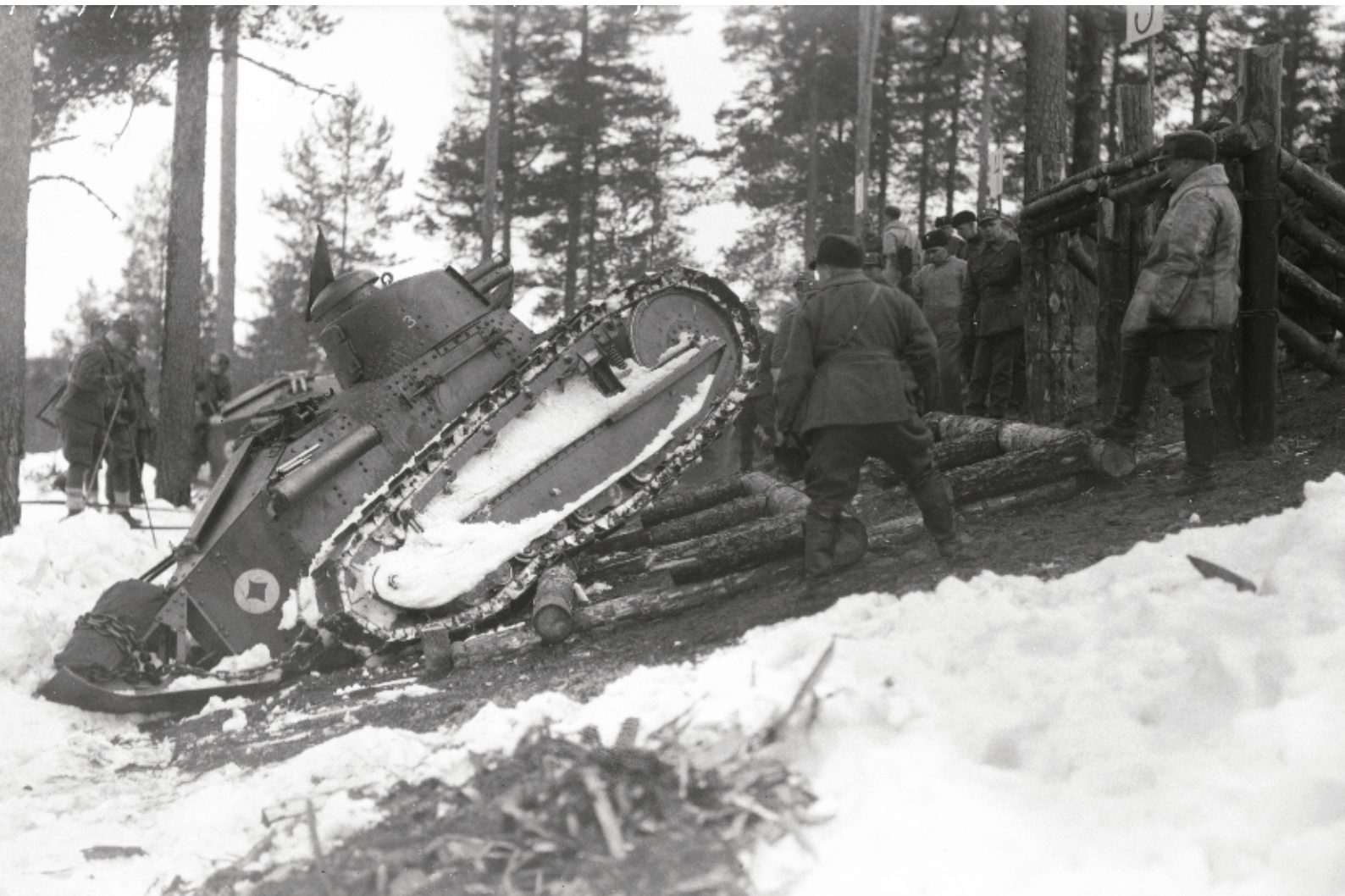
Renault-vaunu yrittää murtaa hirsiestettä hyökkäysvaunukokeiluissa Terijoella maaliskuussa 1934. Vaunu todettiin kömpelöksi, mutta sitä käytettiin kuitenkin kokeiluissa vielä 1930-luvulla. Kuva: Ilmavoimien kuvakokoelma / Sotamuseo
