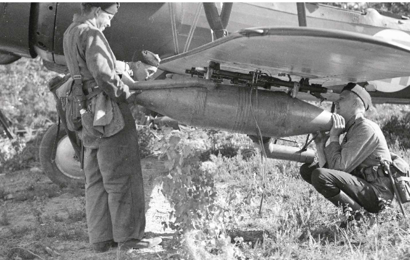
Lentokoneisiin kehitettiin kaasunlevitykseen sopivia sumutuslaitteita. Alkuperäisen kuvatekstin mukaan "kaasupuhaltajaa" kiinnitetään lentokoneeseen elokuussa 1938. Kuva: Ilmavoimien kuvakokoelma / Sotamuseo
