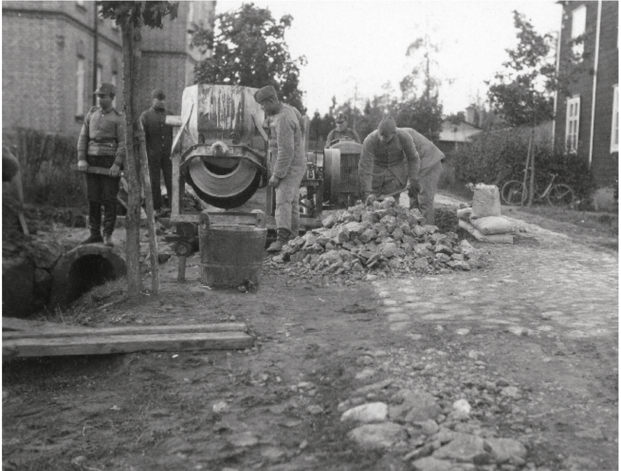
Tienrakennuksessa kokeiltiin sepelinlajittelijaa, sementin sekoituskonetta, vintturia ja edellä mainittujen käytössä tarvittavaa Fordson-traktoria. Kuvassa tienrakennusta Pioneeripataljoonassa Korian kasarmilla 1920- ja 1930-lukujen vaihteessa. Kuva: Sotamuseo
