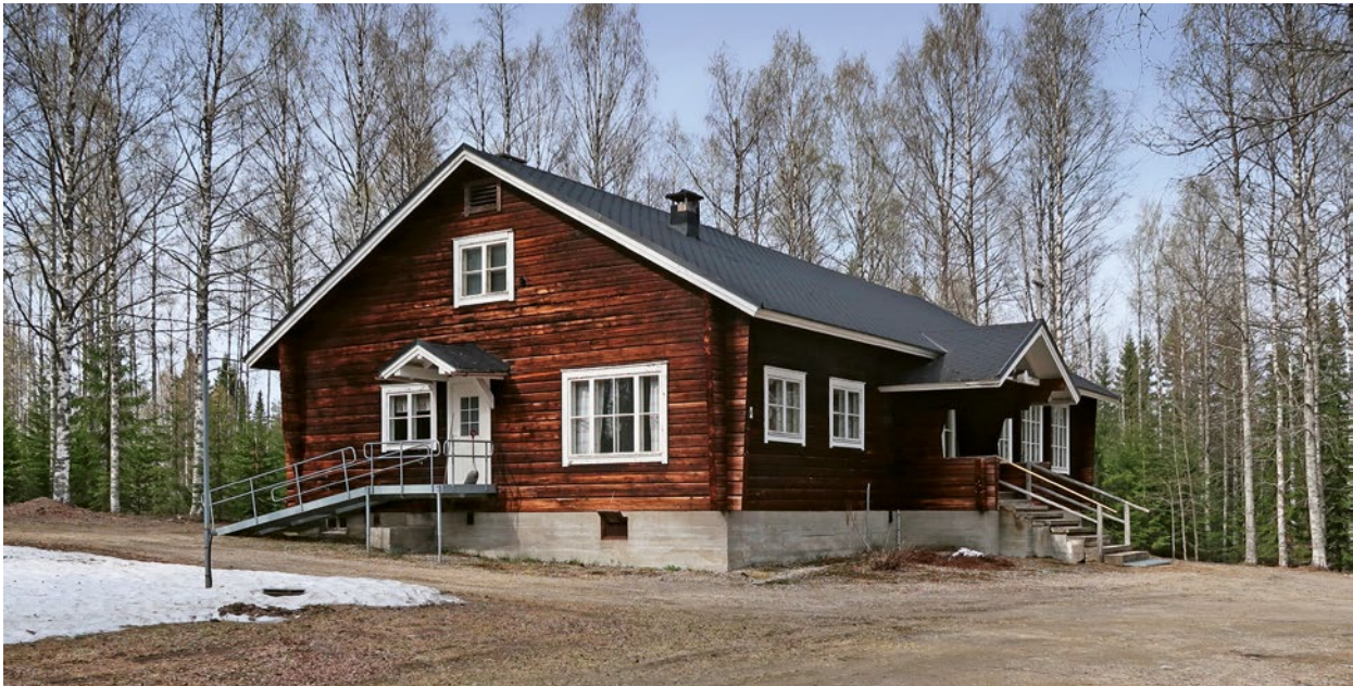
Toisen maailmansodan jälkeen Suomen itärajan ulottuviin maakuntiin toteutettiin rajaseutukirkkoja. Ilomantsissa on kaksi rajaseutukirkkoa: kuvan Naarvan kirkko (1958) ja Kivilahden kirkko (1954). Kirkkojen valmistuminen liittyi Suomessa harjoitettuun rajaseututyöhön. Sen tarkoituksena oli tukea rajaseudun asukkaita niissä ongelmissa, jotka johtuivat raja-alueiden olosuhteista. Kuva Pekka Piiparinen (2019).
