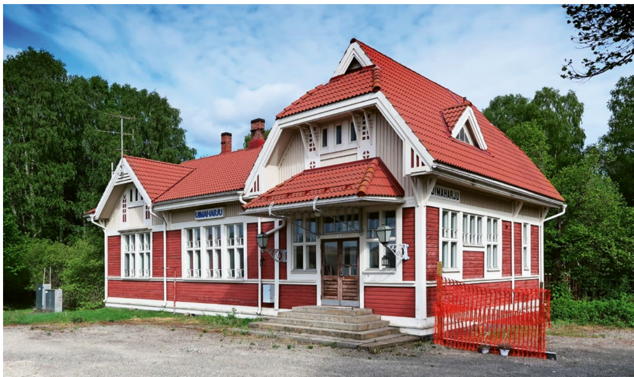
Joensuuhun kuuluvan Uimaharjun rautatieasemarakennus on tyyliltään jugendia. Aseman on suunnitellut arkkitehti Thure Hellström. Kuva Pekka Piiparinen.
