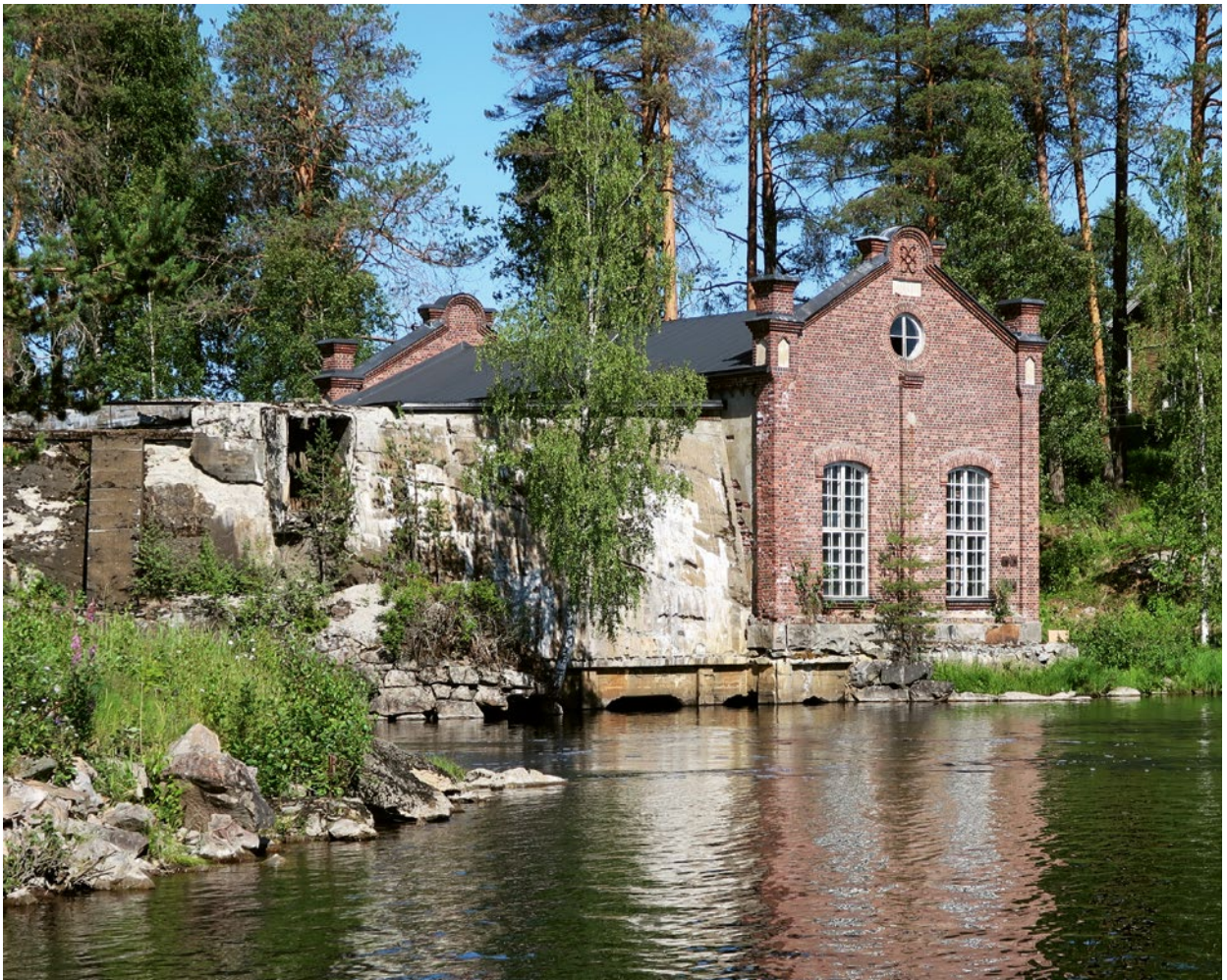
Tohmajärvellä Jänisjoen varrella on maakunnan vanhin säilynyt voimalaitosrakennus. Vuonna 1908 valmistunut Saarion voimalaitos tuotti sähköä Oy Wärtsilä Ab:n rautatehtaalle. Toisen maailmansodan jälkeen tehtaat jäivät Neuvostoliiton puolelle, joten voimalaitos on harvoja Suomen puolelle jääneitä rakennushistoriaan liittyviä todisteita Wärtsilän tehtaan historiasta. Kuva Pekka Piiparinen (2018).
