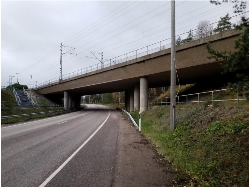
Kuva 16. Kanervan alikulkusilta on Lahden ja Kouvolan välillä hyvin tyyppilinen silta. Kuva: Jani Perttunen/Contesta Oy.
