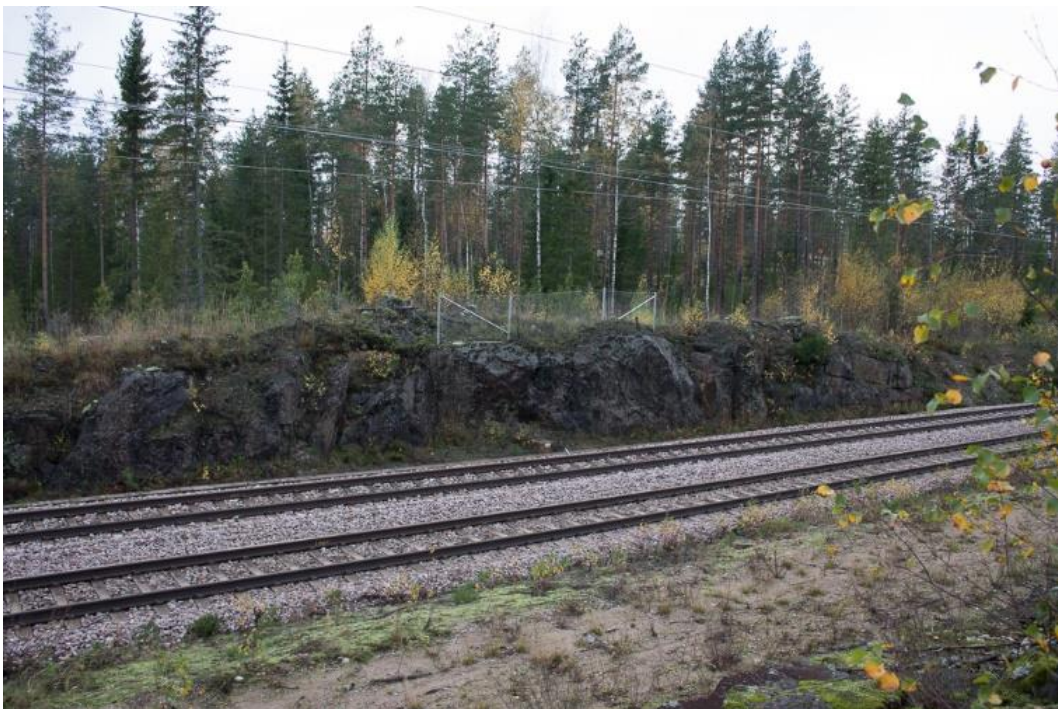
Kuva 21. Piiankallion kallioleikkaus saattaa olla jopa 150 vuotta vanha. Kuva: Roosa Ruotsalainen.
