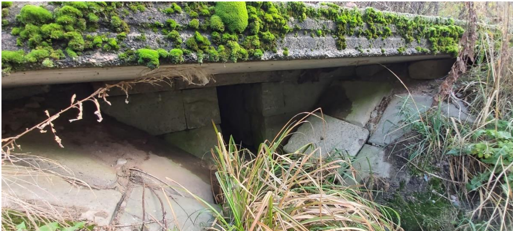
Kuva 19. Tyypillinen kivirumpu betonijatkoksella, rumpu 006 136+736. Kuva: Ari Timonen/Contesta Oy.
