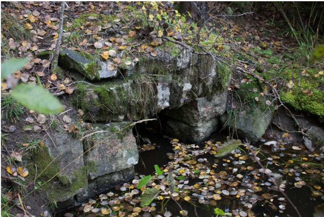
Kuva 17. Rieskan vanhan ratapohjan rumpu on luultavasti radan alkuperäinen. Kuva: Roosa Ruotsalainen.
