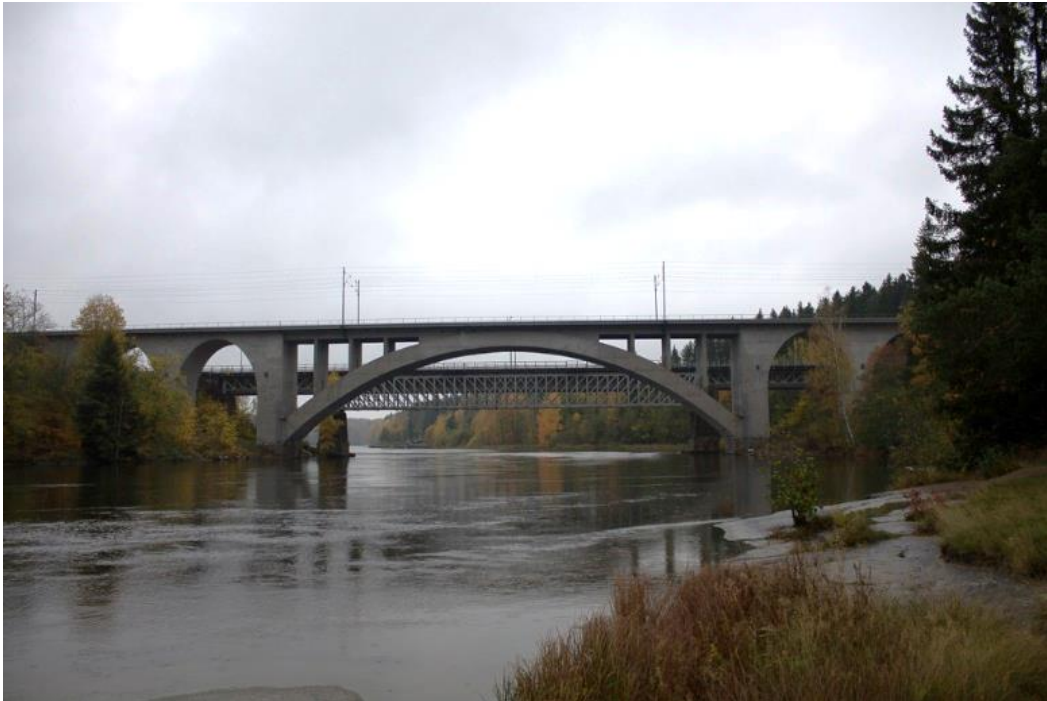
Kuva 2. Korian sillat. Etualalla uudempi betoniholvisilta, jonka takaa näkyy vanha ristikkosilta. Kuva: Roosa Ruotsalainen.
