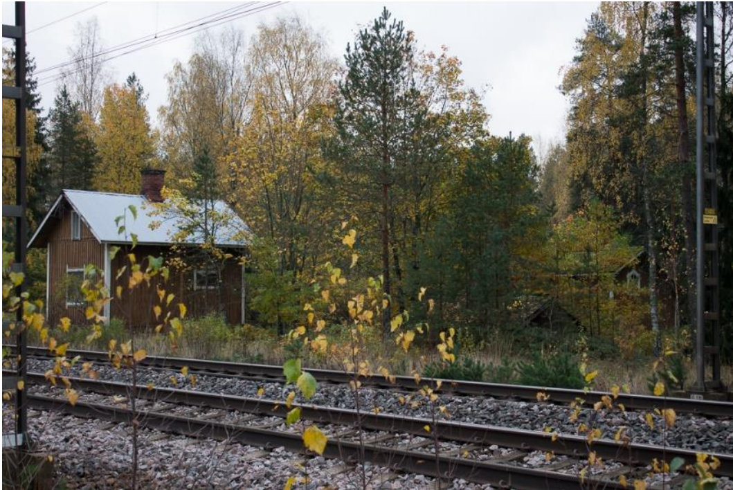
Kuva 34. Selkosaaren vahtitupa ja sen ulkorakennukset ovat yksi radan kokonaisuutena parhaiten säilyneistä vahtituvista. Kuva: Roosa Ruotsalainen.
