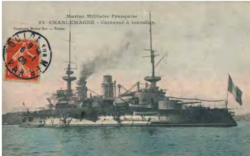
KUVA 44 • Charlemagne nähtynä perän suunnalta. Peräkannella sijaitsi ranskalaisittain ensimmäistä kertaa järeä kaksoistykkitorni, Ranska vuonna 1897.
