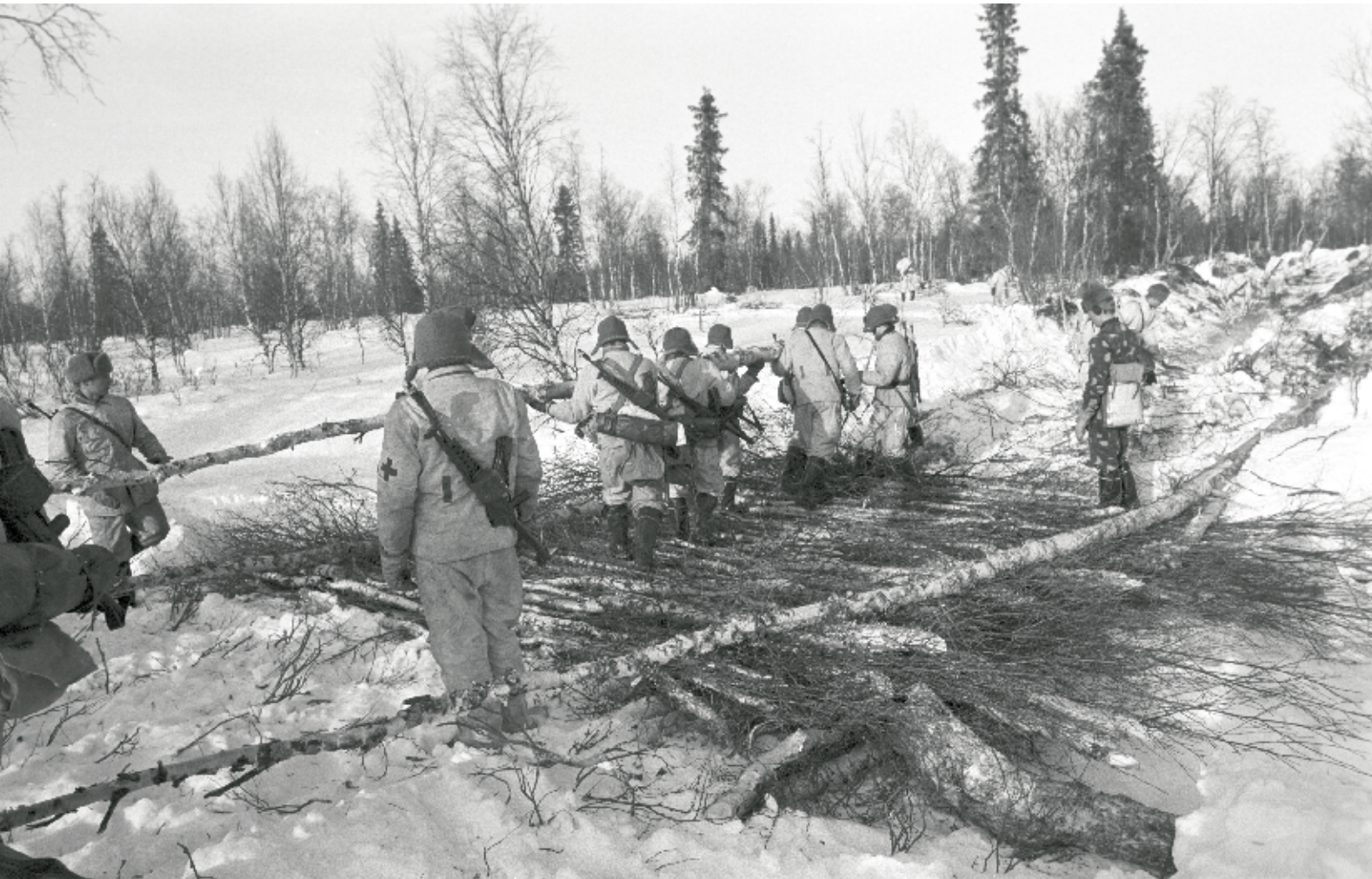
► Vaikka pääosa jalkaväestä liikkui suksin, jouduttiin pyöräajoneuvoille usein auraamaan tie koskemattomaan korpeen. Kuvassa rakennetaan tilapäissiltää puron yli käyttäen apuna paikalta saatua materiaalia. Kuva: Sotamuseo
