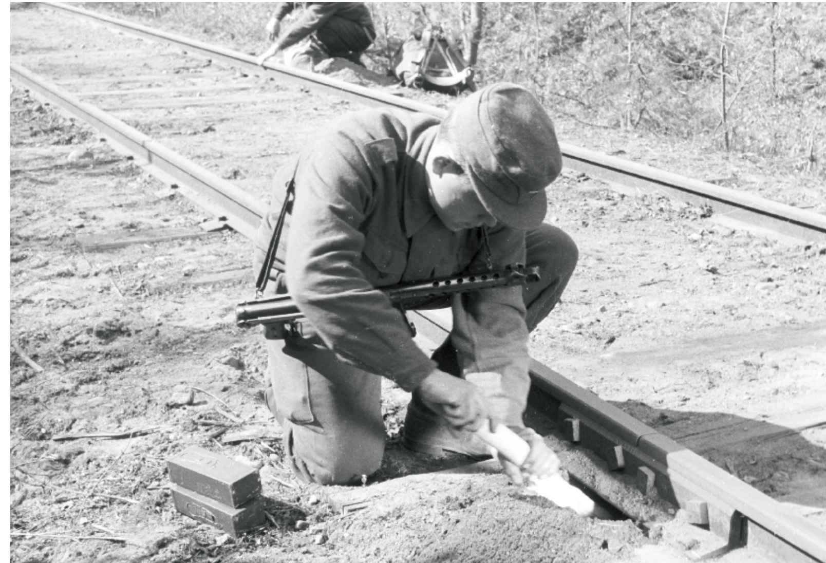
► Vihollisen etenemistä voitiin hidastaa muun muassa miinoittamalla. Rautateitse etenevän vihollisen tie katkaistiin suistamalla veturi kiskoilta. Räjähde piilotettiin kiskon alle ja räjäytettiin täyhystetyssä veturin ollessa panoksen kohdalla. Kuva: Sotamuseo
