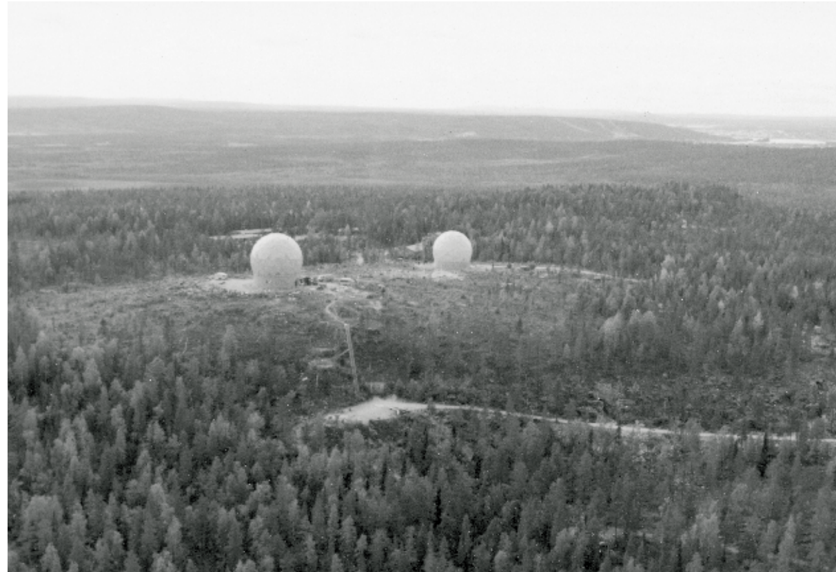
► Suurkantamatutkia käytettiin ympärivuorokautiseen ilmavalvontaan ja valtakunnalliseen lennonvarmennukseen. Kuvassa Viestikeskus 5:n suurkantamatutkat syyskuussa 1969. Kuva: Sotamuseo
