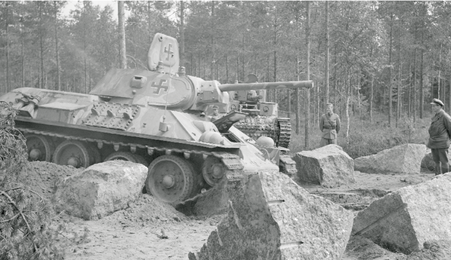
► Taavetin panssarivaunuestekokeiluissa kesäkuussa 1943 testattiin esteiden pitävyyttä ampumalla niitä panssarivaunuilla sekä ajamalla niiden läpi. Kuva: SA-kuva
