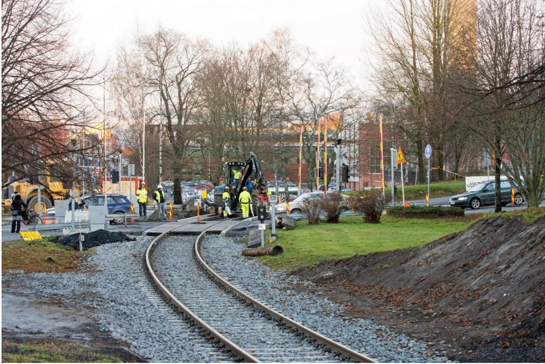
Kuva 45. Vaasan ja Vaskiluodon välinen rata peruskorjattiin Vaasan kaupungin ja Liikenneviraston yhteishankkeena loppuvuonna 2016. Viimeistelytyöt olivat käynnissä 24.11.2016 Kirkkopuiston (Wolffintie) tasoristeyksessä.
