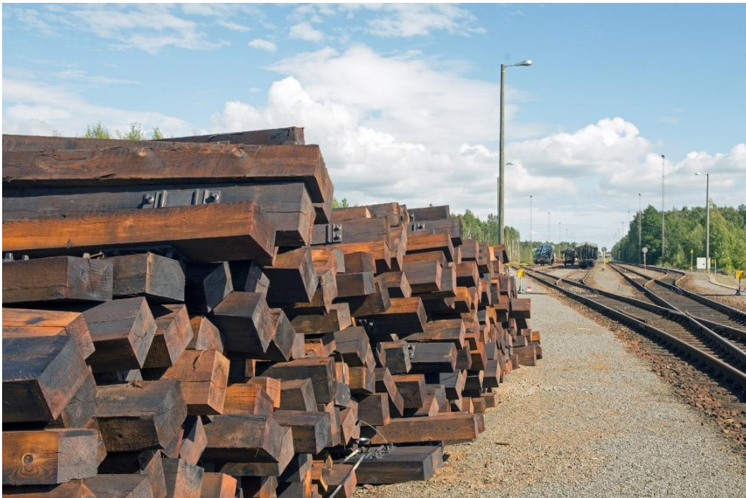
Kuva 2. Uusia kreosoottipölkkyjä odottamassa asennusta rataan Mäntyluodossa 11.7.2016.
