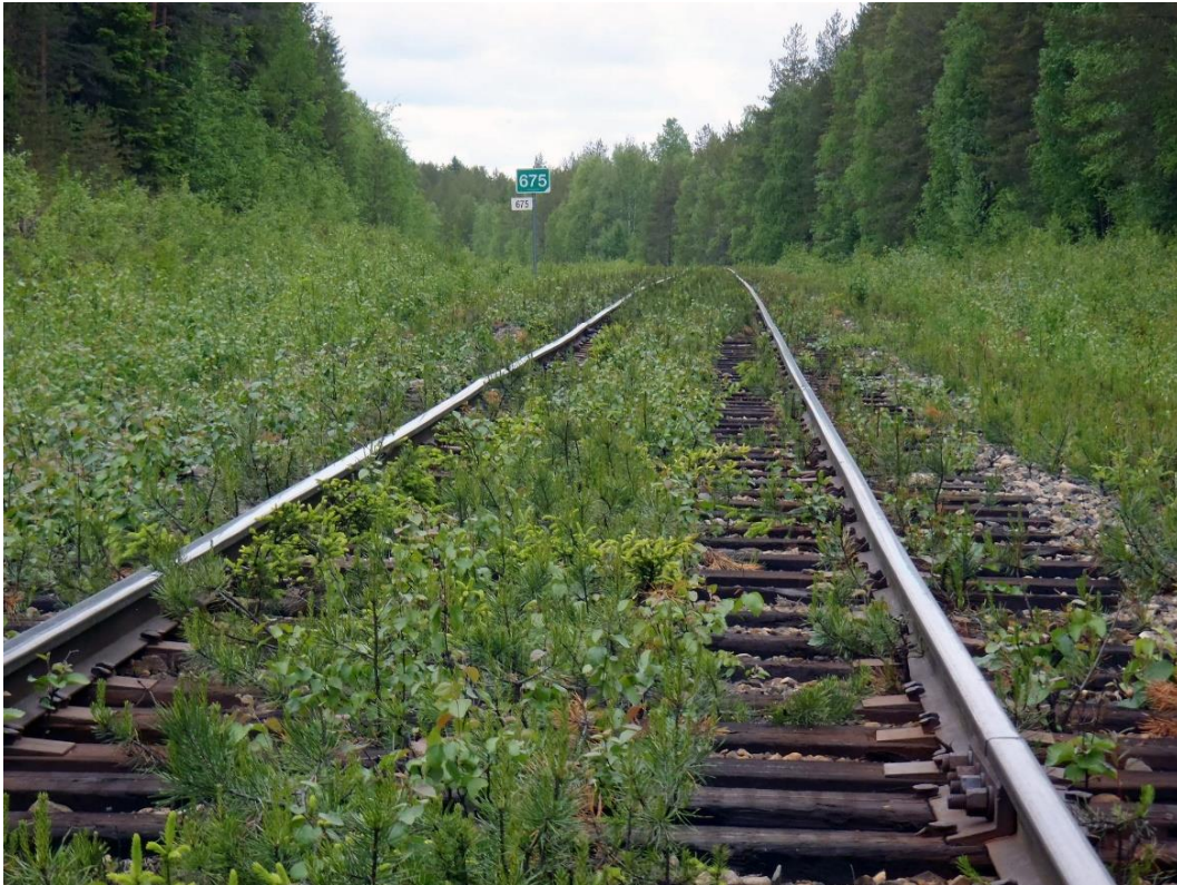
Kuva 87. Eräin paikoin lähtökohtaisesti sorapohjaisilla radoilla on merkittävästi kasvustoa, jonka mekaaninen tai kemiallinen poistaminen ei käytännössä ole kestävällä tavalla mahdollista. Kuvassa näkyvää karkeampaa raidesepeliä tukikerroksessa on vain ohuelti. Kuva: Janne Sorsa.
