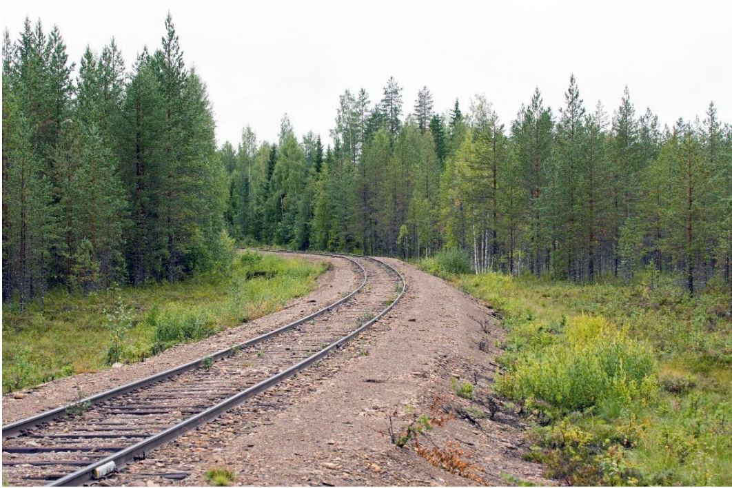
Kuva 63. Näkymä Tuupovaaran suuntaan Herajärven tasoristeyksestä 26.8.2017.
