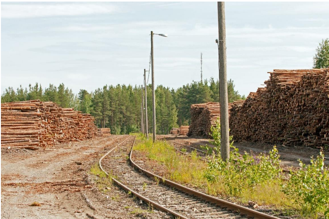
Kuva 55. Yläkosken kuormauspaikalla sijaitseva VR-Yhtymä Oy:n maalla sijaitseva yksityisraiteisto.
