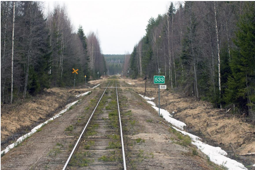
Kuva 83. Soratukikerros, kreosootilla kyllästetyt puupölkyt ja K30-kiskot Pihtiputaan ja Keitelepuhjan välillä ratakilometrillä 533; 8.5.2017.
