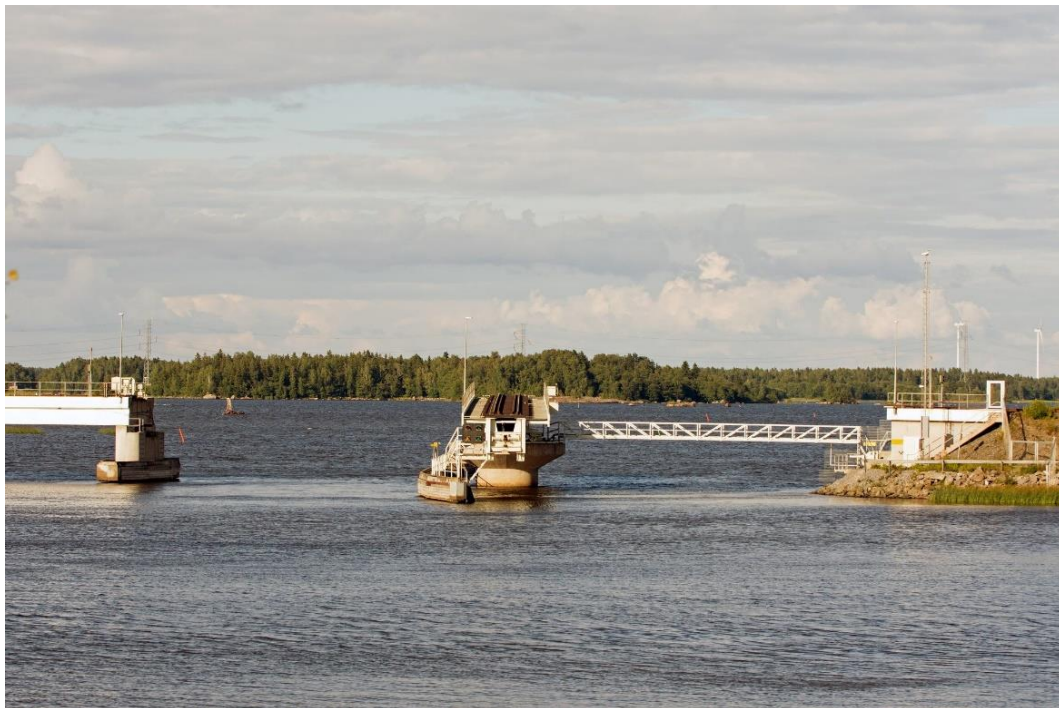
Kuva 79. Tahkoluodon avattava ratasilta pidetään vesiliikennekauden aikana tarvittaessa avoinna vesillä liikkujille kuten kuvassa. Silta suljetaan rautatien suuntaiseksi mahdollistamaan rautatieliikenne junien kuluaikoina.
