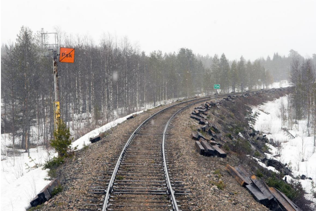
Kuva 88. Turvallisen liikennöitävyyden varmistamiseksi vaihdettiin touko-kuussa 2017 lauttavaihtona kaikki ratapölkyt Pesiökylän Ämmän- saaren suunnan lähtökaarteesta.
