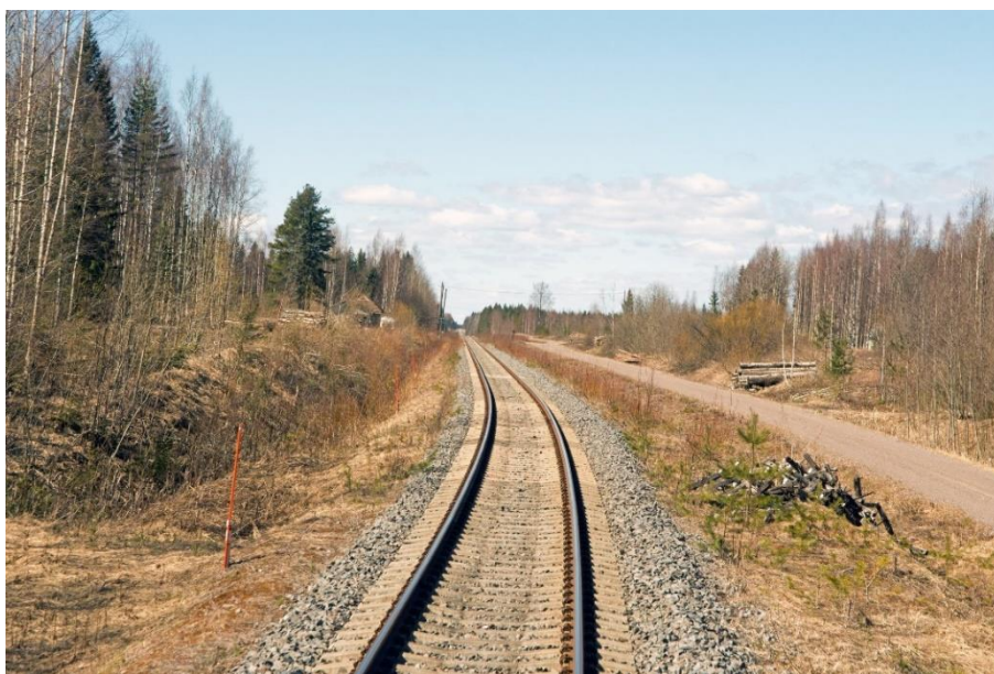
Kuva 53. Perusparannuksessa vuosina 2008–2009 rataosa Huutokosken ja Savonlinnan välillä varustettiin sepelitukikerroksella, betonipölkkyillä ja 54E1-kiskoilla.
