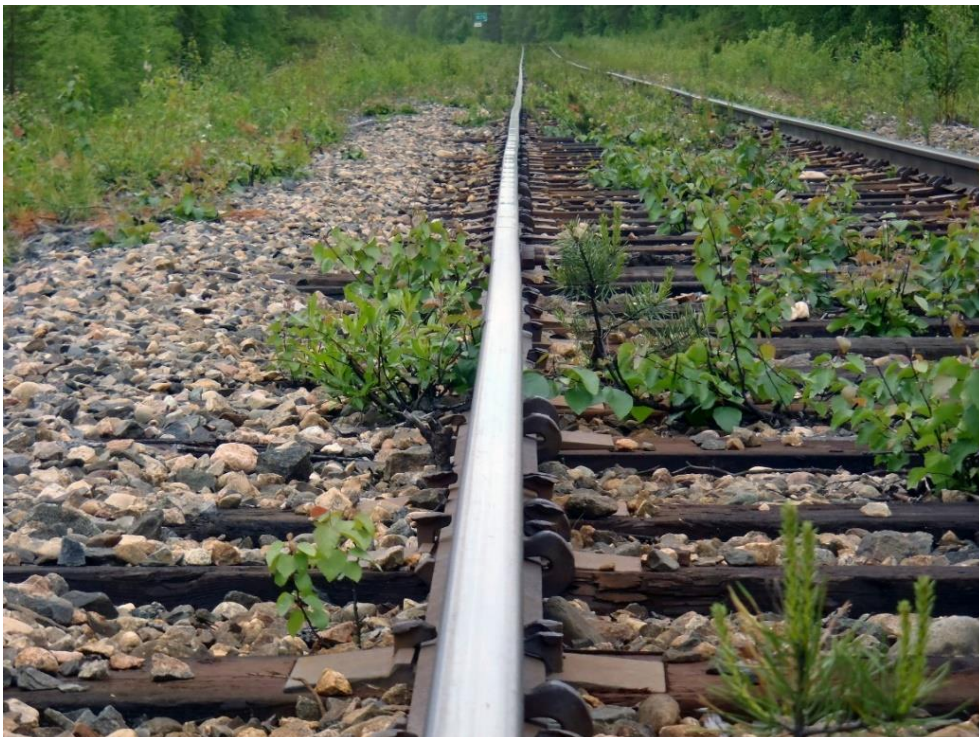
Kuva 89. Ratakiskossa esiintyvä kylmämuokkautuminen näkyy silmämääräisesti kiskon pinnan aaltoiluna. Kuva: Janne Sorsa.
