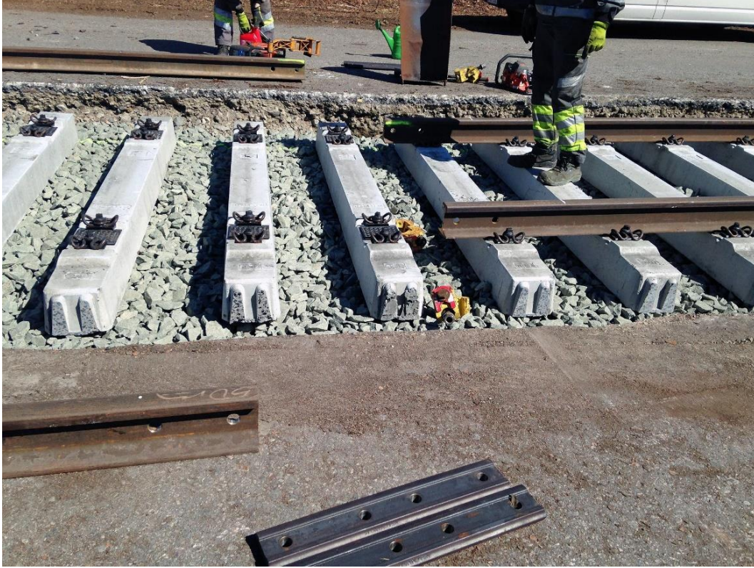
Kuva 3. Rovaniemen raakapuuterminaalin raide 666 parannettiin ratkaisulla, jossa rataan asennettiin viherpölkkyt. Kuva: Kai Kilpi.
