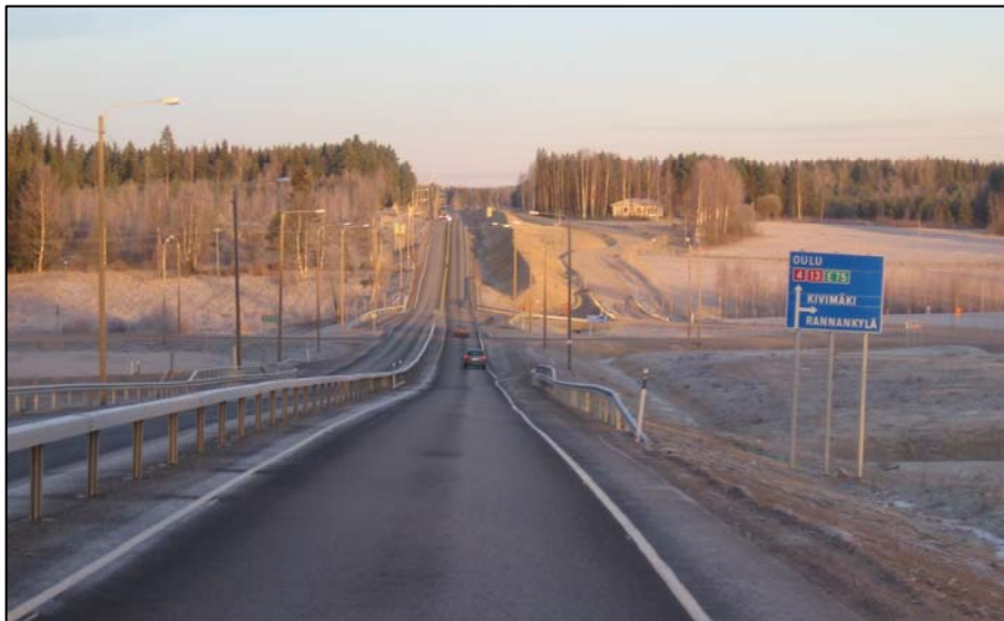
Kuva 3-2. Valtatie 4 välillä Hirvaskangas–Äänekoski. Keskikaiteosuuksien lisäksi hanke sisältää runsaasti rinnakkaistie- ja alikulkujärjestelyjä sekä meluesteitä, jotka osaltaan ovat nostaneet hankkeen hintaa.
