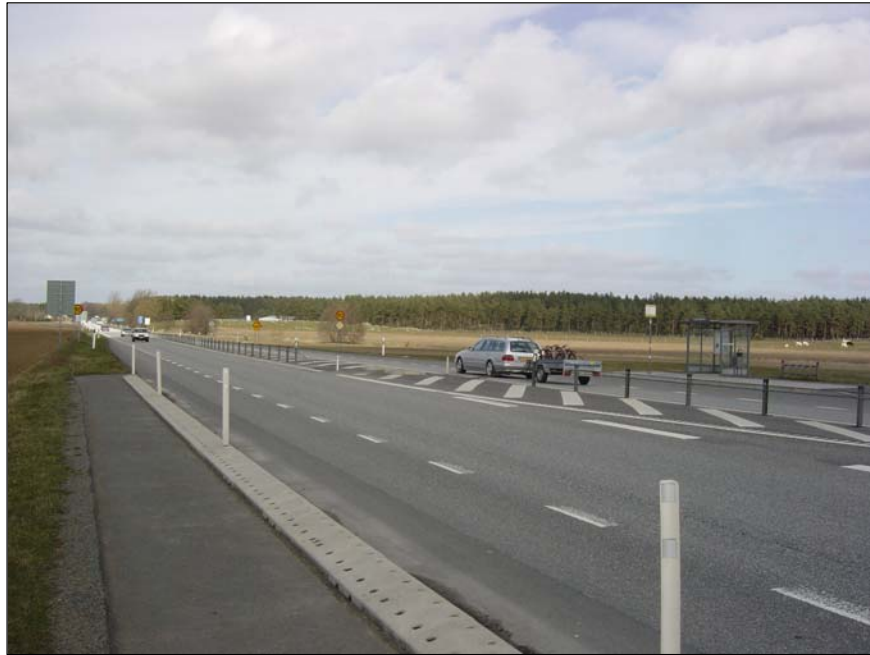
Kuva 4-15. Kevyen liikenteen ylityspaikka tasossa pysäkin läheisyydessä
