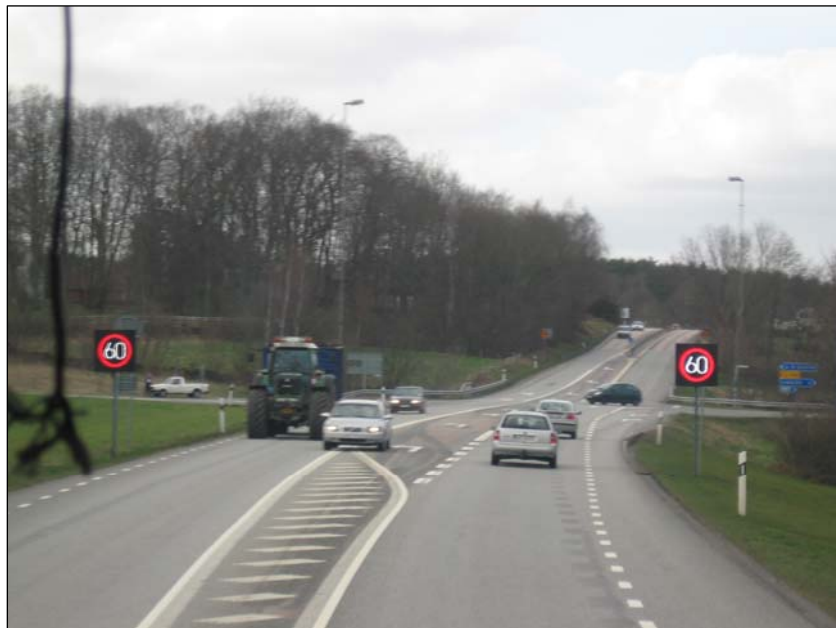
Kuva 4-13. Muuttuva nopeusrajoitus päätiellä sivutien liittymässä. Sivusuunnasta saapuva ajoneuvo aikaansaa rajoituksen alentamisen.
