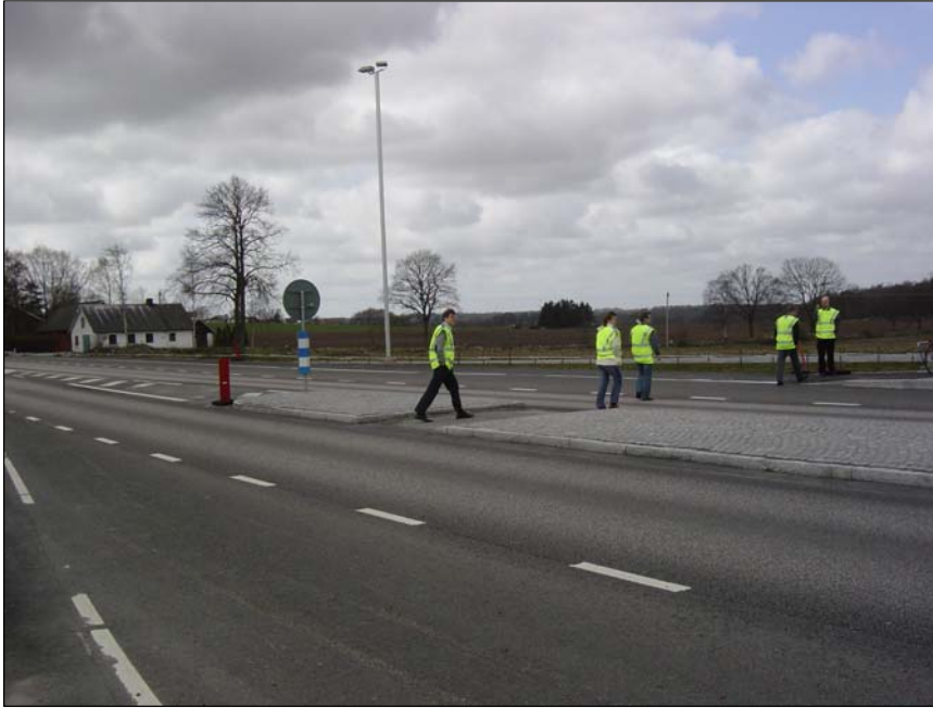
Kuva 4-17. Mastovalistus linja-autopysäkin ja kevyen liikenteen ylispaikan kohdalla
