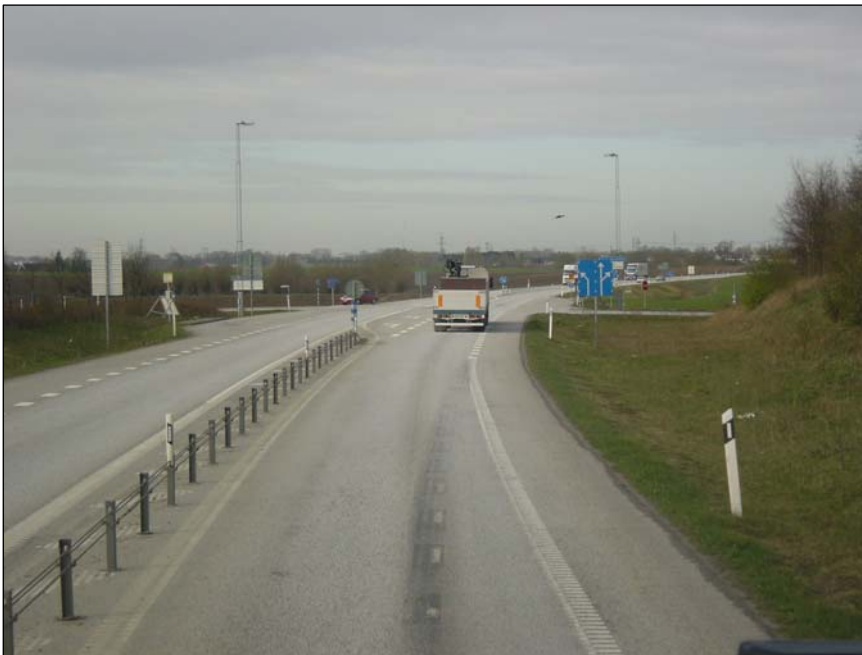
Kuva 4-1. Kanavoitu liittymä keskikaideosuudella. Keskikaidehankkeessa liittymään ei ole tehty erityisiä parannustoimia.
