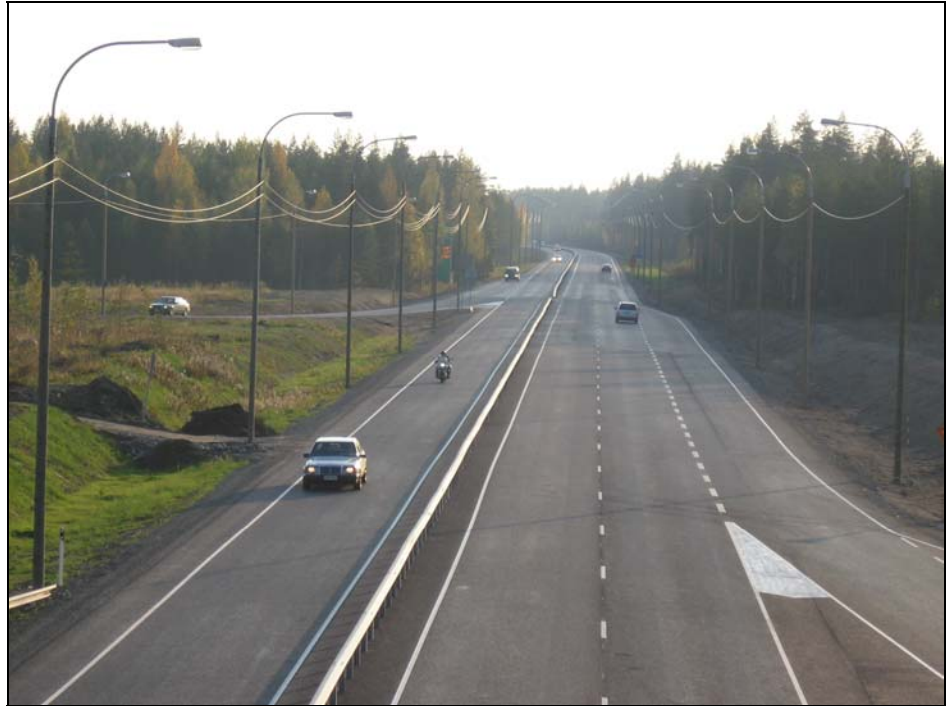
Kuva 6-5. Uuron eritasoliittymään ja sen eteläpuolelle on syksyllä 2007 valmistunut noin kahden kilometrin mittainen 2+1-kaistainen keskikaidetie, joka on tehty leventämällä ajorataa toispuolisesti. Vaihtoehtoisissa B, C1 ja C2 tämä osuus säilytetään ennallaan.
