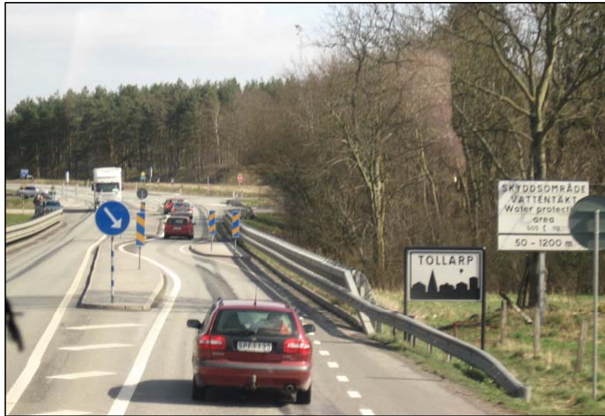
Kuva 4-9. Sivuttaissiirtymä tiellä E22 ennen Tollarpin taajamaa ja nelihaara-liittymää.
