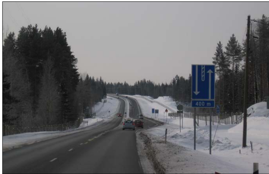
Kuva 3-6. Valtatie 13/15 välillä Haahkala - Porrassalmi. Keskikaiteellisella ohituskaistaosuudella on rinnakkaistie koko osuudella. Kuvassa ohituskaistan pohjoispää, jossa on kahvilayrityksen liittymä.
