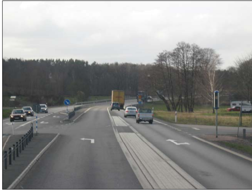
Kuva 4-12. Sivusuunnalta vasemmalle kuvassa näkyvälle päätielle kääntyville on oma kaista (vänstersväng) päätiellä vt 23 välillä Kristianstad–Hässleholm. Lisäkaista päättyy muutaman sadan metrin päässä liittymästä ja yhtyy oikeanpuoleiseen ajokaistaan. Liittymässä on myös automaattinen nopeusvalvonta.
