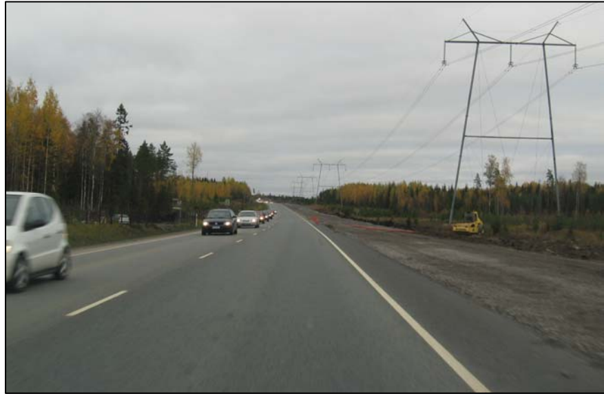
Kuva 3-5. Valtatie 9 Valkijärven kohdan keskikaiteellinen ohituskaista rakenteilla syksyllä 2006. Leventäminen 2+2-kaistaiseksi tieksi tehdään toispuoleisesti nykyisen ajoradan eteläpuolelle.
