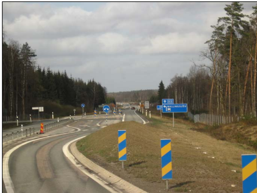
Kuva 4-9. Sivuttaissiirtymä tiellä E22 ennen Tollarpin taajamaa ja nelihaara-liittymää.
