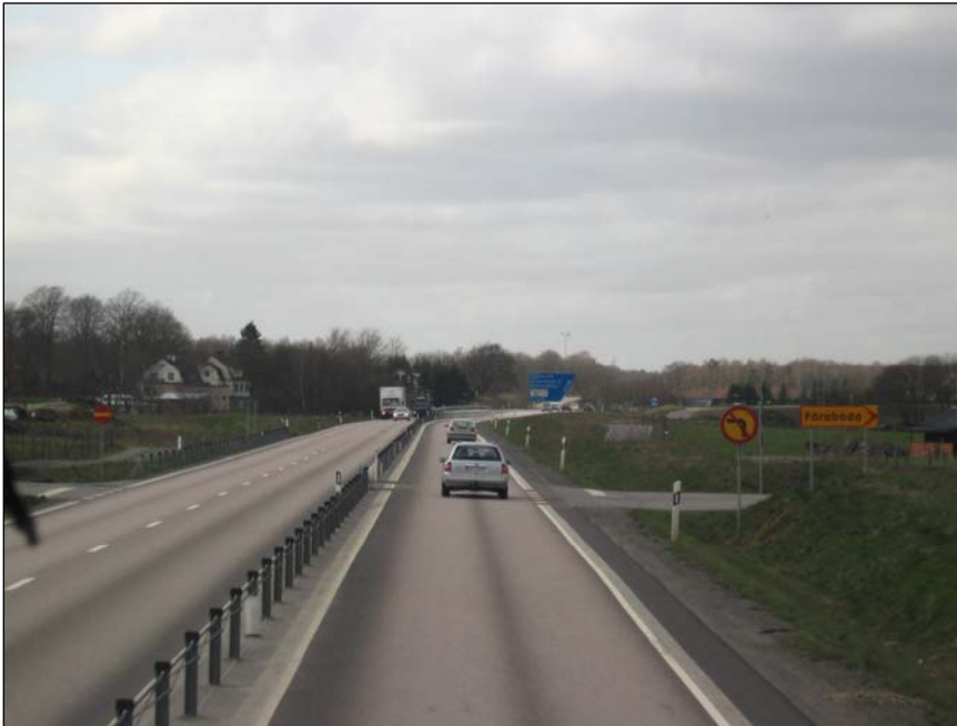
Kuva 4-14. Päätien tieylitys keskikaiteaukon avulla. Päätieltä yksityistielle saa kääntyä vain oikealle.
