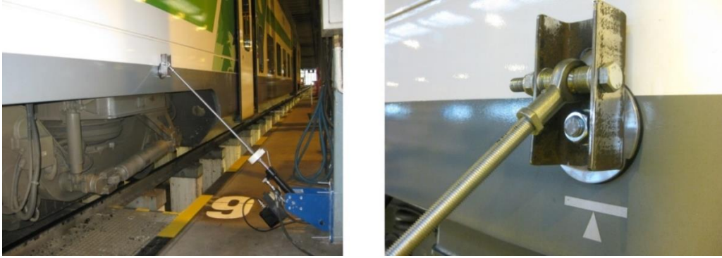
Kuva 6.4 Hydraulinen täristin ja voima-anturi. Täristin kiinnitettiin silta-nosturin teräspylväeseen kiinnitysraudoilla (vas.). Herätevoima vietiin vaunurunkoon vaunurungon nostotapin kautta (oik.).
